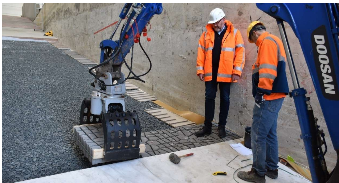
Figuur 3.3 Plaatsing van RONA ® ton XL op het filter met minikraantje met sorteerknipper (zie ook Fig. E-3)
