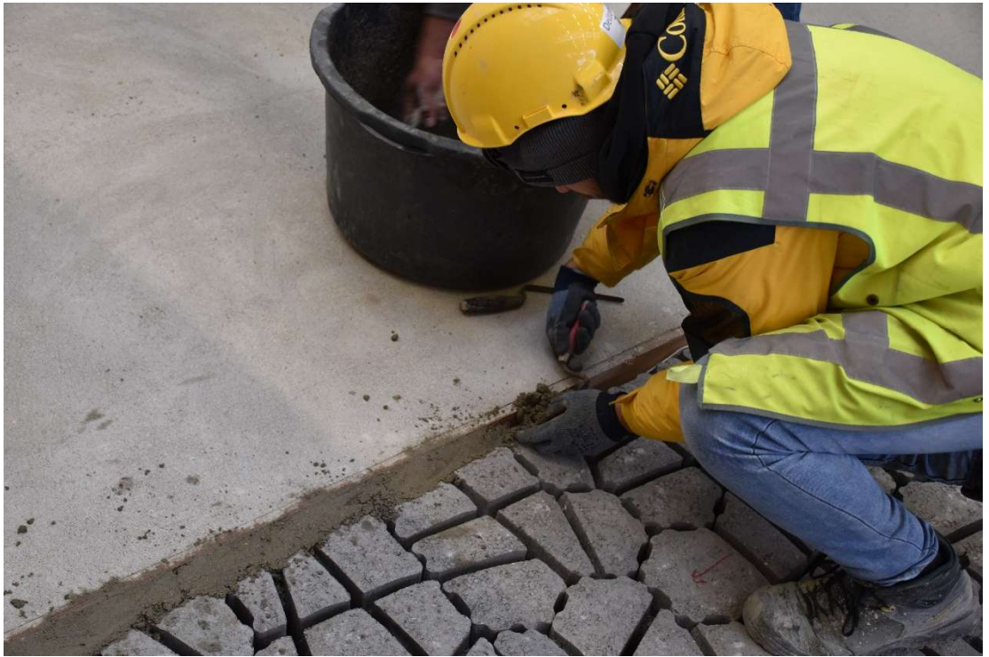
Fig. E-5, Het opvullen van de spleet tussen de steenzetting en het boventalud met zandcement
