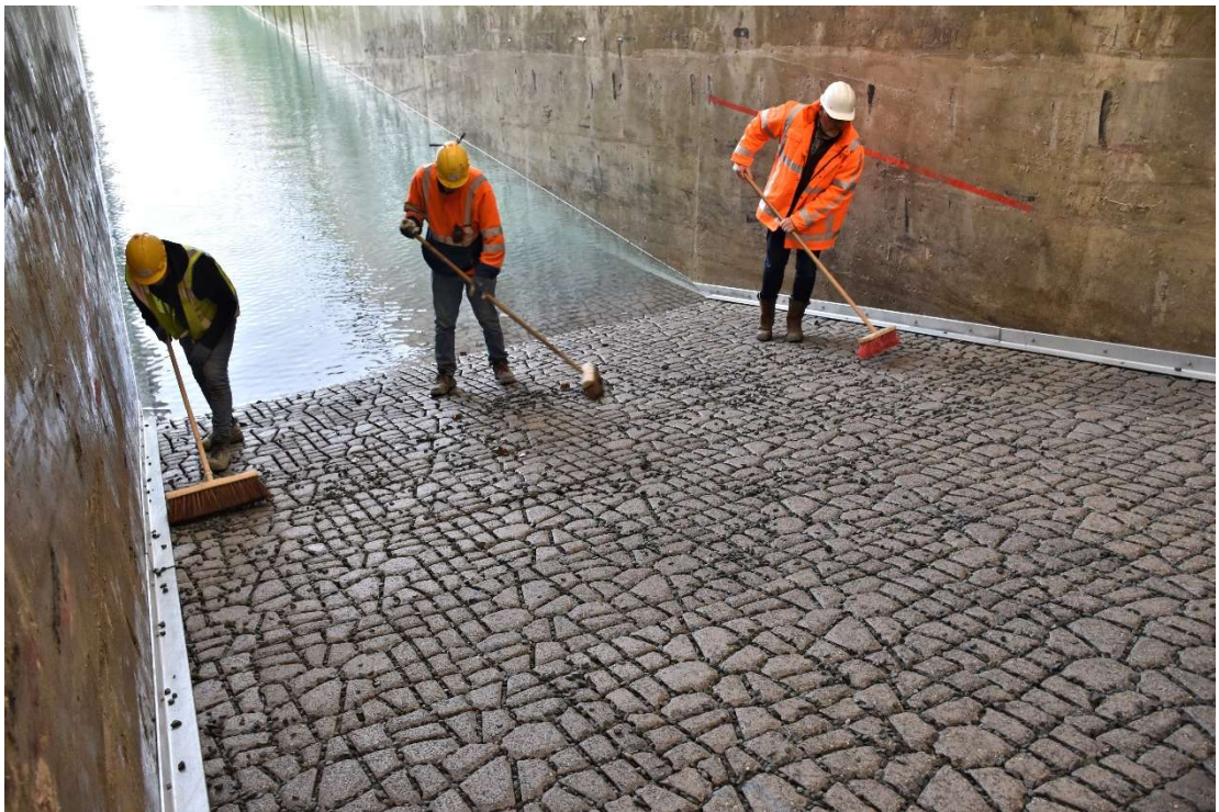
Fig. E-11, Inwassen na proef RXL-03
