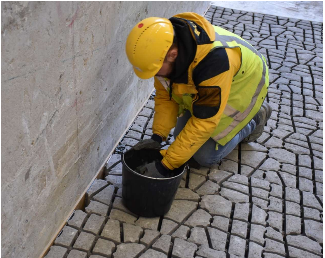
Fig. E-6, De ruimte tussen de zetstenen en het rubber is opgevuld met vulplaatjes en de overgebleven openingen tussen de zetstenen en het rubber is opgevuld met steenslag
