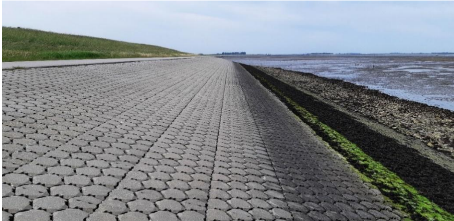
Figuur 2.2, Rechte lijnen in de dijkbekleding vanwege het werken met sets van gelijke grootte
