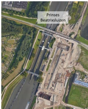
Figuur 2-5: Overzicht van Prinses Beatrixsluizen bij Nieuwegein. Bron satellietbeeld: Google Earth
