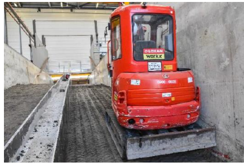
Verdichten van de klei met rupskraan
