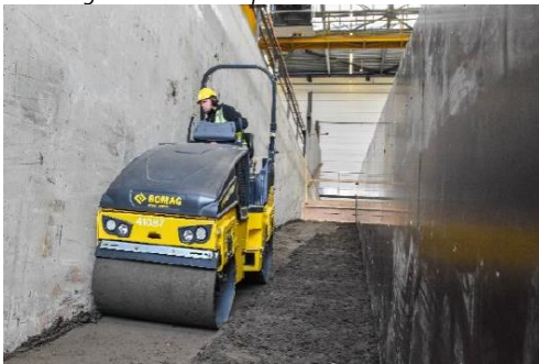
Verdichten van de klei met wals
