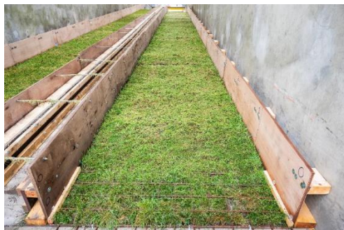
Opgebouwde Deltagoot (onderste deel met wapeningsnet ter stabilisatie)
