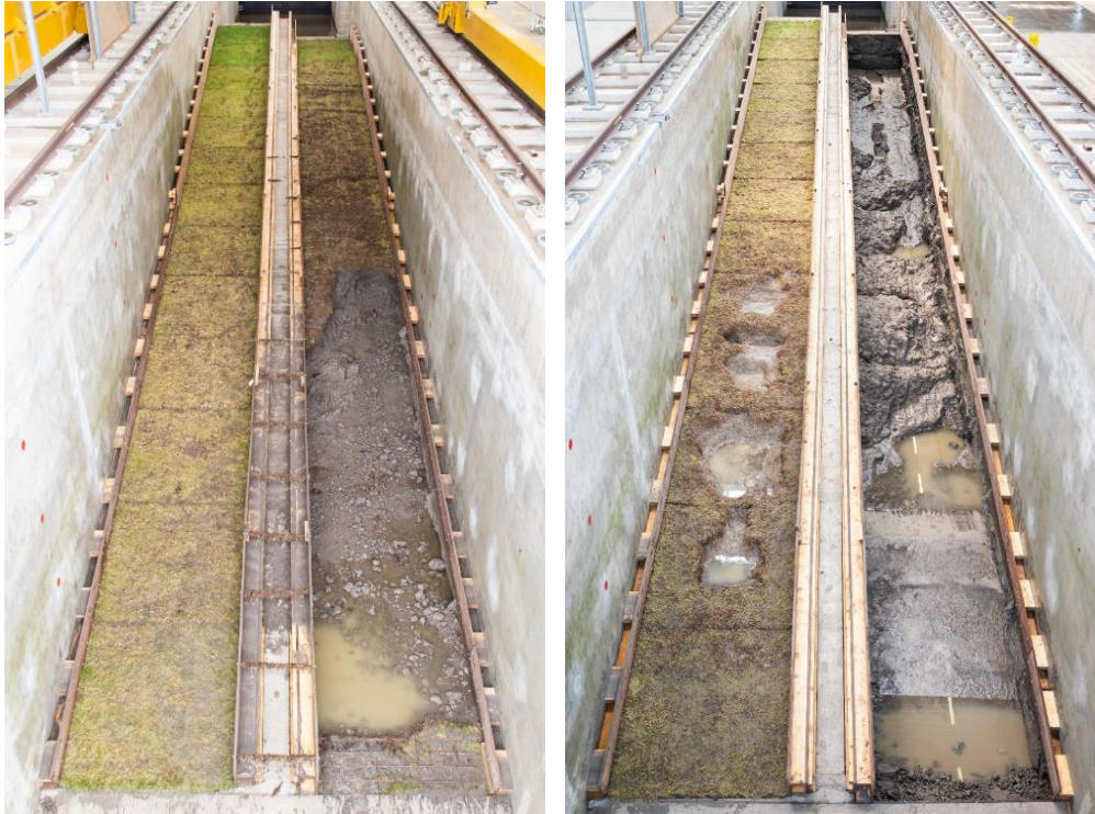
Erosiekuil aan Dollardzijde na 12 uur
