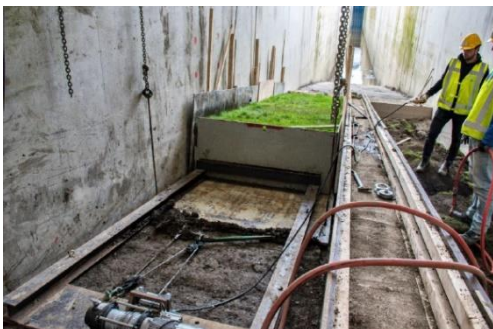
Trekken van de bodemplaat
