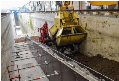
Aanbrengen van de Klutenplasklei
