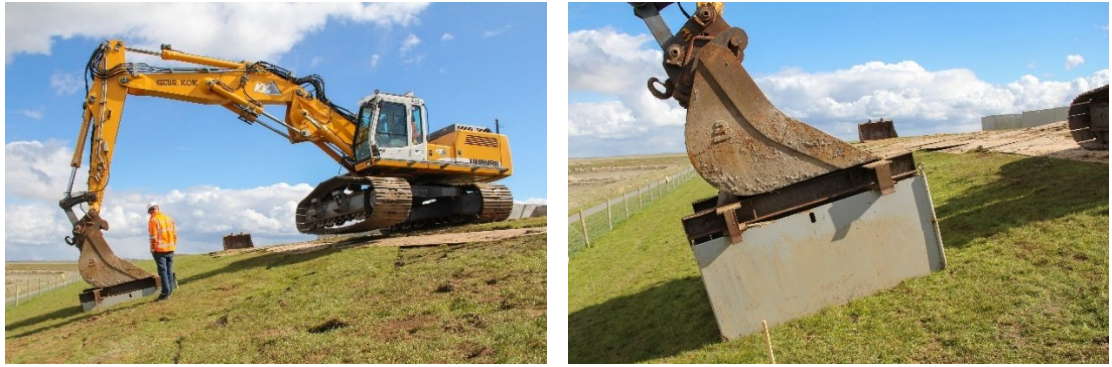
Figuur 2.6 Drukken van de zijwanden van de mal in het taludoppervlak.
