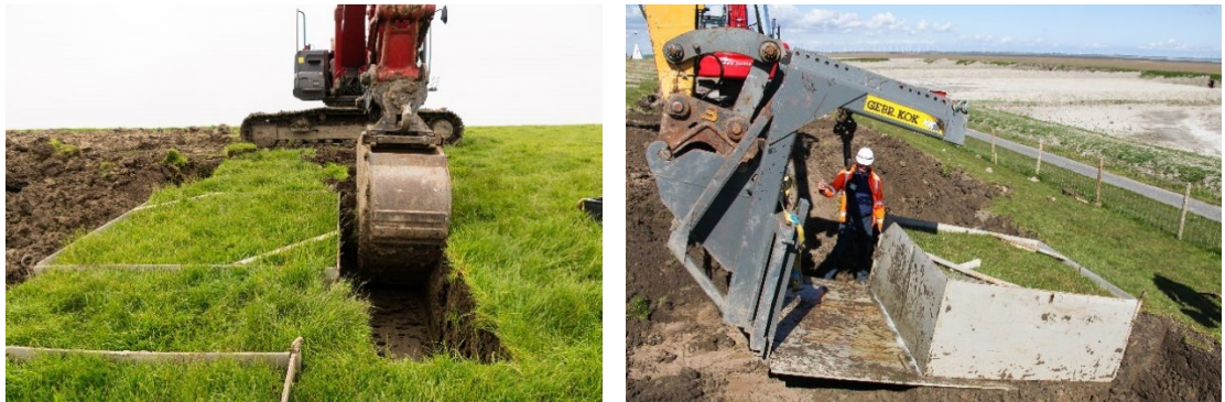
Figuur 2.7 Ontgraven van de gedrukte mal (links) en het eronder schuiven van de bodemplaat (rechts)
