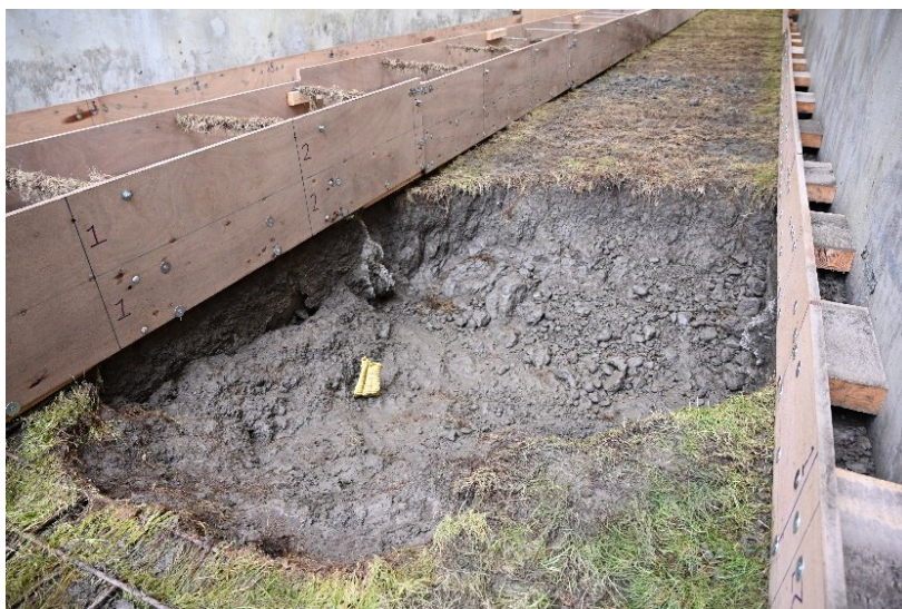
Figuur 2.9 Erosiekuil na proef B2_06 (na totaal 6,83 uur golven)
