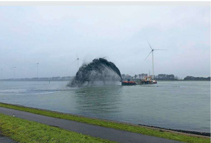
■ Een baggerschip spuit het slib over de langsdam van kribvak 9. (FOTO: RIEN VREUGDENHIL)
