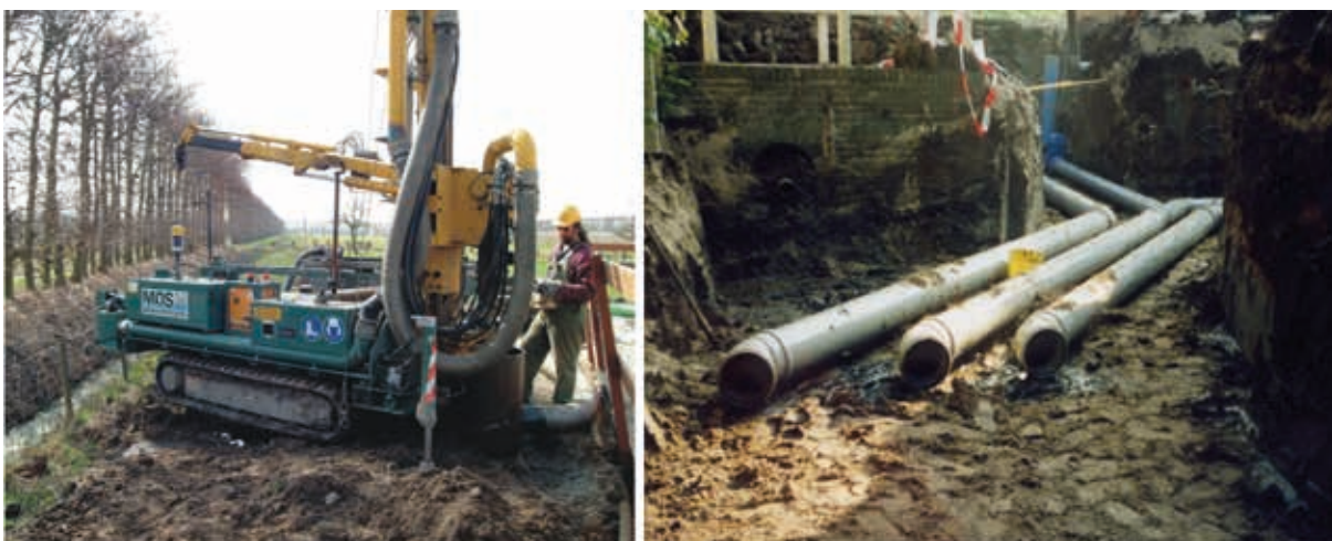
Figuur 6.1 Links: plaatsen verticale bron (foto: Mos); rechts: aanleg verzamelleidingen in Jaarsveld (foto: HDSR)
