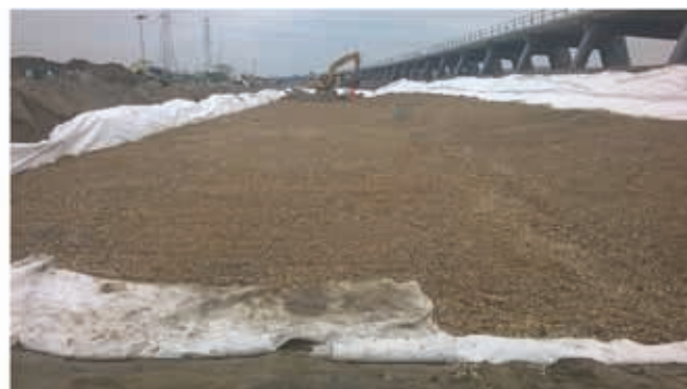
Figuur 6.3 Installeren grindkoffer bij Project Hoogwatergeul Veessen-Wapenveld, Combinatie IJsselweide (Boskalis en Van Hattum en Blankevoort)
