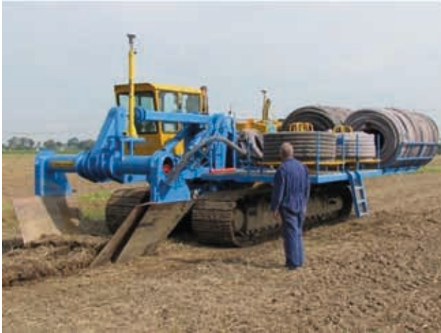
Figuur 6.2 Links: aanbrengen drainage via v-ploeg (foto Barth drainage); rechts: aanbrengen drainage kettinggraver (foto: Boersma drainage)
