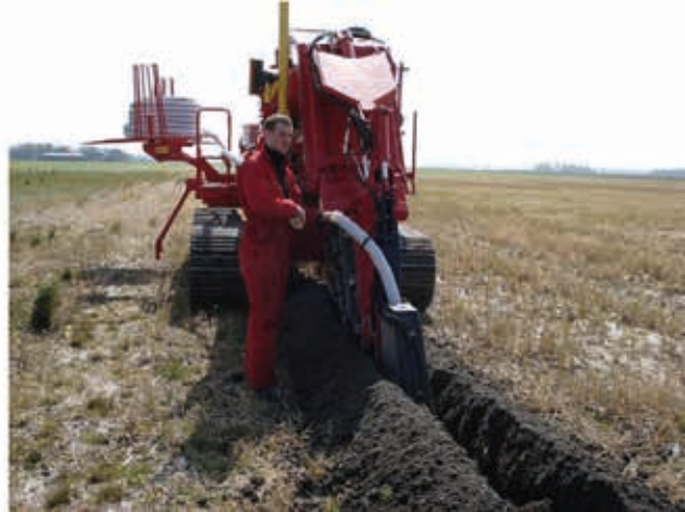
Figuur 6.2 Links: aanbrengen drainage via v-ploeg (foto Barth drainage); rechts: aanbrengen drainage kettinggraver (foto: Boersma drainage)
