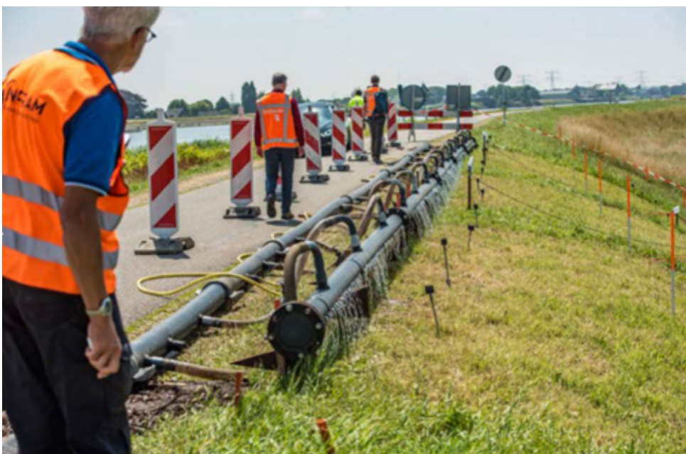
Figuur 2.3 Infiltratieproef als proefbelasting op de Groenendijk te Nieuwerkerk aan den IJssel
