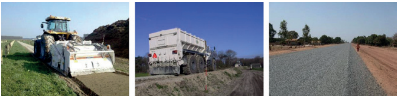
Figuur 9.2 Aanbrengen en verdichten van stabiliteitslagen
