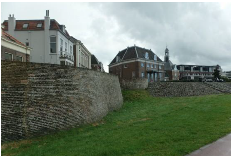
Figuur 2.2 Gemetselde keermuur die zorgt voor de buitenwaartse macrostabiliteit in de buitenkruin van de dijk bij Tiel
