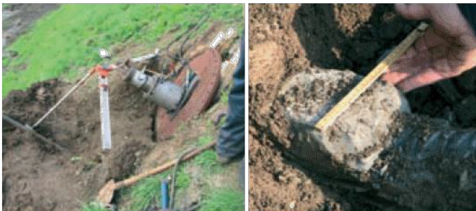
Figuur 7.5 Proefopstelling trekproeven en gedeeltelijk ontgraven nagel
