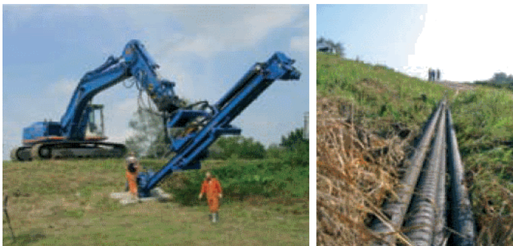
Figuur 7.2 Materieel Dijkvernageling en nagels (staal)
