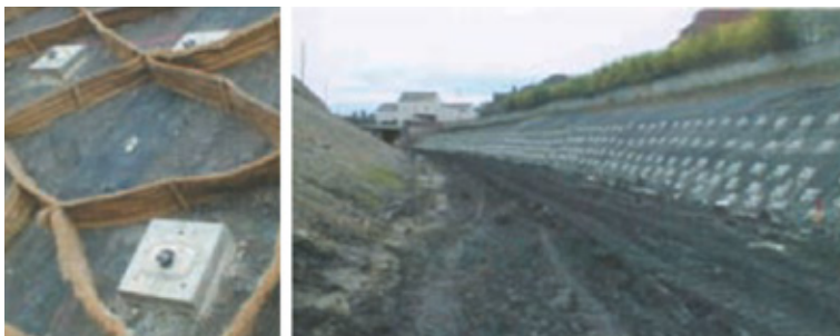
Figuur 2.3 Verankering van de nagels met facing. Toepassing bij spoorbaan Sunderland (UK)
