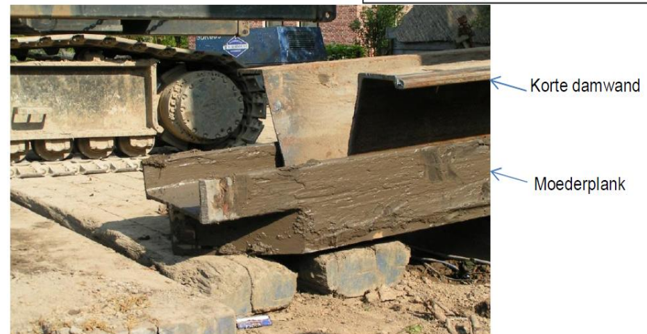
Figuur 16.4 Illustratie moederplank met PU-profiel en detailtekening hydraulische klemsysteem (rechts boven)
