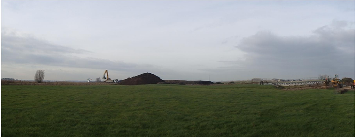
Figuur 3.3 Impressie van proeflocatie voorafgaand aan de aanleg- en opbouwfase
