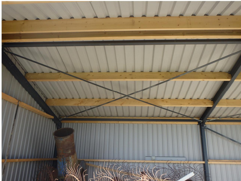
Figuur D.9: Close-up zuidoostelijk deel van dakconstructie schuur
