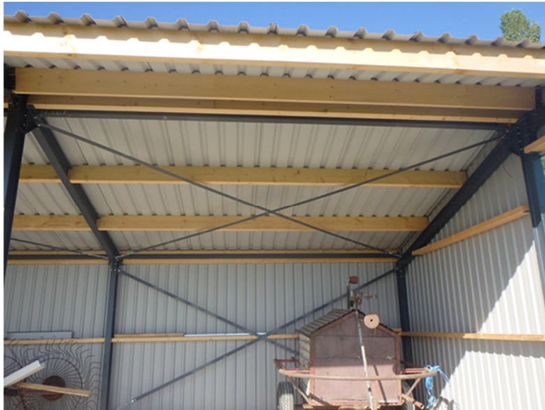
Figuur D.8: Close-up noordwestelijk deel van dakconstructie schuur
