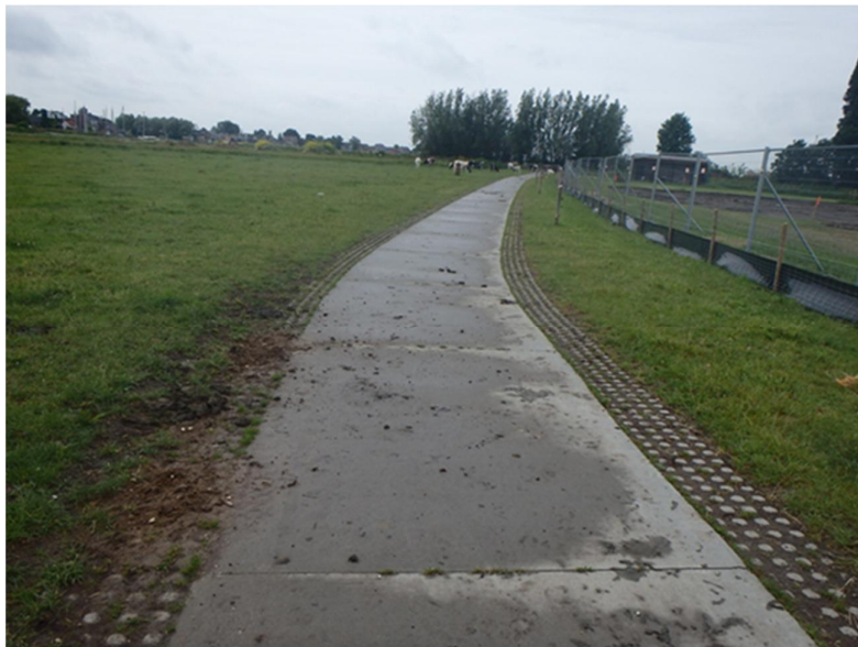
Figuur D.12: Noordkant Jaagpad (genomen richting zuidwesten)
