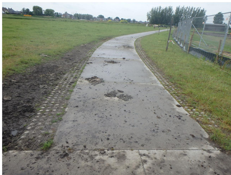
Figuur D.11: Noordkant Jaagpad (genomen richting zuidwesten)
