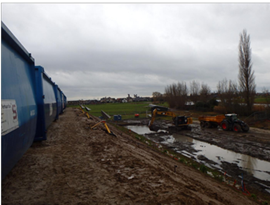
Foto 3.2 Aanvang ontgraving tot NAP -0,90 m over 7 m breedte (slag 2)
