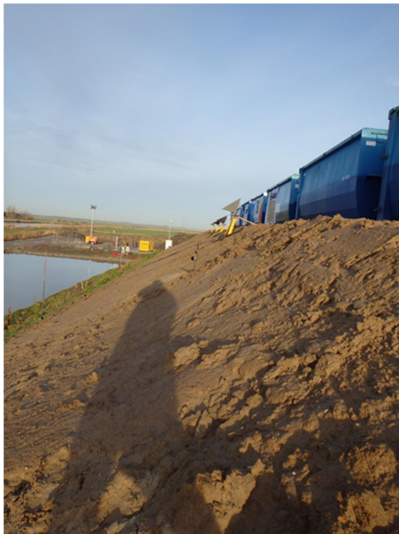
Foto 3.23 Positionering prisma's boven in talud aan ontgravingszijde (vullen containers)
