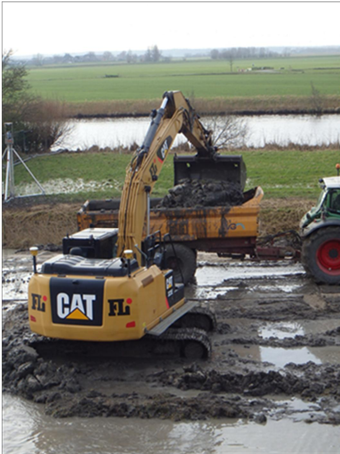
Foto 3.9 Ontgraven slappe klei bij verbreden ontgraving over 6 m tot NAP - 1,50 m (slag 4)
