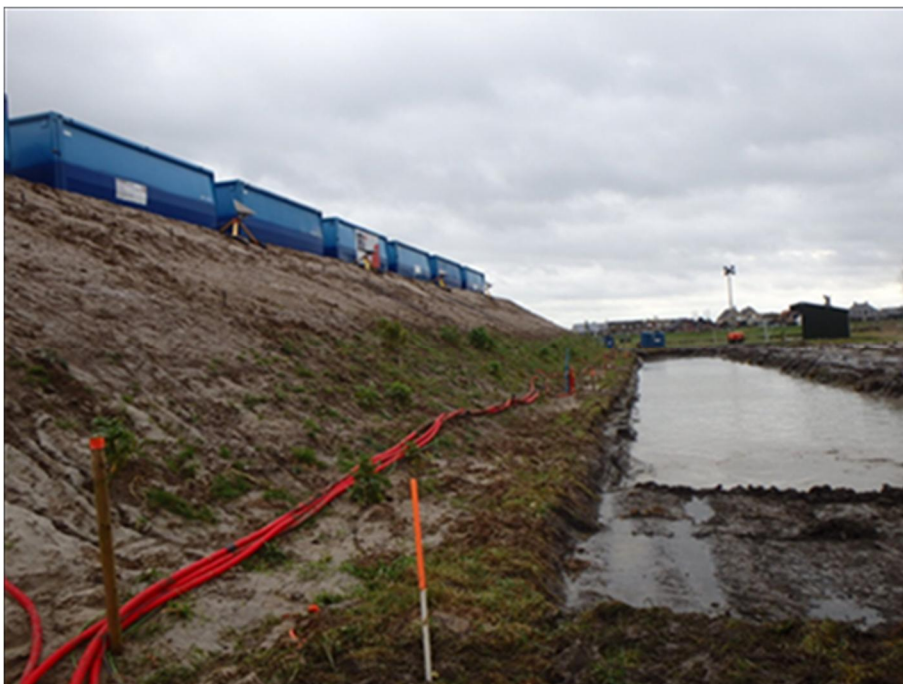
Foto 3.3 Afronding ontgraving tot NAP -0,90 m over 7 m breedte (slag 2)
