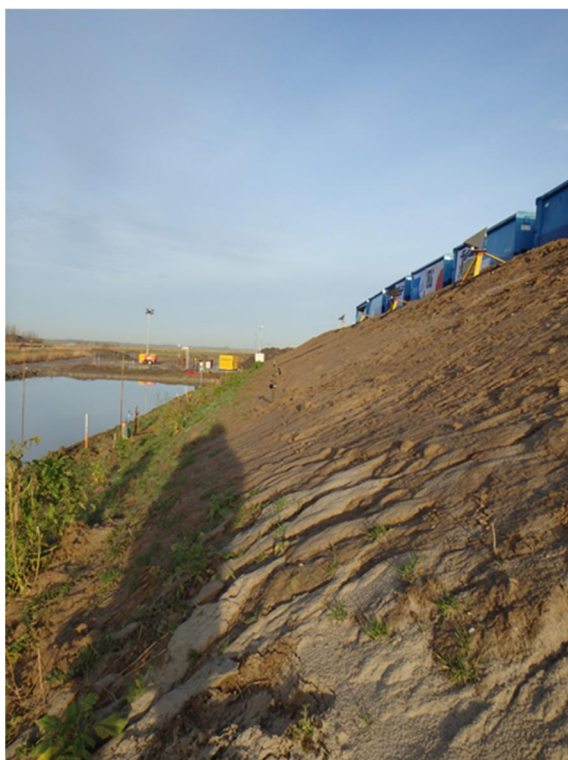
Foto 3.24 Positionering prisma's boven in talud aan ontgravingszijde (vullen containers)
