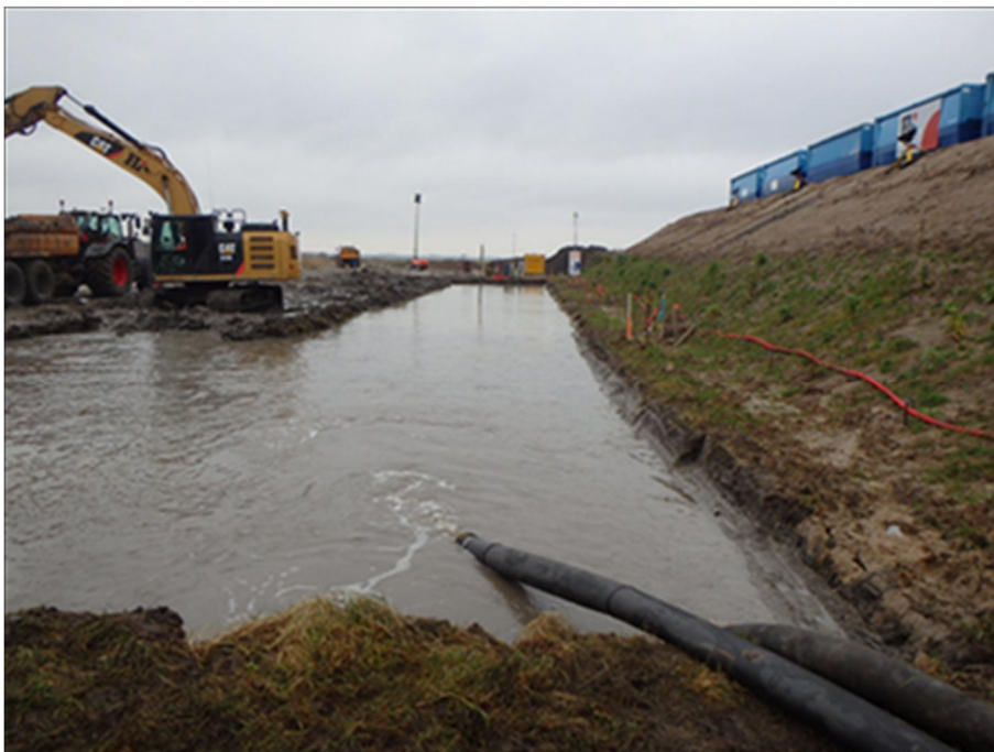
Foto 3.8 Aanzetten tweede pomp t.b.v. voldoende oprijfveiligheid (slag 4)
