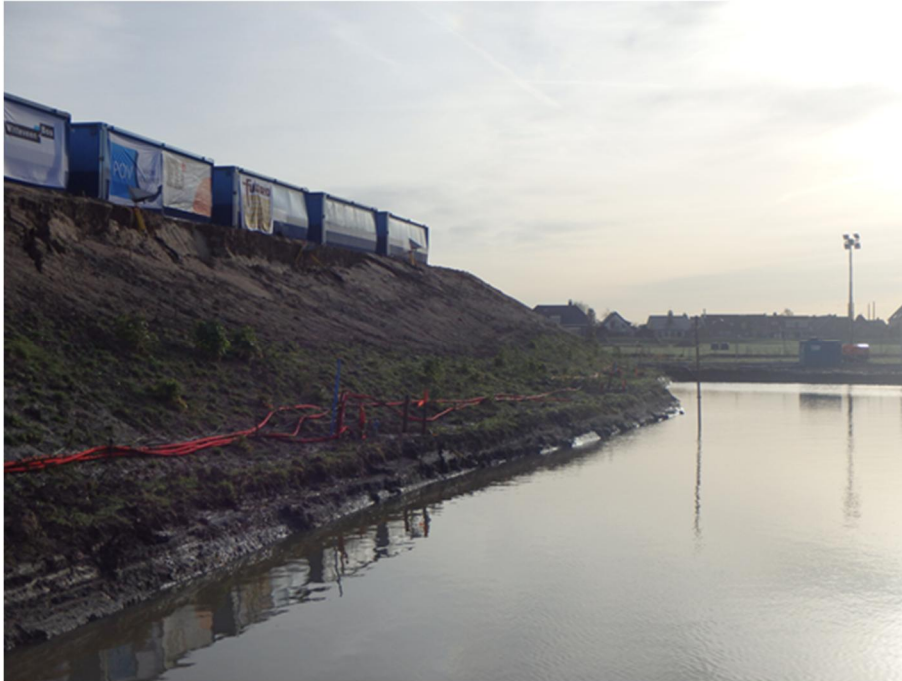
Foto 3.29 Ontwikkeling ondiep glijdvak na scheurvorming kleibekleding
