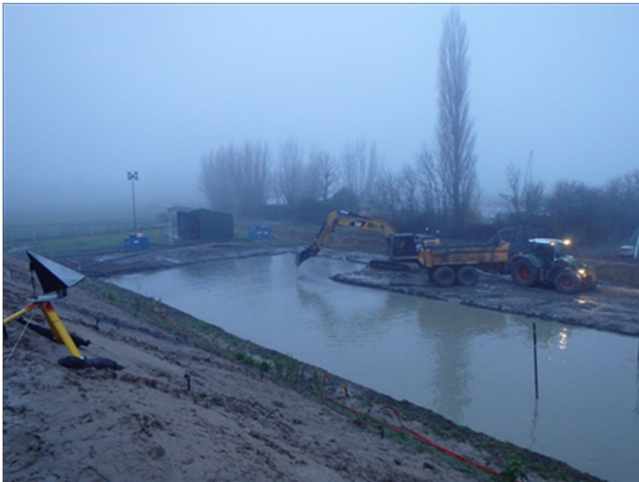
Foto 3.11 Verbreden ontgraving over 7 m tot NAP - 1,50 m (slag 5)
