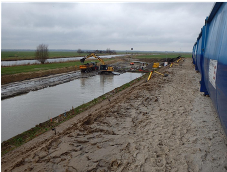
Foto 3.10 Einde verbreden ontgraving over 6 m tot NAP - 1,50 m (slag 4)
