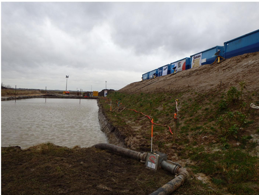
Foto 3.14 Locatie zakkbakens t.b.v. waterpassing bodemniveau ontgraving
