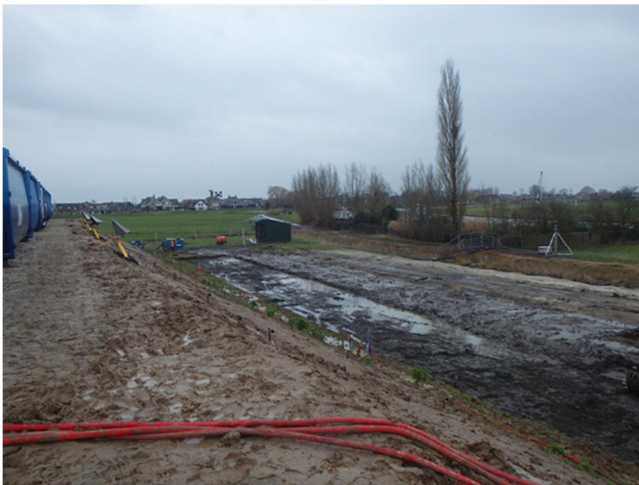
Foto 3.1 Situatie na verwijderen toplaag (slag 1)
