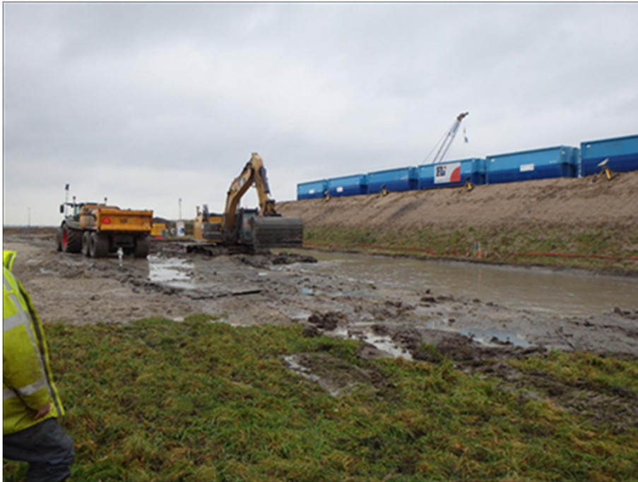
Foto 3.7 Verbreden ontgraving over 6 m tot NAP - 1,50 m (slag 4)
