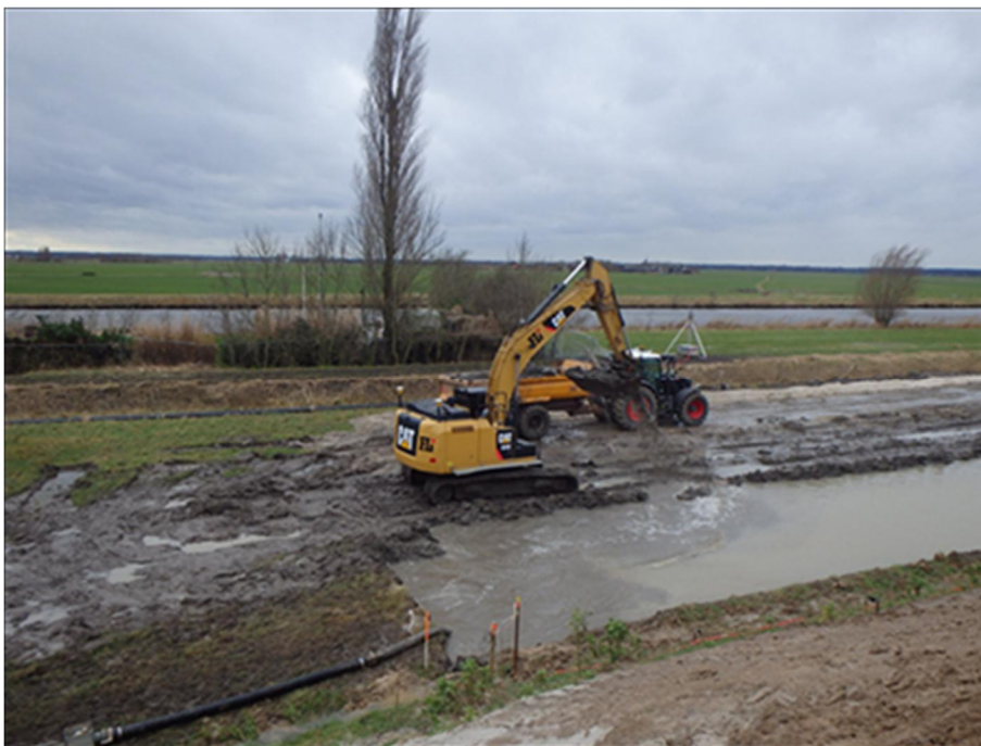
Foto 3.5 Aanbrengen ontgraving tot NAP - 1,50 m over 7 m breedte (slag 3)
