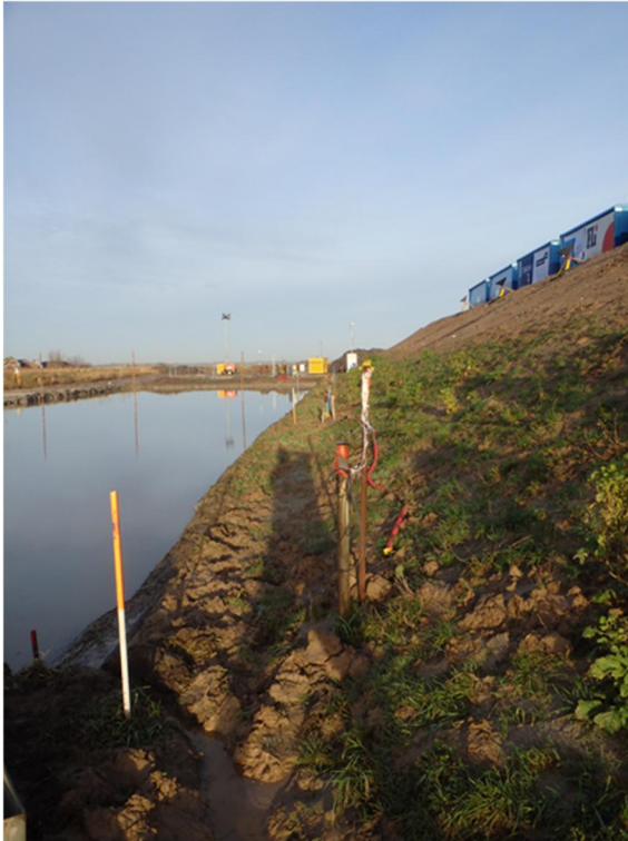
Foto 3.25 Positionering prisma's boven in talud aan ontgravingszijde (vullen containers)
