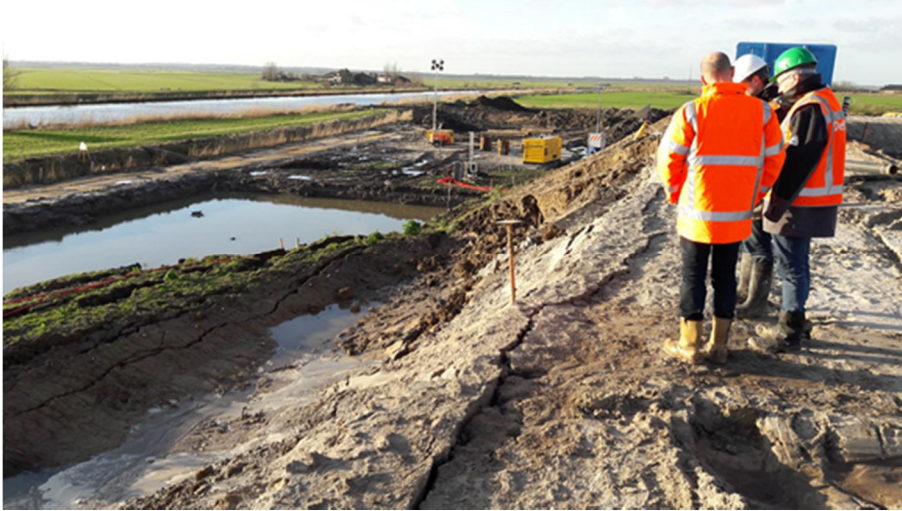
Foto 3.31 Eindresultaat ondiep glijdvlak bij groene proefdijk
