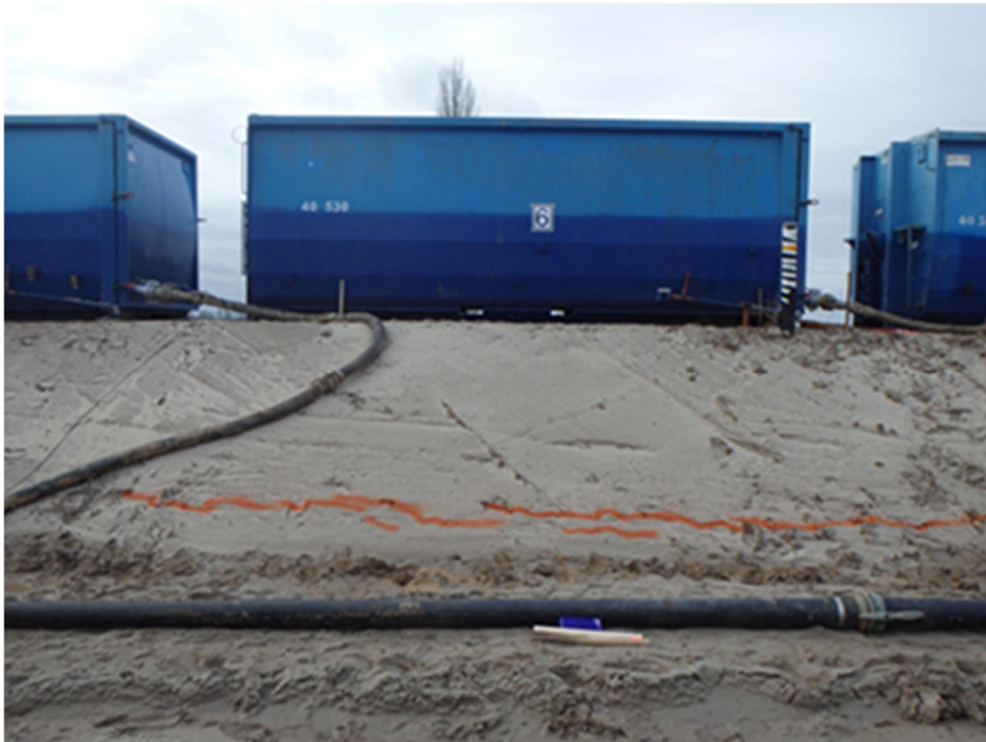
Foto 3.17 Scheuren in talud aan waterbassin-zijde van container #6 (infiltratie tot NAP + 2,50 m)
