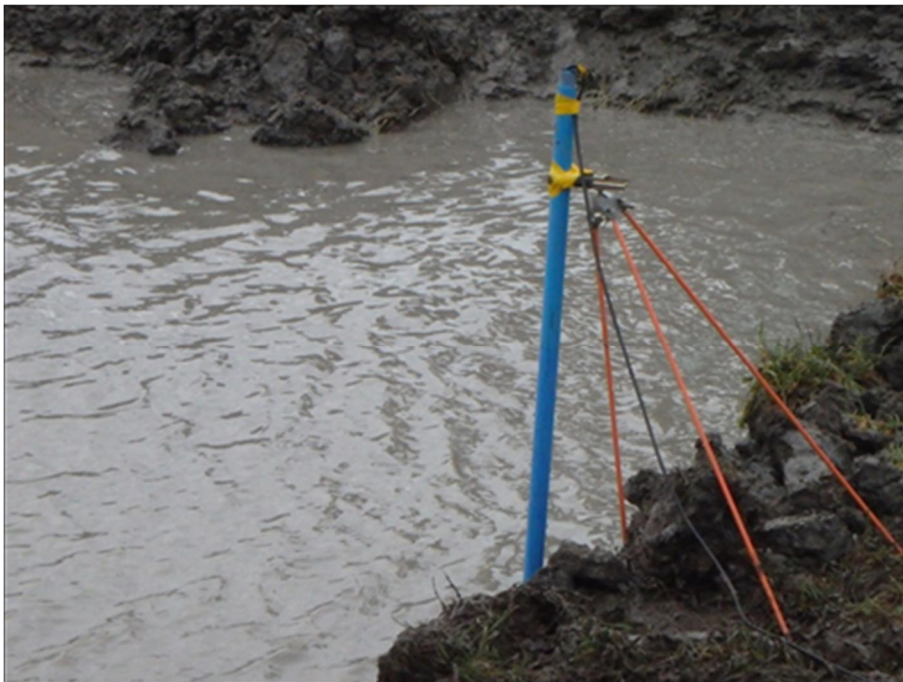
Foto 3.4 Geïnstalleerde BH FWZGMI juist na maken ontgraving tot NAP - 0,90 m (slag 2)
