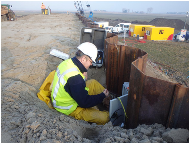
Foto 4.11 Reparatie junction boxes op meetplanken blauwe proefdijk
