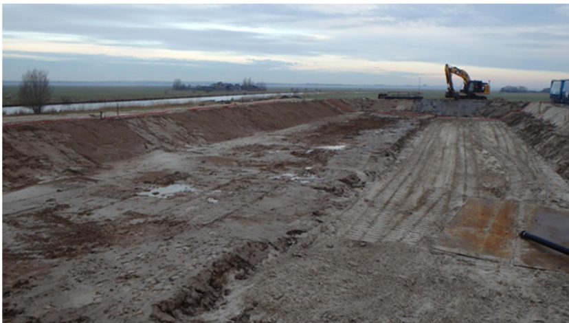
Foto 4.10 Aanbrengen kleibekleding op bodem waterbassin (aan zijde groene dijk) en langs taluds
