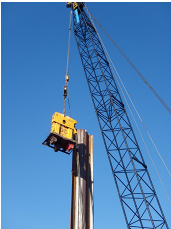
Foto 4.5 Op kop van GÜ8N-triplet plaatsen van 16VM-trilblok met drievoudige klem
