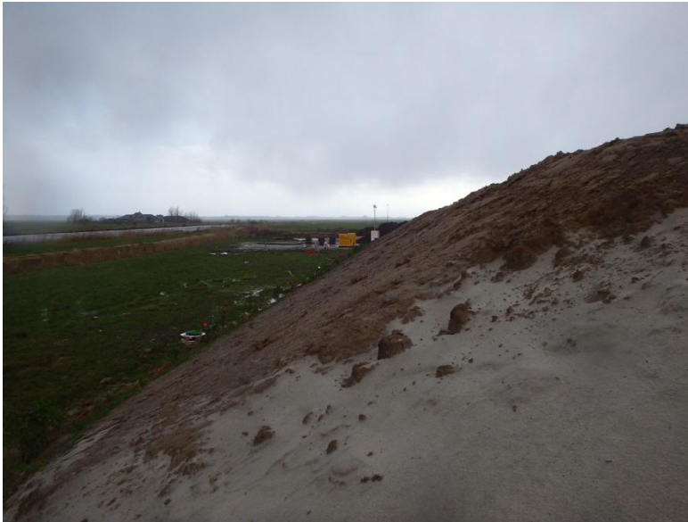
Foto 3.3 Kleibekleding op het binnentalud
