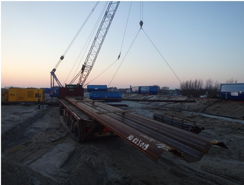
Foto 4.2 Aanvoer (geïnstumenteerde) damwandplanken met kar
