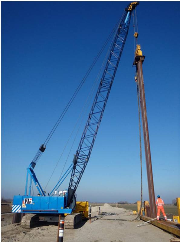
Foto 4.6 Positioneren van damwandplank met trilblok in heftrame
