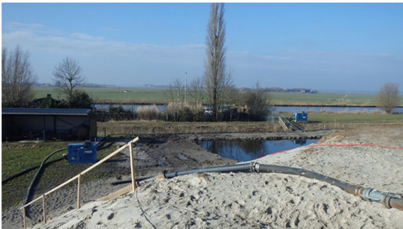
Foto 4.14 Locaties pompen tbv vullen ontgraving (rechts) en vullen buffercontainer (links) bij aanvang proef
