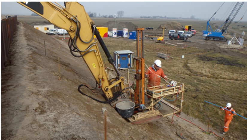
Foto 4.18 Detail van aanbrengen monitoringsinstrumenten in talud van blauwe proefdijk
