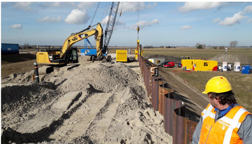
Foto 4.9 Op hoogte brengen van kruin blauwe proefdijk mbv zand heiplatform
