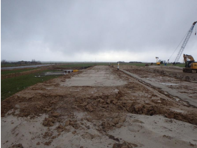
Foto 3.1 Aanbrengen kleibekleding op taluds testdijk en bodem bassin
