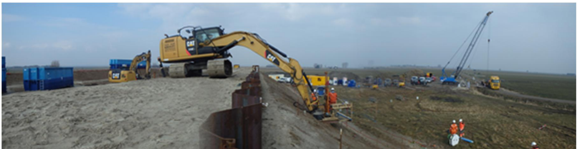
Foto 4.17 Werkwijze aanbrengen monitoringsinstrumenten in talud van blauwe proefdijk
