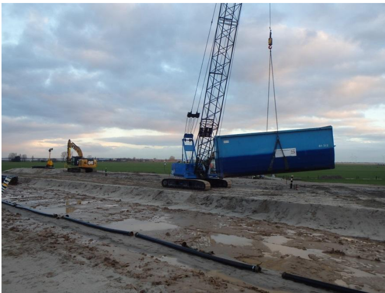
Foto 3.2 Plaatsen van de containers op groene proefdijk met de draadkraan
