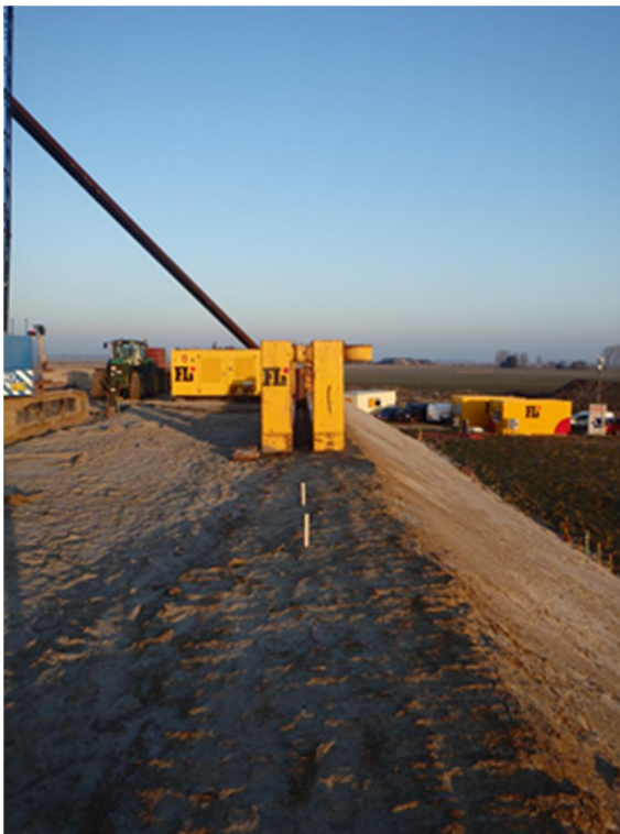
Foto 4.1 Heigording tbv plaatsvastheid damwandplanken tijdens installatie
