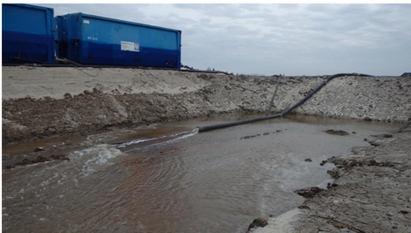
Foto 4.14 Start infiltratie zandkern dijk tot NAP +4,20m via vullen waterbassin (stap 6)
