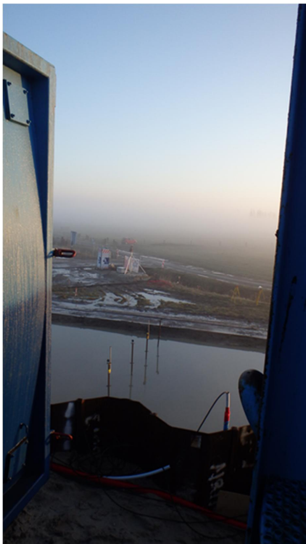
Foto 4.10 Zakbaken met meetprisma na afronden verbreding met 8 m ontgraving tot NAP -2,00 m (stap 4)
