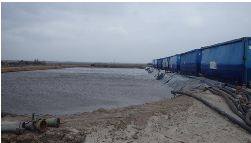
Foto 4.21 Infiltreren zandkern dijk tot NAP +5,00 m middels vullen van waterbassin (stap 9)
