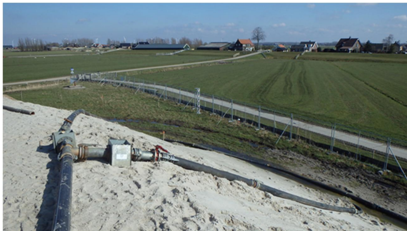
Foto 4.11 Open zetten infiltratievoorziening zandkern blauwe dijk (stap 6)
