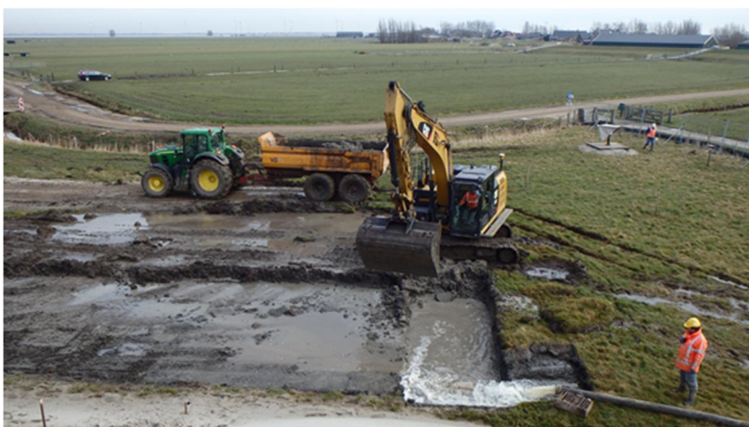
Foto 4.3 Aanvang ontgraving tot NAP -0,90 m over 7 m breedte, inclusief pomp (stap 2)
