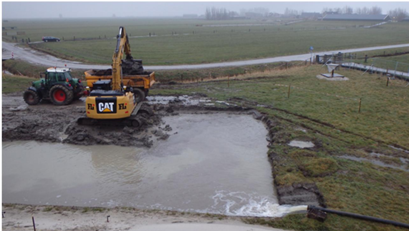
Foto 4.7 Verbreden ontgraving tot NAP - 2,00 m over 8 m breedte (stap 4)
