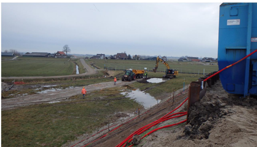
Foto 4.1 Situatie bij start verwijderen toplaag (stap 1)
