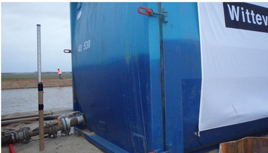
Foto 4.17 Waterpassing kruinhoogte via inmeten paal tussen containers (vanaf groene dijk)
