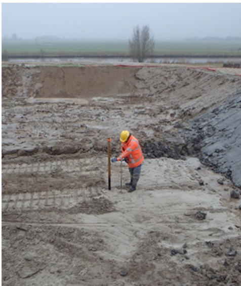
Foto 4.6 Installatie peilschaal aan noordkant zandbodem van waterbassin
