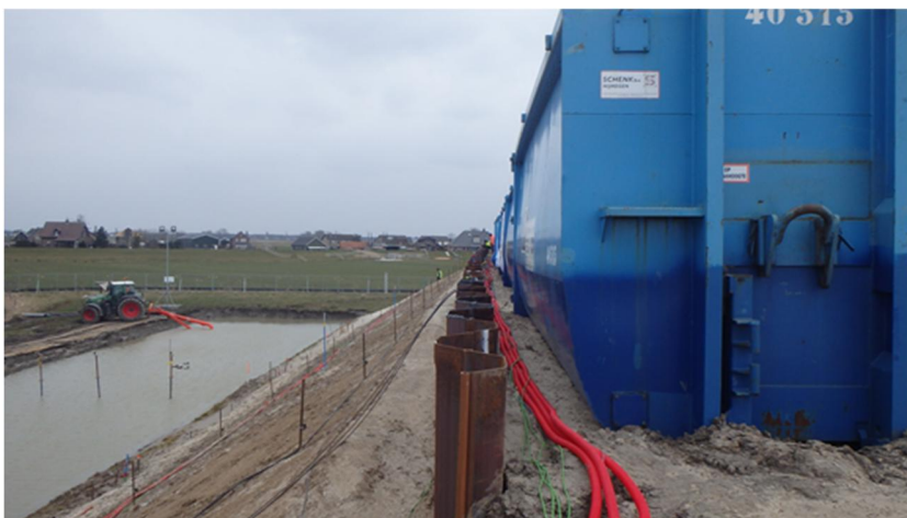
Foto 4.27 Start leegpompen ontgraving middels trekkerpomp tot NAP -0,90 m (stap 11)
