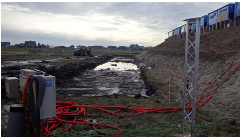
Foto 4.2 Situatie na afronding verwijderen toplaag (stap 1)
