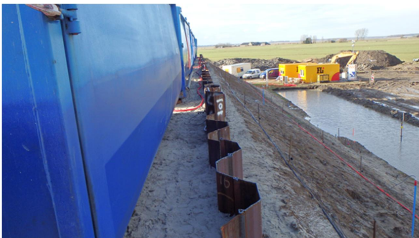
Foto 4.5 Zakbaak met meetprisma na afronden ontgraving tot NAP -2,00 m over 7 m breedte (stap 3)
