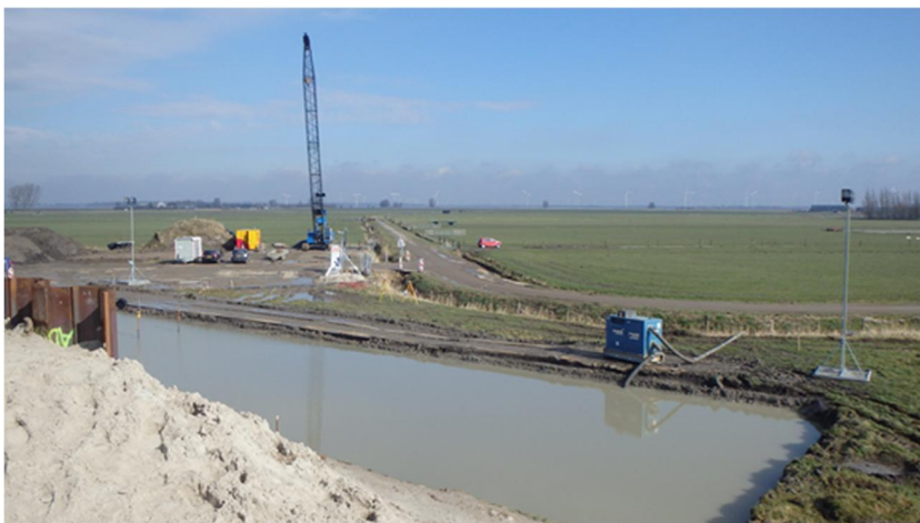
Foto 4.9 Pomp ontgraving bij aangepaste opstelling parallel geschakelde pompen
