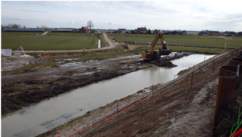
Foto 4.4 Aanvang ontgraving tot NAP -2,00 m over 7 m breedte (stap 3)
