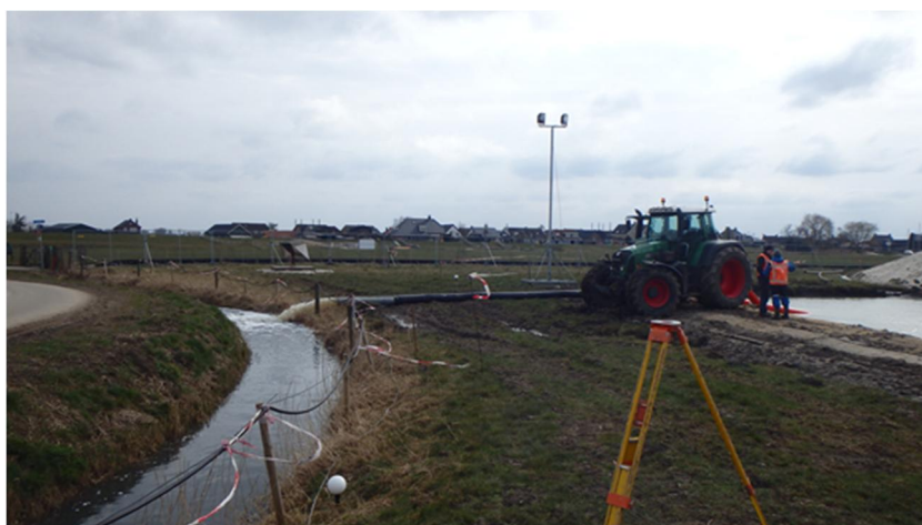
Foto 4.24 Start leegpompen ontgraving middels trekkerpomp tot NAP -0,40 m (stap 11)
