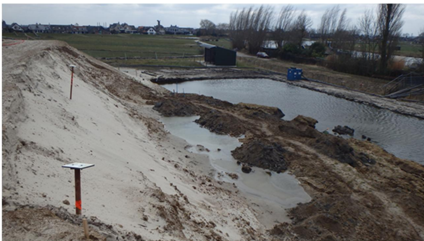
Foto 4.22 Visuele controle van bezwijkvlak groene dijk ivm oplopen waterpeil in zandkern (boven)
