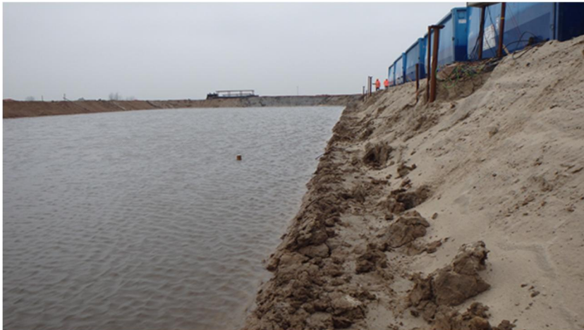
Foto 4.15 Infiltratie zandkern dijk tot NAP +4,20m via vullen waterbassin (stap 6)
