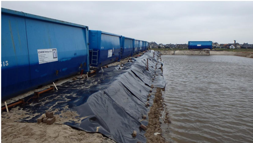
Foto 4.20 Met geotextiel afgedekte talud waterbassin ter voorkoming van afkalven
