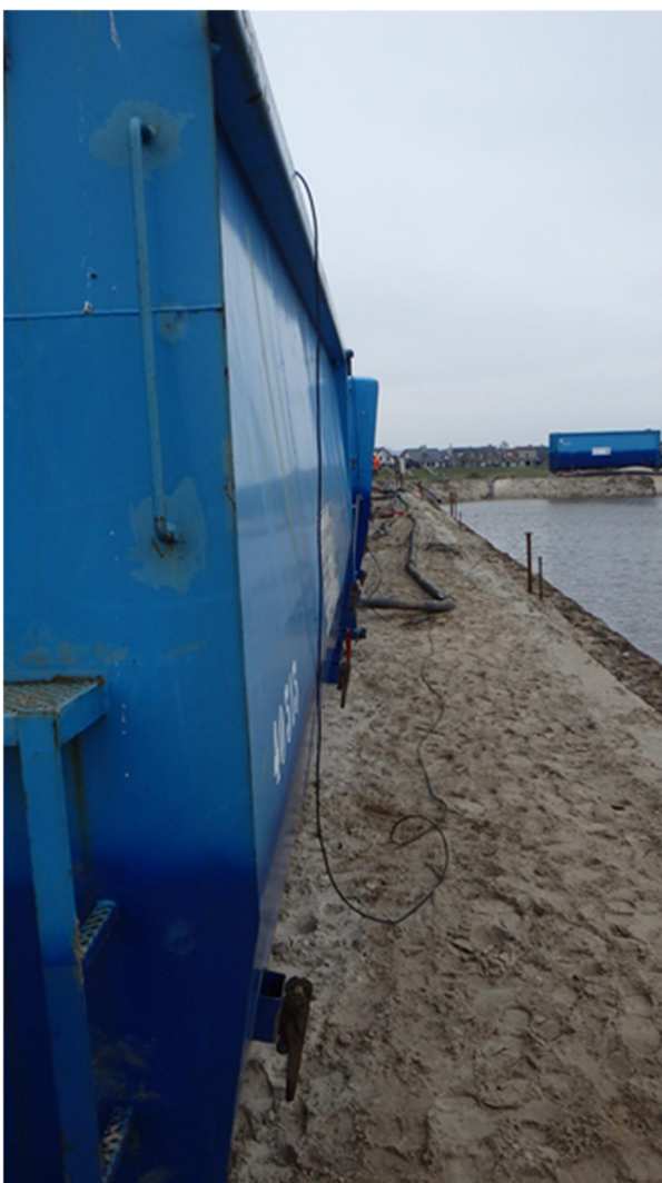
Foto 4.19 Scheefzakken tijdens opvoeren belasting containers (stap 7)
