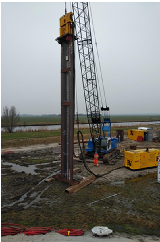
Afbeelding 2.6: Installatie damwandplank (GU8N-rev triplet)
