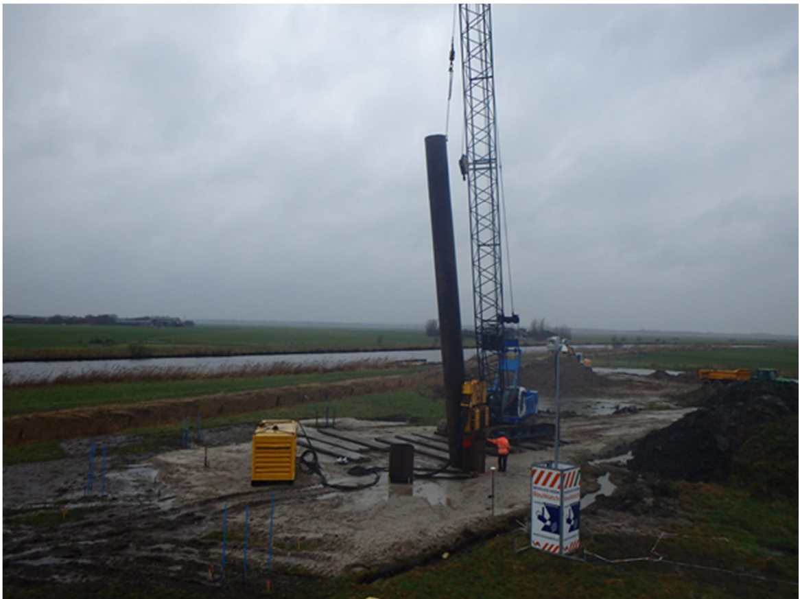
Afbeelding 2.1: Installatie buispalen
