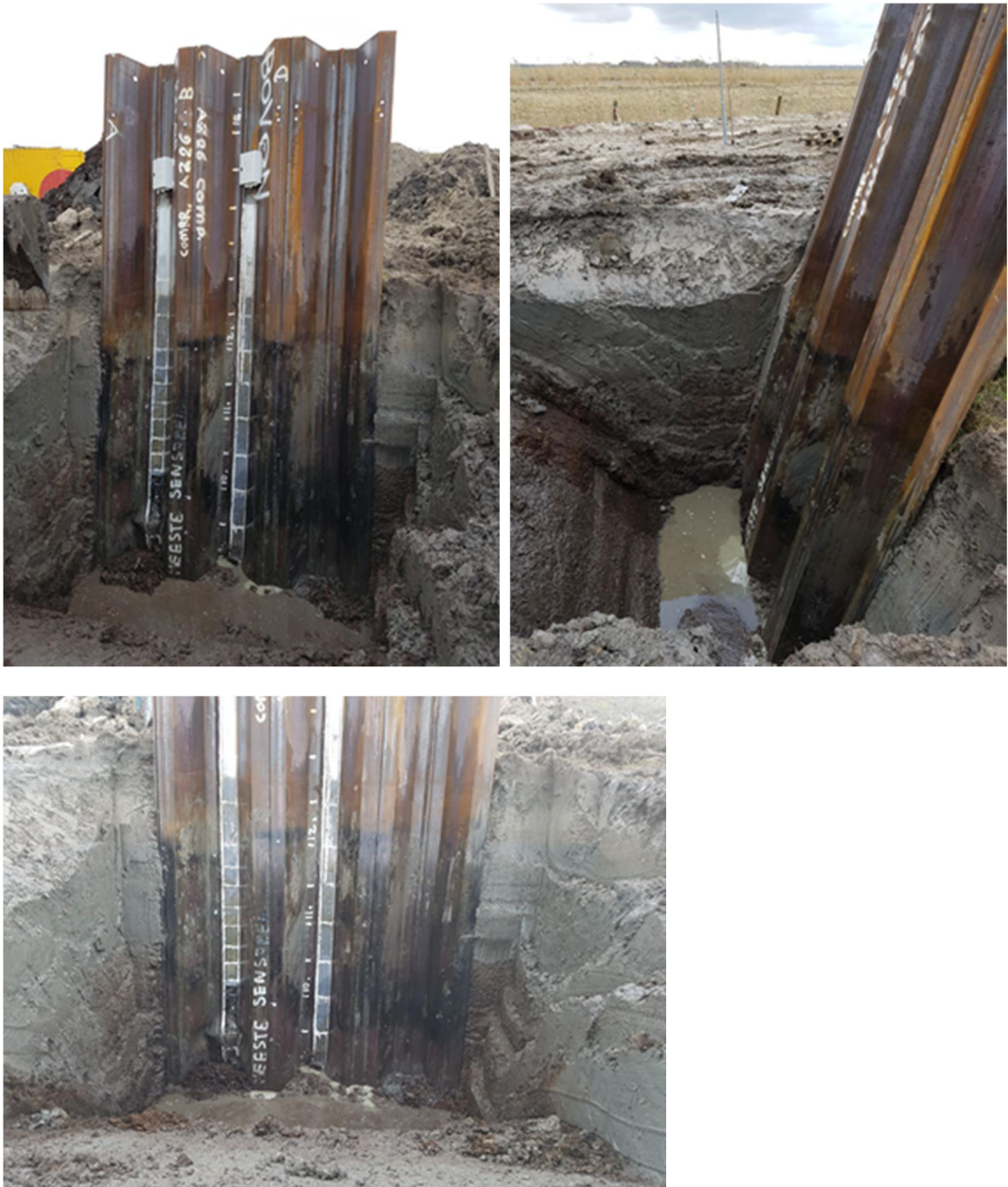
Afbeelding 4.3 : Ontgraving AZ26-700 (foto's genomen vanaf de achterkant van de damwand)
