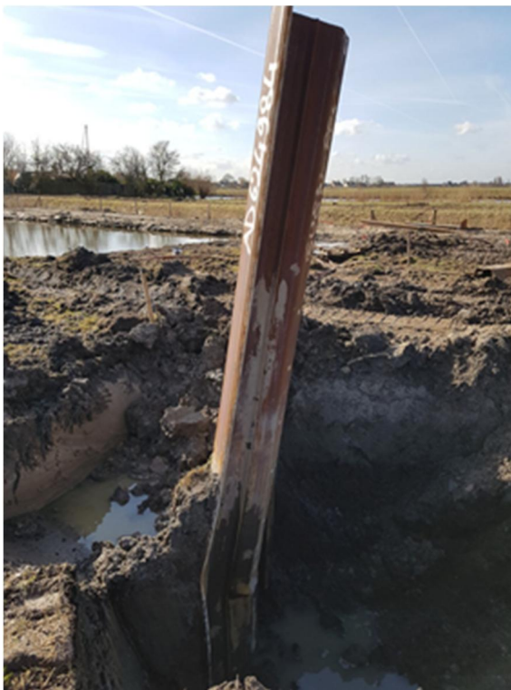
Afbeelding 4.2 : Ontgraving GU8N-rev
