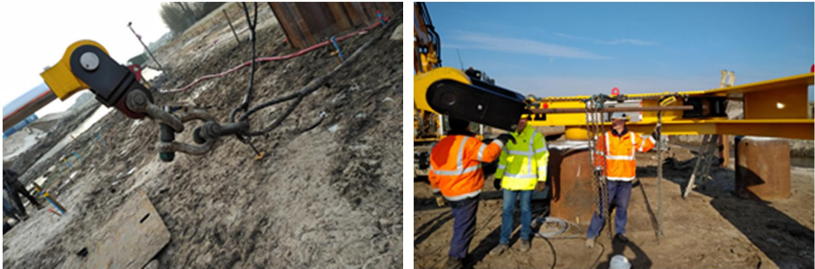
Afbeelding 2.7: Links doorhangen kabel (AZ13-700), rechts aantrekken vijzel met katrol
