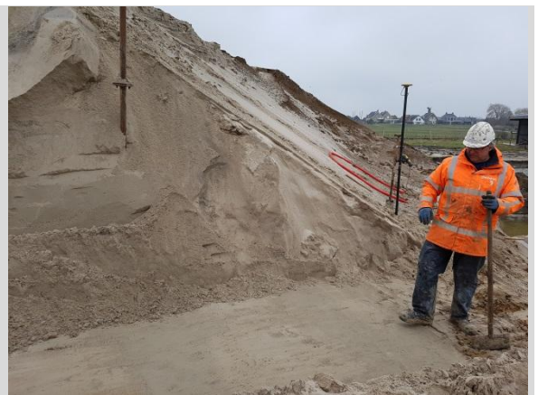
b) zijaanzicht bezwiken talud (vanuit doorsteek)
