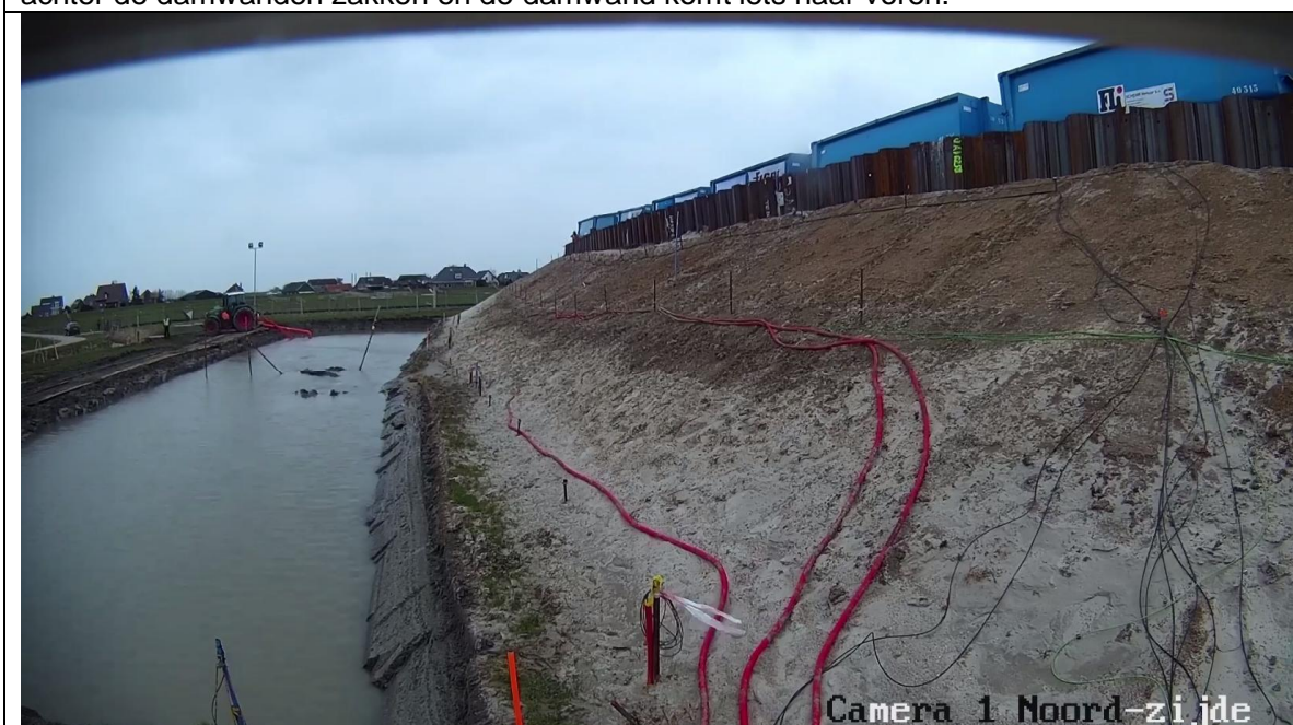
9 sec: De bodem van de ontgraving komt nu boven het waterniveau uit in het midden van de ontgraving tussen de twee linker zakbakens.
