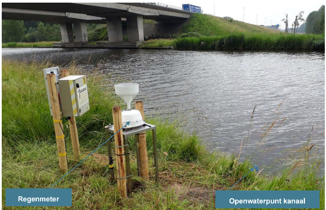
Figuur 2-4: Openwatermeetpunt kanaal en regenmeter
