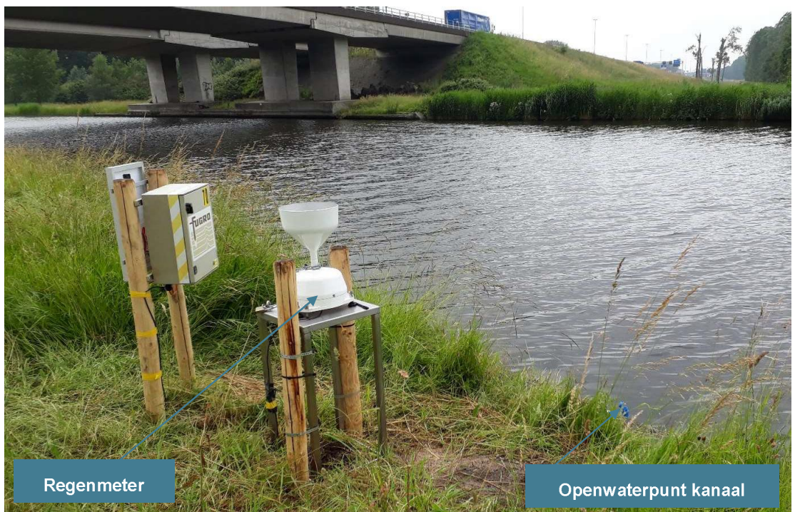
Figuur 2-4: Openwatermeetpunt kanaal en regenmeter
