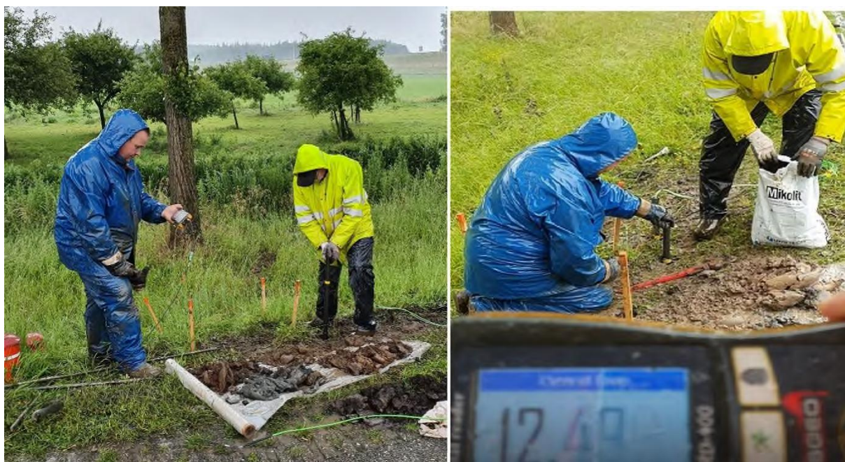
Figuur 7: Plaatsen van waterspanningsmeters en afdichten boorgat
