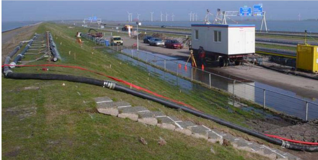
Figuur 5.1 Voorbeeld infiltratie van water binnentalud Afsluitdijk, links op de kruin van geperforeerde buis, onderaan het talud de meetkeet
