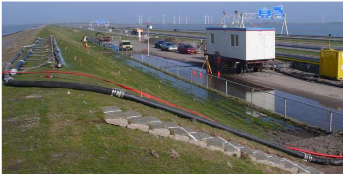
Figuur E.2 Voorbeeld infiltratie van water binnentalud Afsluitdijk, links op de kruin van geperforeerde buis, onderaan het talud de meetkeet
