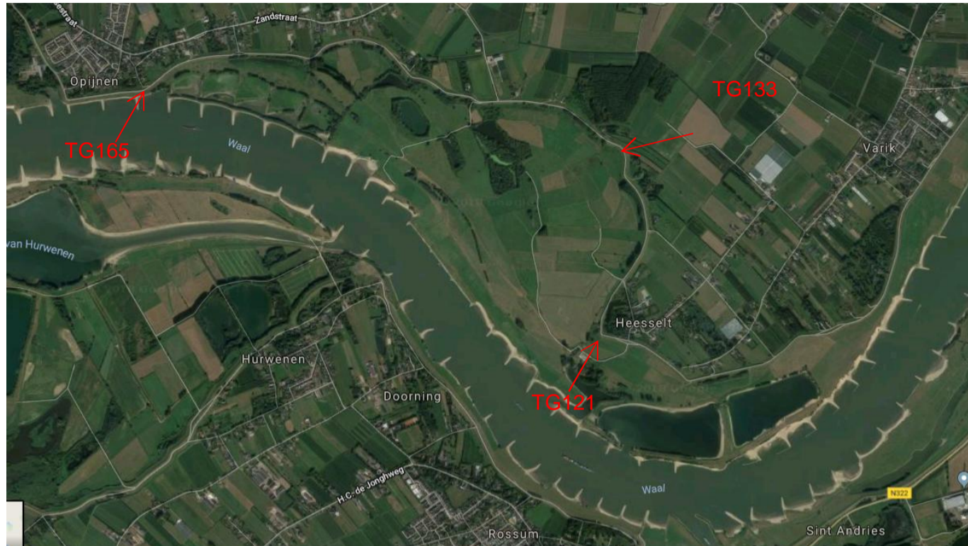
Figuur 8.5 Impressie van de Waaldijk tussen Heesselt en Opijnen. Duidelijk is te zien dat hier sprake is van een grote strijklengte waardoor dit gedeelte meer door golven wordt gedomineerd dan andere delen van de waaldijk.
