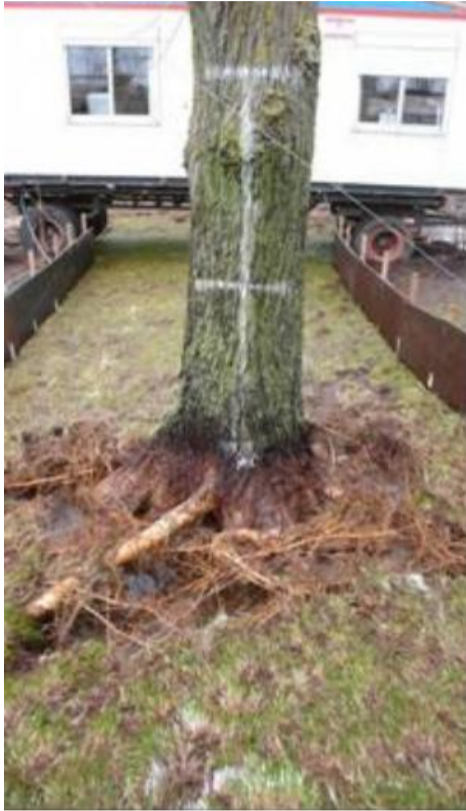
Figuur 5.5 Voorbeeld van schade als gevolg van stromingsconcentratie en turbulentie na grote overslagdebieten (5,5 uur 50 l/s/m met golfoverslagsimulator)
