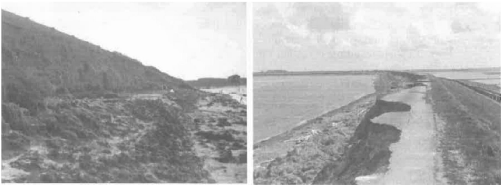
Figuur 4.7 Reststerkte na oppervlakkig afschuiven door golfoverslag gevolgd door erosie van de dijkkern, zonder doorbraak (Zeeuwse dijken na de stormvloed van 1953).
