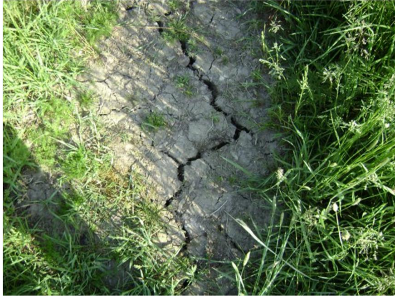
Figuur 7.4 Voorbeeld scheurvorming met een andere oorzaak dan geotechnisch falen (bron: [16]).
