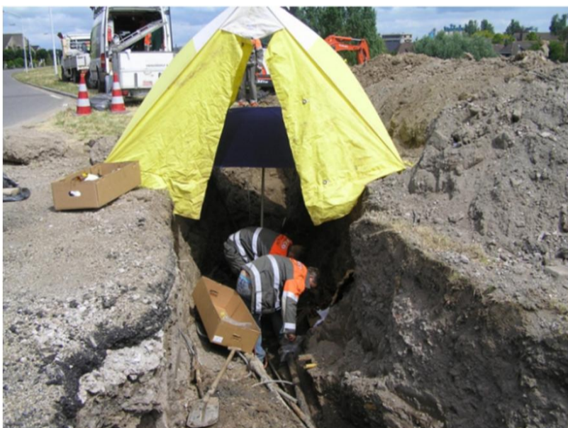
Figuur 7.3 Voorbeeld van werkzaamheden dicht bij de dijk (bron: [55]).
