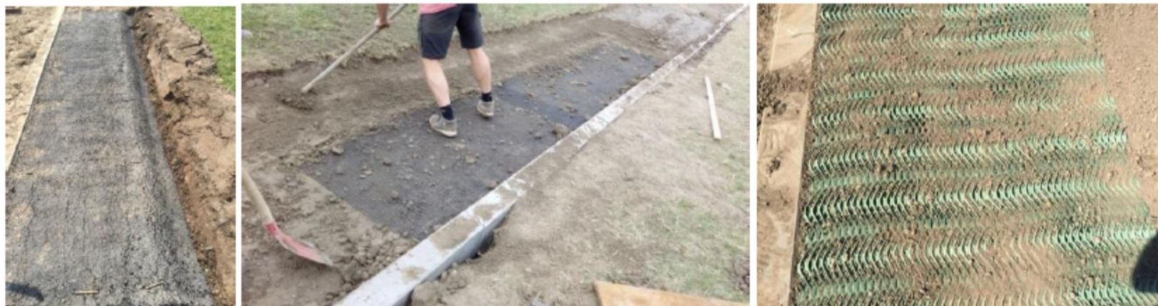
Figuur H.2 Impressie van aangebrachte doorgroeibare materialen in de pilotsectie op het binnentalud van de Waddenzeedijk ([10], [11])
