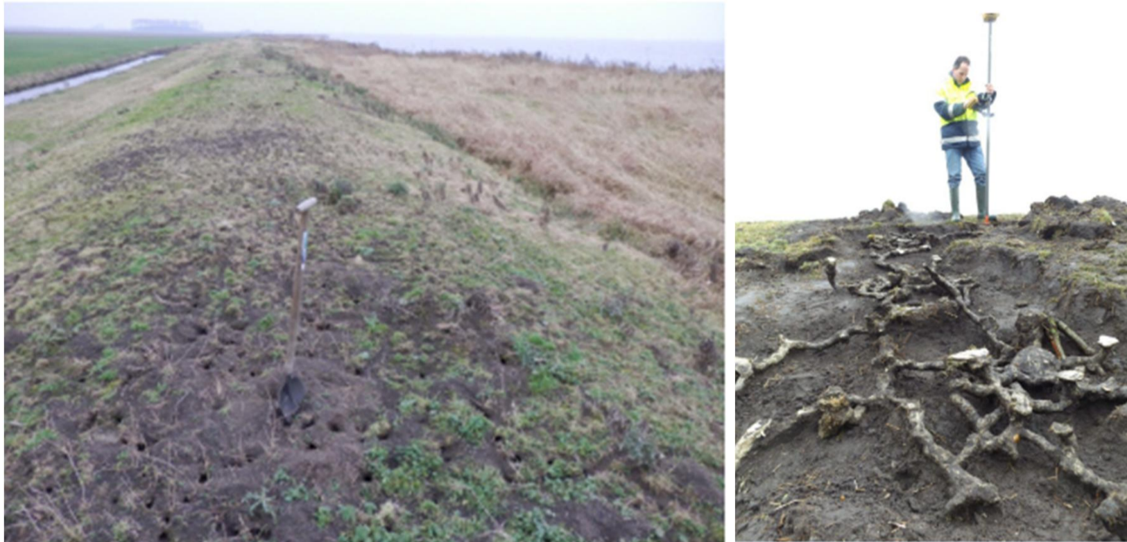
Figuur 4.10 Graverij door muizen. Bron: [39]
