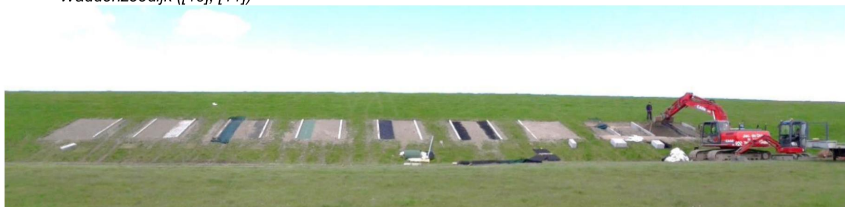
Figuur H.3 Impressie van aanleg pilotsecties met verticale overgangen. Hierna dient het gras hier doorheen te groeien ([10], [11])
