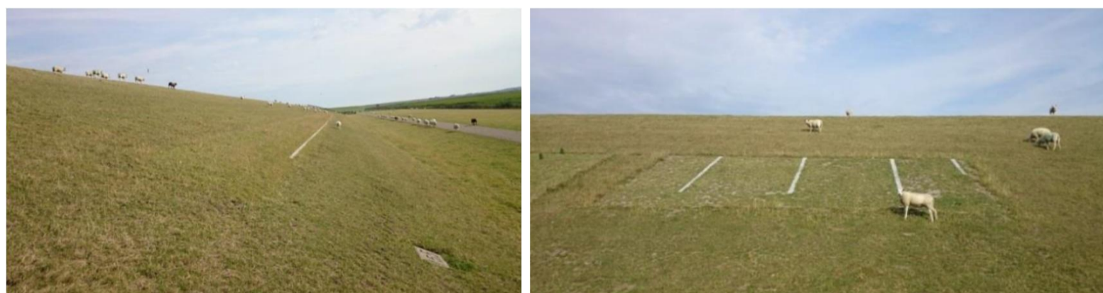
Figuur H.5 Impressie van horizontale overgangen (links) en een deel van de verticale overgangen (rechts) circa een jaar na aanleg. De doorgroeitextielen zijn nu niet meer zichtbaar vanwege de al enigszins ontwikkelde grasmatt ([10], [11])
