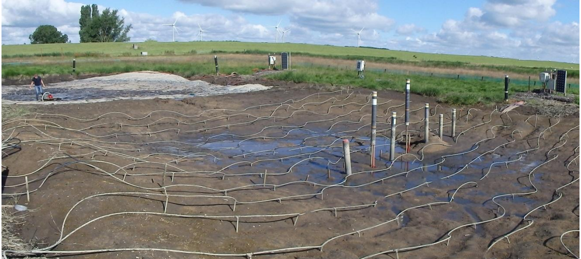
Figuur 3.19 Overzicht van de gekoppelde drainagebuizen (foto gemaakt na afloop van de proef)
