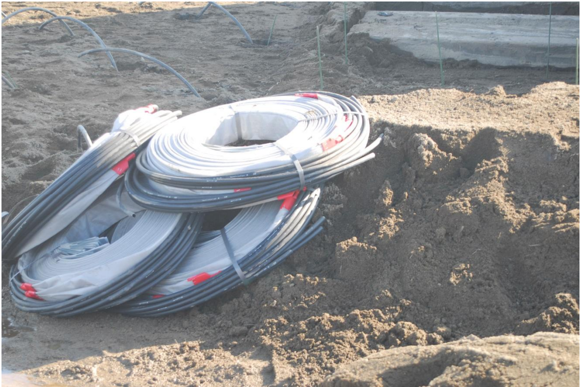
Figuur 3.17 Geprefabriceerde BeauDrain-S drains met aan de bovenzijde de thyleen leidingen
