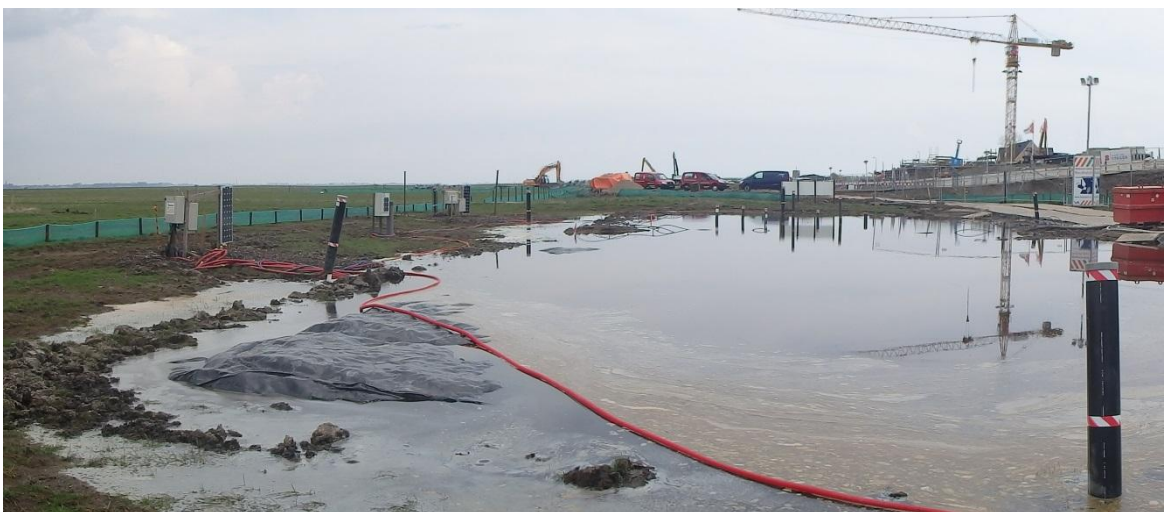
Figuur 3.16 Foto genomen op 13 april Rechts is de folie zichtbaar waarmee het vacuümvak is ingepakt
