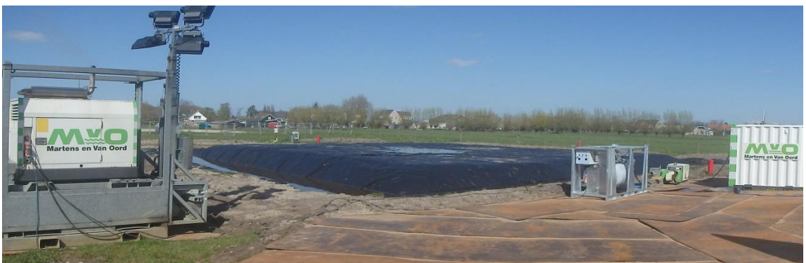
Figuur 3.9 De vacuümconsolidatieproef in uitvoering
