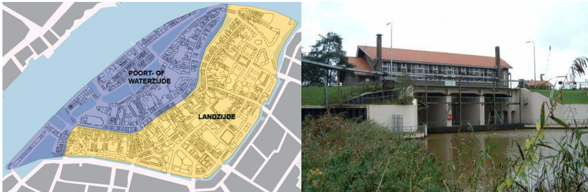
Figuur 11. Links : De historische binnenstad van Dordrecht is een beschermd stadsgezicht. De waterkering loopt grofweg op de scheiding tussen de landzijde en de poort- of waterzijde (Gemeente Dordrecht, 2014). Rechts : het Gemaal Buma is een rijksmonument en maakt onderdeel uit van de waterkering (foto: www.zuiderzeeland.nl ).
