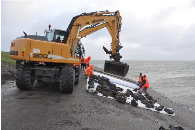
Figuur 7. Oefening van een noodreparatie op Texel (foto: www.texelsecourant.nl ).
