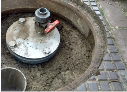
Afbeelding 2.3 Links: ontlastbron in Opijnen; rechts: overlaat in besturingsput in Opijnen (18 januari 2016)
