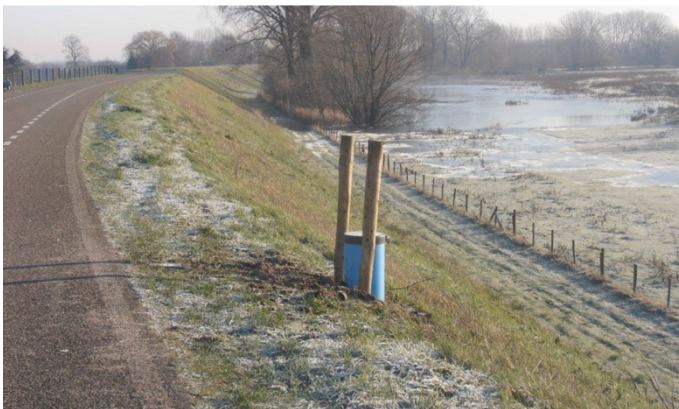
Afbeelding 3.6 Peilbuis in dijk Opijnen onderdeel van geohydrologisch meetnet (foto Witteveen+Bos)
