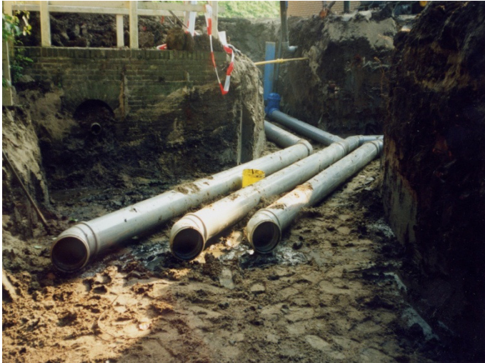
Afbeelding 3.2 Installatie van verzamelleidingen in Jaarsveld (foto: HDSR)
