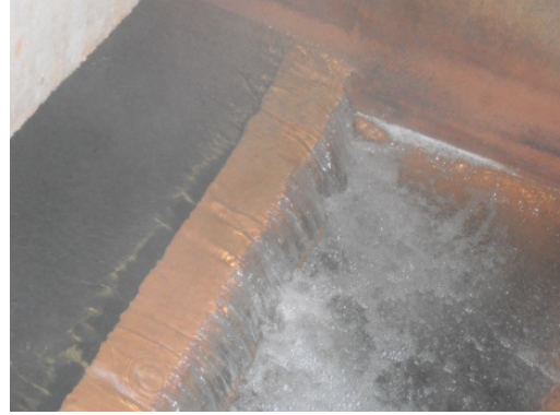
Afbeelding 2.3 Links: ontlastbron in Opijnen; rechts: overlaat in besturingsput in Opijnen (18 januari 2016)
