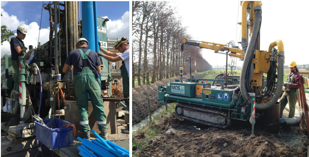
Afbeelding 3.1 Installatie van verticale bron, links via vrachtwagen, rechts via rupsstelling (foto's: Mos)
