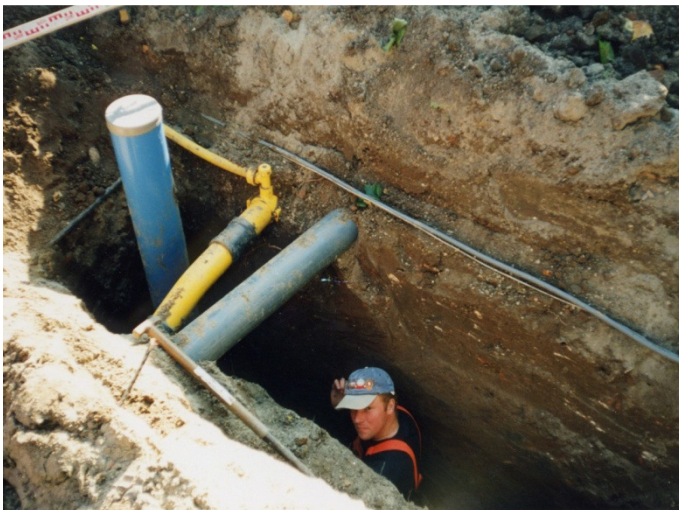
Afbeelding 3.3 Aansluiting ontlastbron (blauwe verticale buis) op verzamelleiding in Jaarsveld (foto: HDSR)
