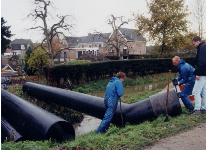
Afbeelding 3.5 Afvoerleiding gereed voor installatie in Jaarsveld (foto: HDSR)
