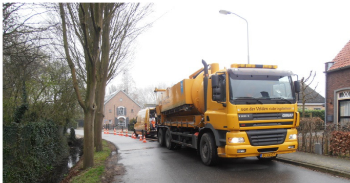
Afbeelding 3.9 Camera-inspectie ontlaststelsel Opijnen 1 maart 2016, (foto: Witteveen+Bos)
