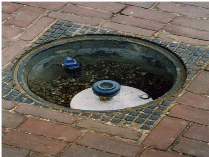
Afbeelding 3.10 Geopende put in verharding met bovenkant van ontlastbron en afsluiter in Jaarsveld (foto: HDSR)
