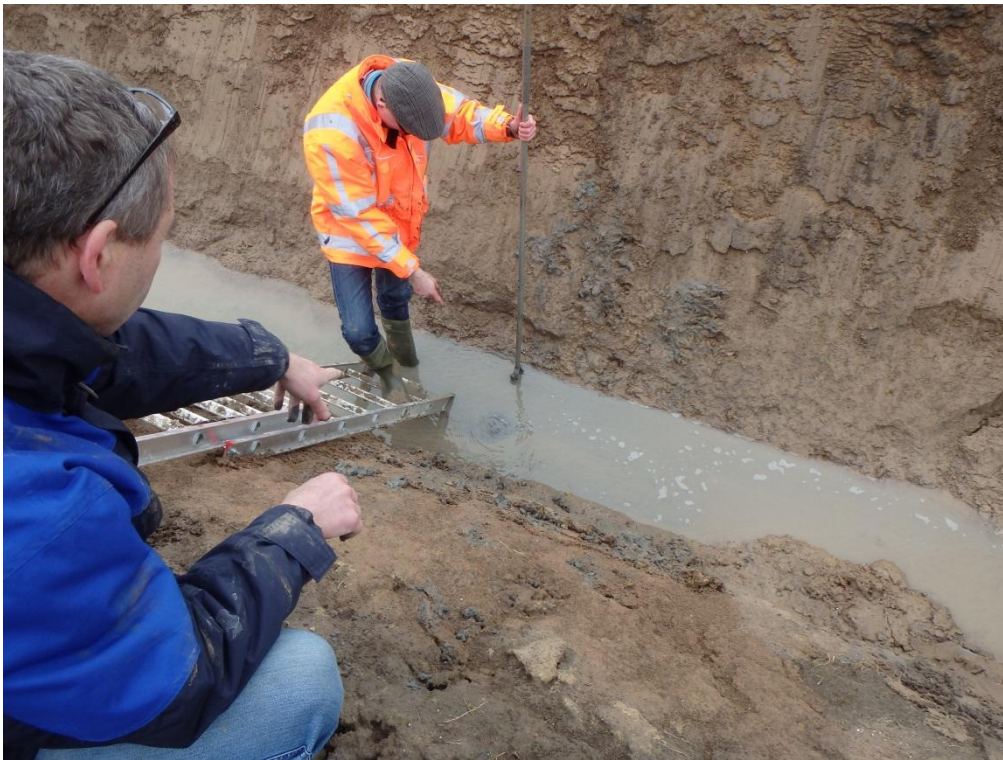
Figuur 3.3 Begin van een wel in kopsloot 2, kort na de laatste keer boren (6 februari 12:54:04)
