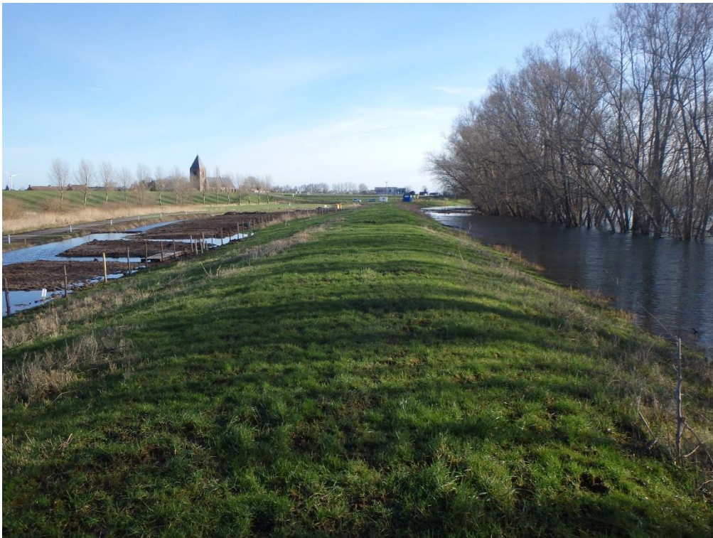
Figuur 3.8 Overzicht van de zomerkade en het proefterrein in oostelijke richting vanaf kopsloot 9
