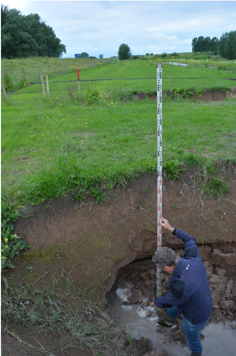
Figuur 3.20 Baak direct na verwijdering uit opgeschoven wel in kopsloot 1
