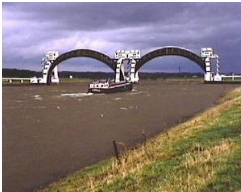
Figuur 27. Sluizen bij Driel, aangelegd in 1973. Vanaf dat moment fluctueert het peil op de IJssel minder en is de rivier beter bevaarbaar. Verstuwde rivieren hebben alle het probleem dat ze zich insnijden en daardoor de wijde omgeving draineren, zodat er verdroging optreedt.
