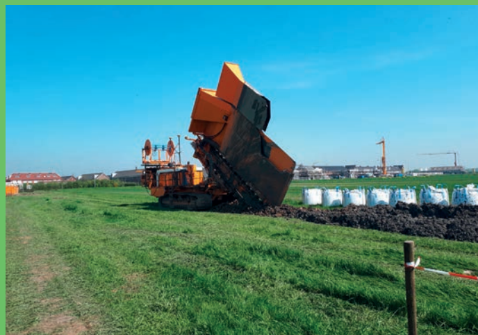
Figuur 9-6 Gefreesde inbrengmethode VZG. Foto links: Van den Herik. Foto rechts: Van Kessel
