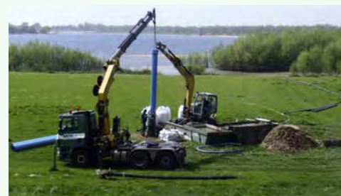
Proef in opbouw
