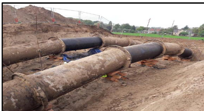
Figuur 2.5 Vrijgegraven transportleidingen
