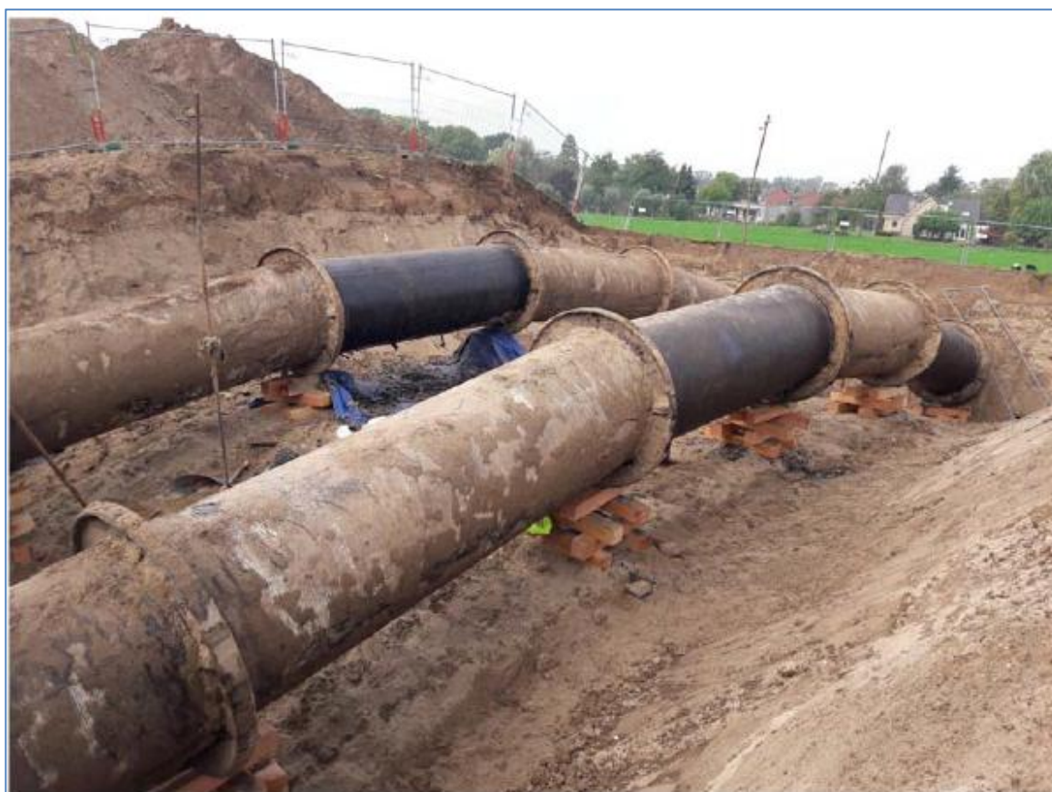
Figuur A.7 Vrijgegraven leiding ter plaatse van de kruin van de waterkering, november 2017.
