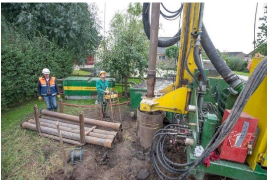
H6 Realiseren, testen en verwijderen
