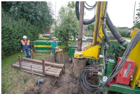
H6 Realiseren, testen en verwijderen
