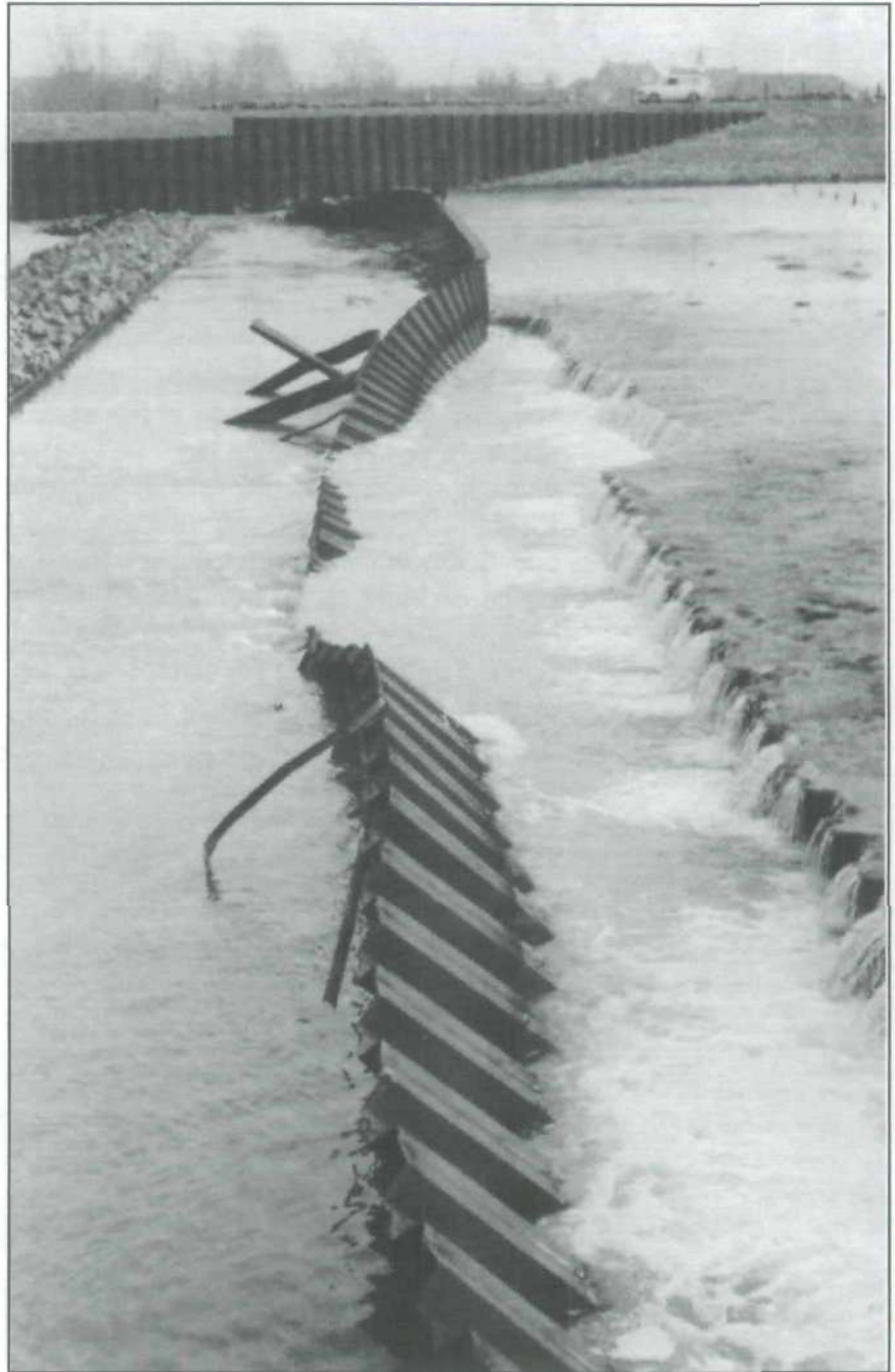
Figuur 21 De Pannerdense overlaat na het hoogwater van februari 1970.
