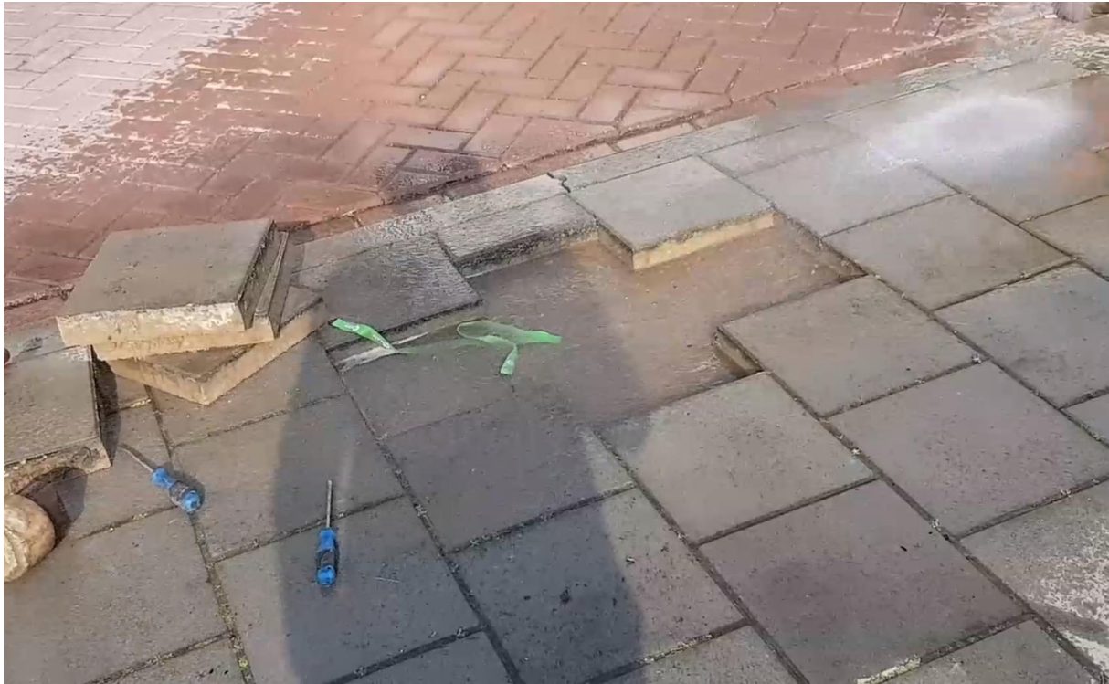
Figuur 3-15 zandfunderingstest Azuurweg vullen (Beerlandt, 2021k)
