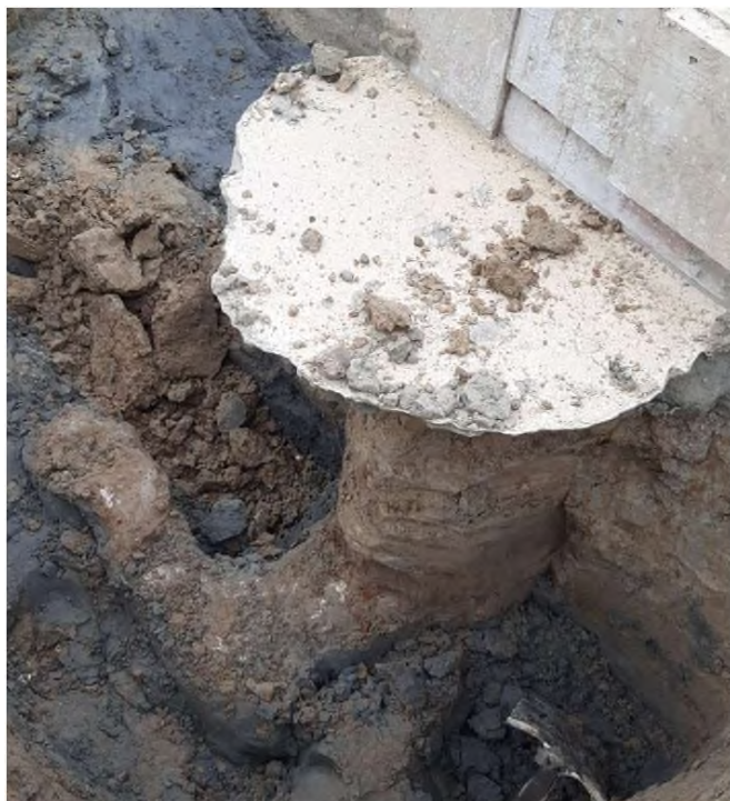
Figuur 6-2: Uittredekanal in proefvak Noord opgevuld met egaline. Overgang naar horizontale pipe is goed te zien (overgenomen uit Factual Report 1220-164143.R04 d.d. 25-3-2022).
