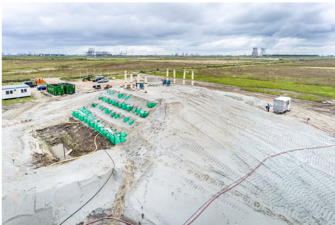
Figuur 1-1: Proefopstelling pipingproeven in de Hedwigepolder.
