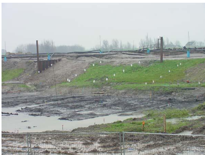
Figuur 1-2: Overzicht praktijkproef bij Bergambacht na afschuiven (2001)
