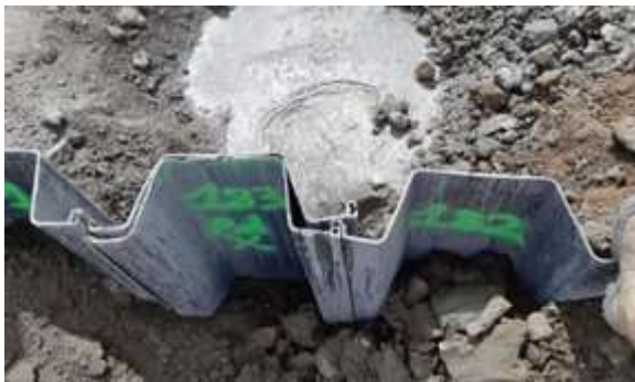
Figuur 6.5 Voorbeeld van de 'potdekselmethode'
