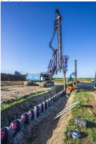
(3) Funderingsstelling met voorspanning door en/of lier
