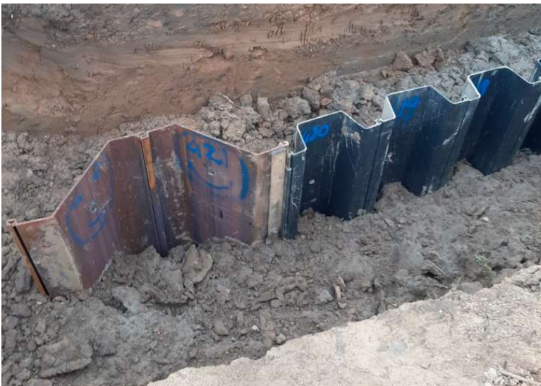
Figuur 4.7 Toepassen overgangsconstructie stalen AZ-profiel en kunststof profiel
