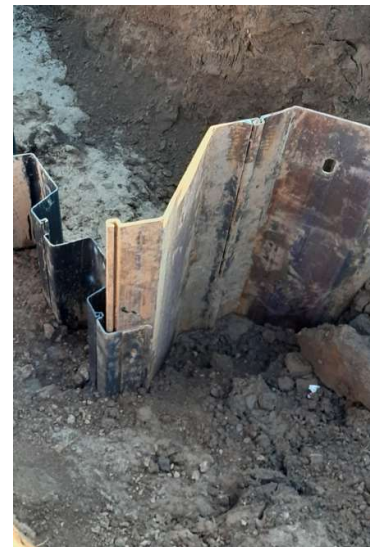
Figuur 4.7 Toepassen overgangsconstructie stalen AZ-profiel en kunststof profiel
