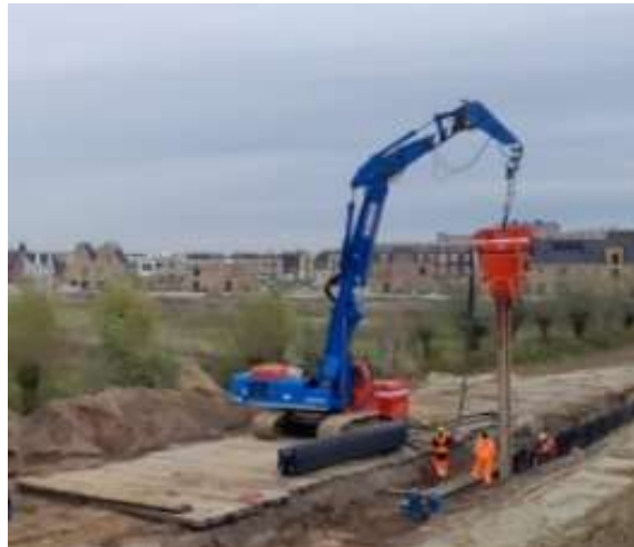
(2) Funderingsstelling met vrijhangend trilblok
