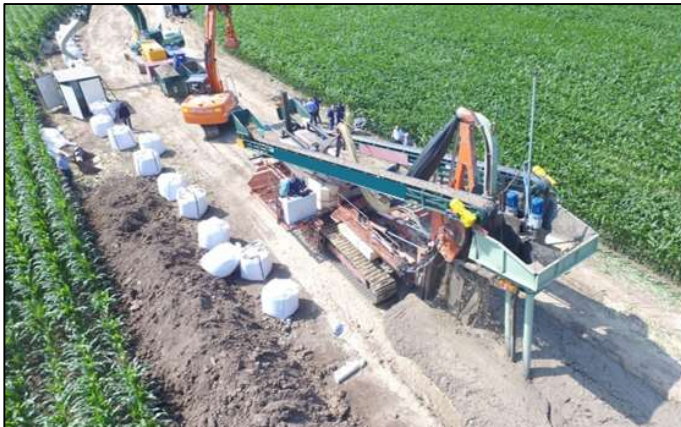
Figuur 2.4: Drainmachine voor aanbrengen VZG (2/2).
