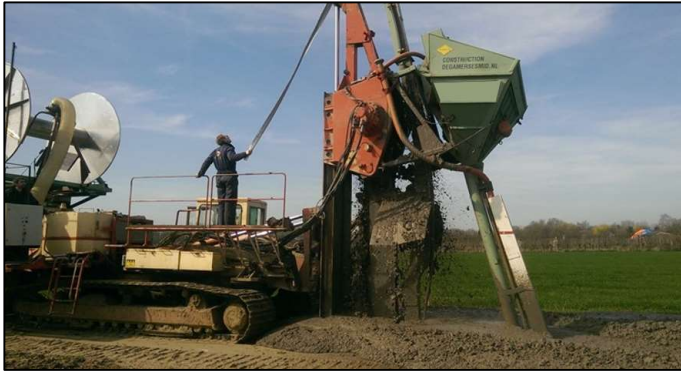
Figuur 2.3: Drainmachine voor aanbrengen VZG (1/2).
