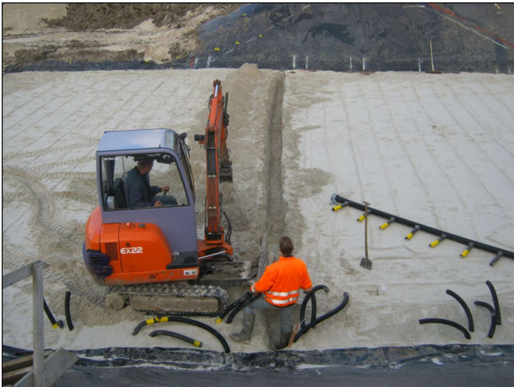
Figuur 5.4: Toepassing Verticaal Zanddicht Geotextiel in den droge bij de IJkdijk.
