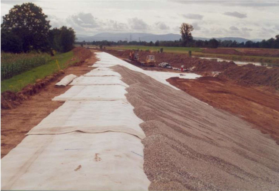
Figuur 4.26: Aanbrengen grindhoudend grof zand (Arcadis, 2021)
