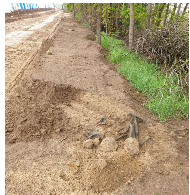
Figuur 2.10. Voorbeelden van obstakels die bij de uitvoering Twentekanalen naar boven zijn getransporteerd door de kettinggraver.
