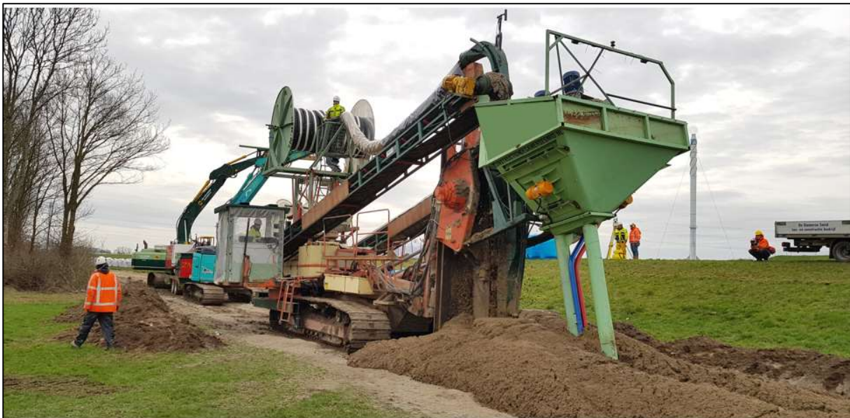
Figuur 5.3. Toepassing Verticaal Zanddicht Geotextiel horizontale uitvoering middels kettinggraver.
