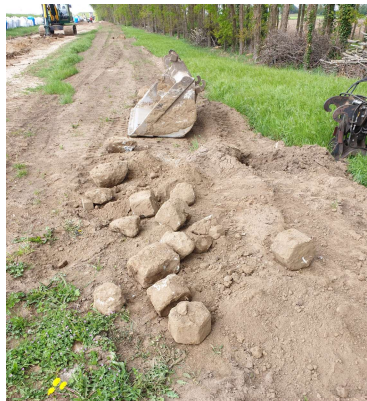
Figuur 2.10. Voorbeelden van obstakels die bij de uitvoering Twentekanalen naar boven zijn getransporteerd door de kettinggraver.
