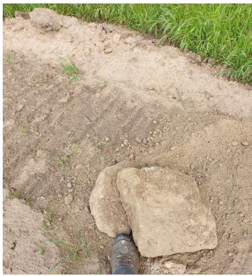
Figuur 2.10. Voorbeelden van obstakels die bij de uitvoering Twentekanalen naar boven zijn getransporteerd door de kettinggraver.
