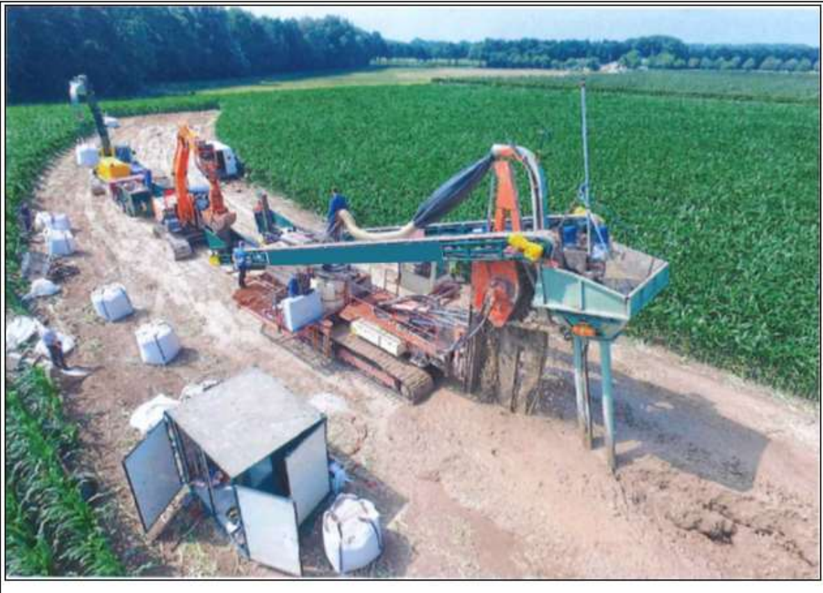
Figuur 5.2: Toepassing Verticaal Zanddicht Geotextiel horizontale uitvoering middels kettinggraver.
