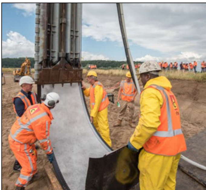
Figuur 5.5: Toepassing Verticaal Zanddicht Geotextiel met verticale inbrengtechniek.
