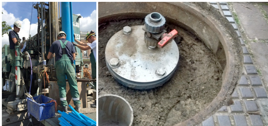
Figuur 2-7: Links, installatie van verticale bron. Rechts, ontlastbron in Opijnen, (Witteveen+Bos, 2017)
