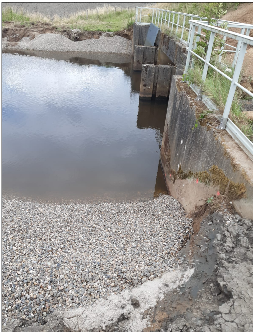
Figuur 5-10: Grindkoffer nabij Neer. Deze is ingepast in de watergang en doorgezet in de taluds.
