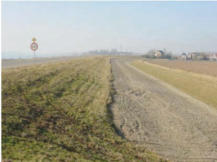
Figuur 2-11: Foto grindkoffer Spijkse Dijk, (POV Macro stabiliteit en POV Piping, 2018) (foto: Waterschap Rijn en IJssel)
