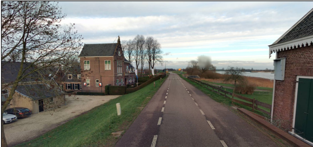
Figuur 10-3: Straatbeeld vanaf de waterkering in Jaarsveld, kijkrichting: noordoost. Links het achterland en rechts het buitenwater.
