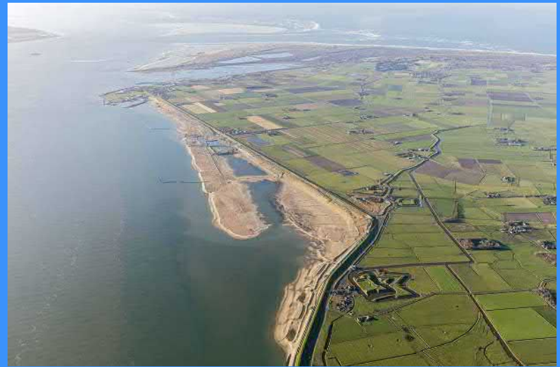
De Prins Hendrikzanddijk in aanbouw.
