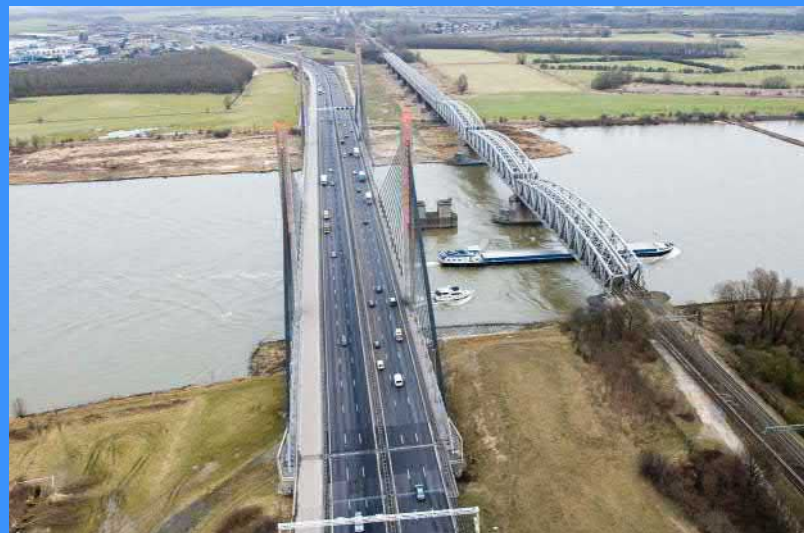
Luchtfoto van de aansluiting van de A2 en de spoorbrug op de waterkering.
