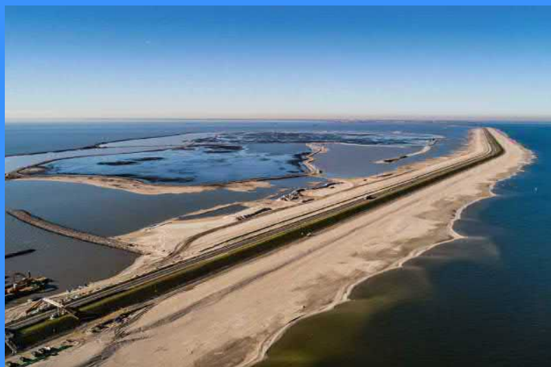
Zandige versterking Houtribdijk in aanbouw.
