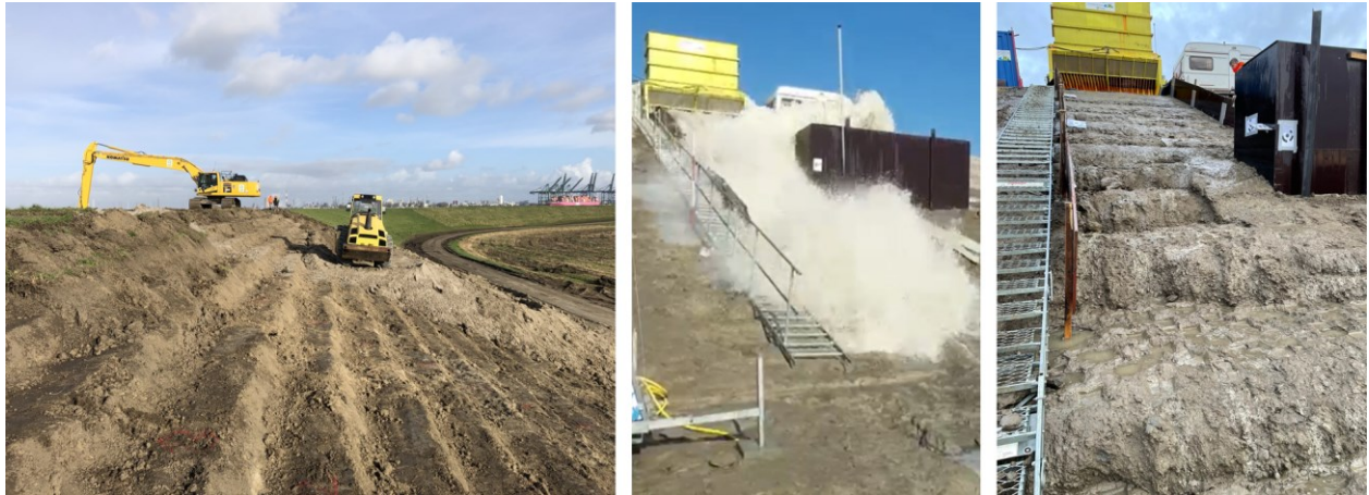
Foto 4 Erosieproeven kalk met klei bij overgangen: aanleg, beproeven, resultaat (Hedwigepolder 2022)
