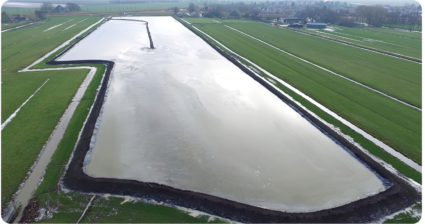
Foto: 100.000 m 3 bagger uit de Beemster en Wijdewormer Polder (Beens Groep)
