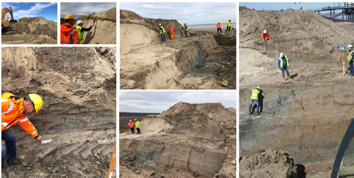
Figuur 1: Impressie inmeetwerkzaamheden kleikern zeedijk Delfzijl, 25 april 2019
