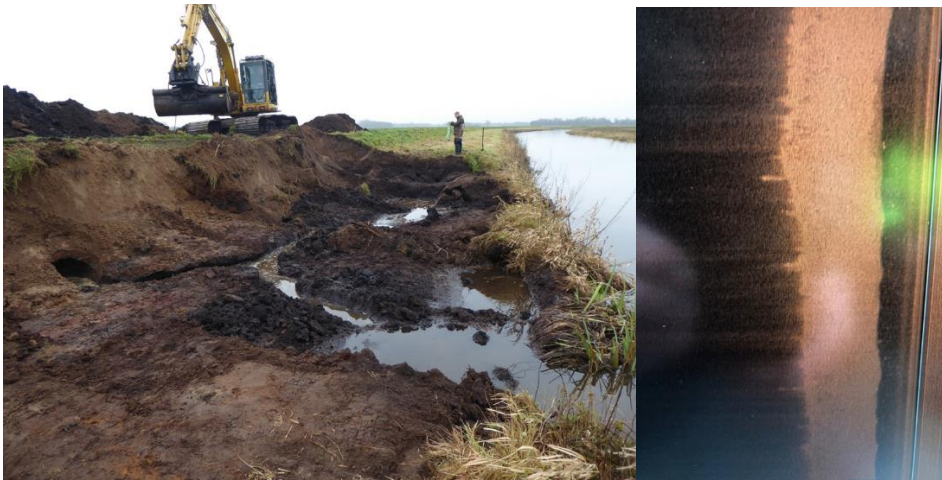
Figuur C.6 Ontgraven beverhol langs de Hunze - rechts beelden van de sonar over de kade langs de Hunze waarvan de dikkere streepjes horizontaal de bevergangen zijn (bron: M. Rothengatter, 2023).
