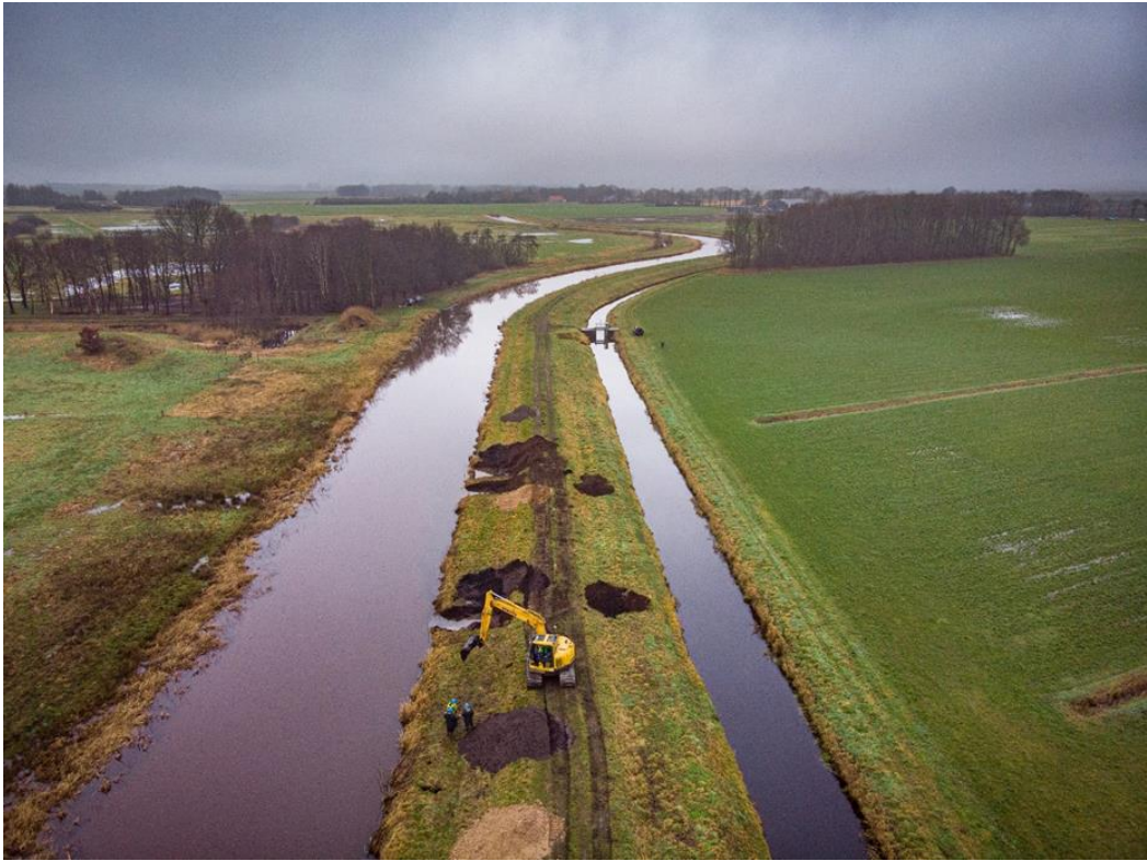
Figuur C.5 Ontgraven en herstellen beverholten langs de Hunze over een lengte van 550 m (bron: M. Rothengatter, 2023).
