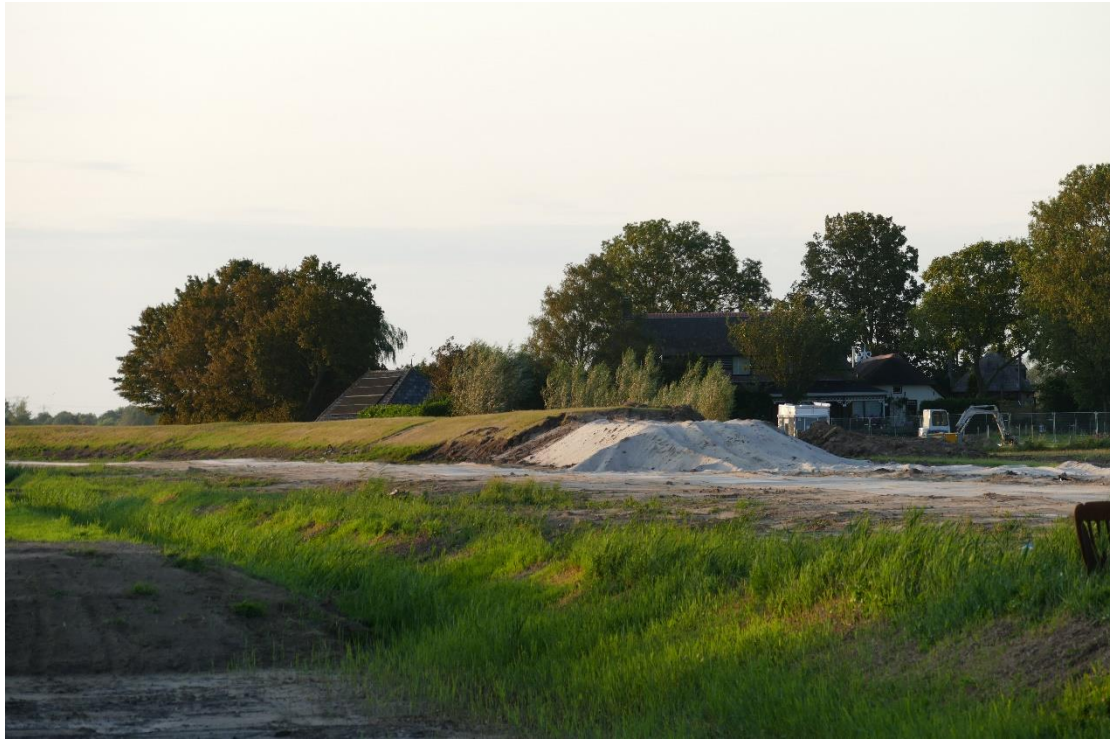
Figuur 4.1 Voorbeeld van een primaire waterkering bestaande uit een zandkern met kleibekleding: de IJsseldijk ter hoogte van het Reevediep (foto: Bianca Hardeman).
