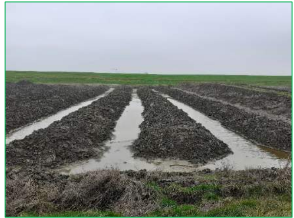
FIGUUR 19: KWELDERDEPOT: OOGSTEN KORST VAN OP RUGGEN GEZETTE KLEI, EN NATTE VOETEN
