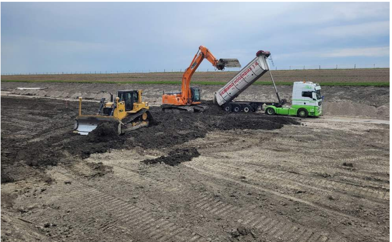
FIGUUR 16: VERWERKEN VAN DE EERSTE VRACHT VALGENWEGKLEI
