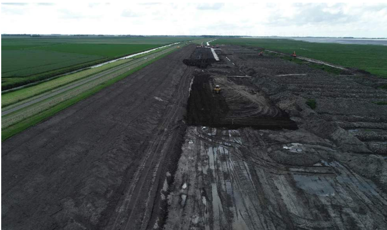
FIGUUR 20: VERWERKING VAN HET EERSTE MATERIAAL OP HET DIJKVAK KWELDER / KLUTENPLAS (MEDIO JUNI)
