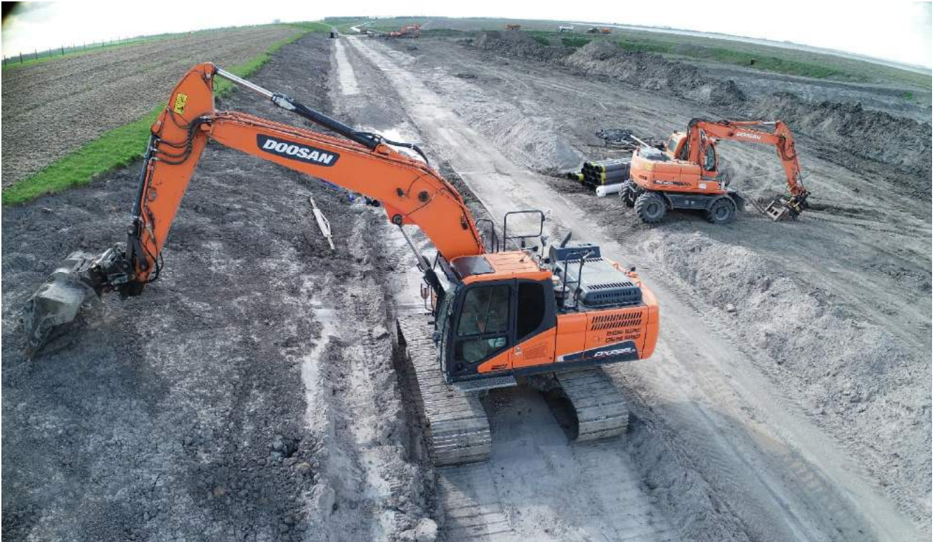
FIGUUR 17: VERWIJDEREN VAN DE BESTAANDE GRASMAT VOOR HET GOED KUNNEN AANLSUITEN VAN DE NIEUWE KLEI OP DE BESTAANDE DIJK
