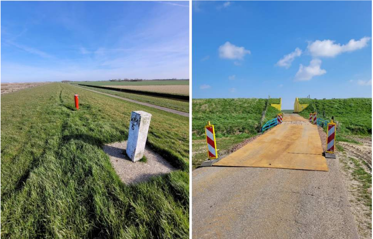
FIGUUR 1: DE EERSTE VOORBEREIDINGEN WORDEN GETROFFEN (MEDIO APRIL)
