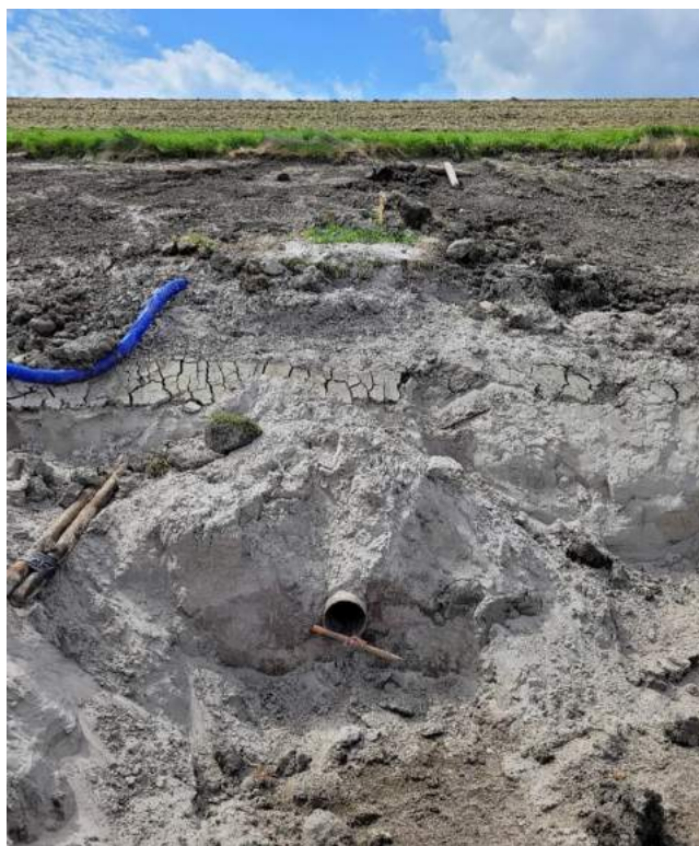
FIGUUR 11: VOORRAAD STRABUSIL-BUIZEN VOOR DE BUITENDIJKSE DRAINAGE / DE EERSTE AANGEBRACHTTE BORING (STALEN MANTELBUIS)
