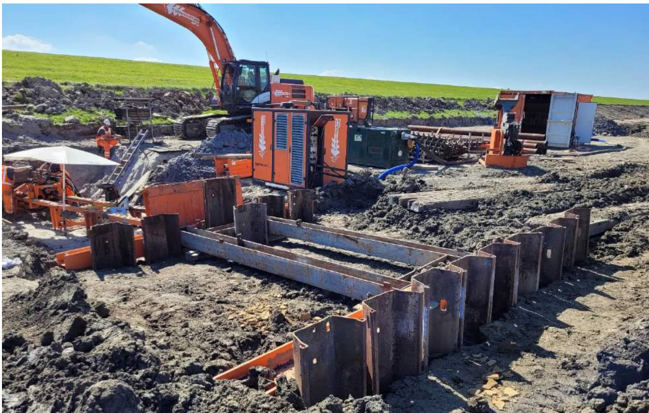
FIGUUR 10: OPBOUWEN VAN DE STARTKUIP VAN DE EERSTE PILOOTGESTUURDE AVEGAARBORING
