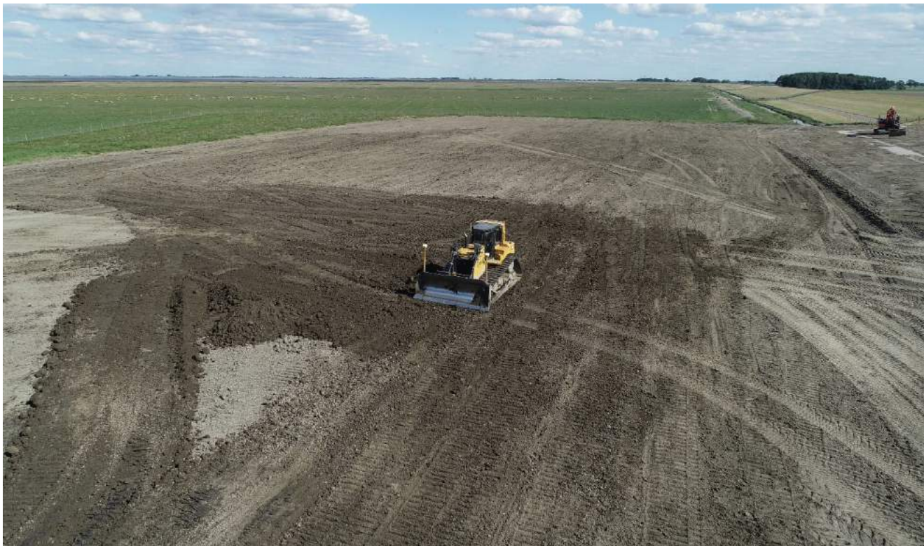
FIGUUR 32: AFWERKEN / OPRUIMEN VAN DE VOORMALIGE KLEIDEPOTS (BEGIN SEPTEMBER)
