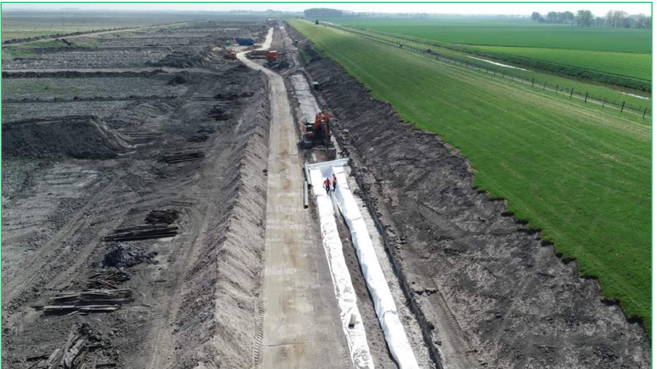
FIGUUR 5: SITUATIE BREDE GROENE DIJK MET GEDEELTELIJK VERWIJDERDE TOPLAAG EN AANLEG DRAINAGE
