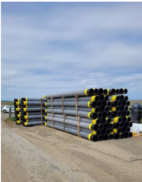
FIGUUR 11: VOORRAAD STRABUSIL-BUIZEN VOOR DE BUITENDIJKSE DRAINAGE / DE EERSTE AANGEBRACHTTE BORING (STALEN MANTELBUIS)
