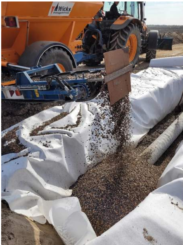
FIGUUR 12: VULLEN VAN DE BUITENDIJKSE DRAINAGESLEUF MET GRIND EN AANSLUITEN VAN DE BORING OP DE BUITENDIJKSE DRAIN
