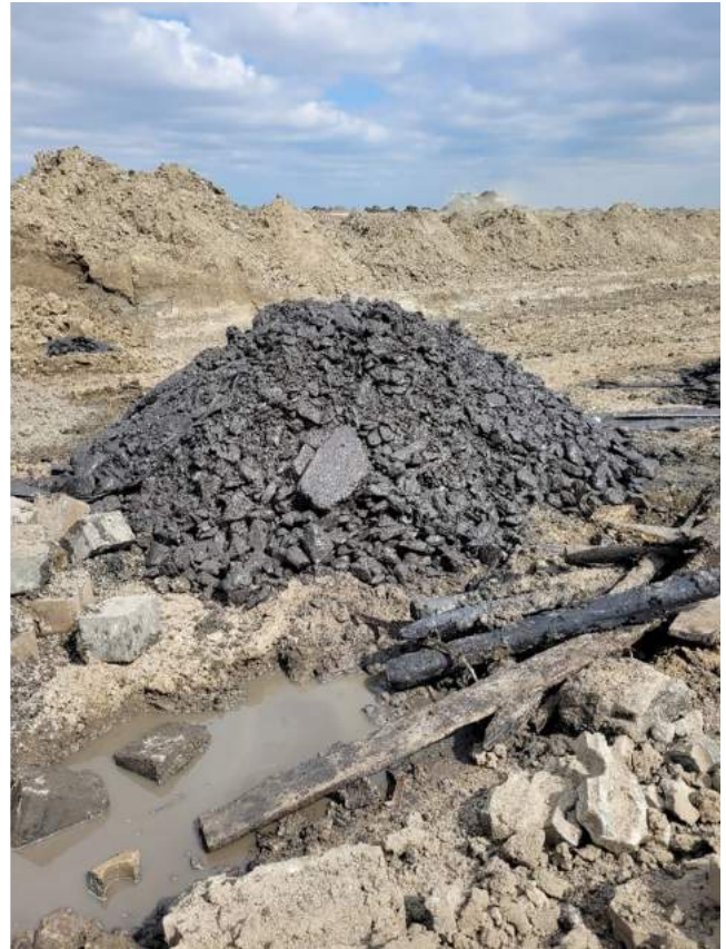
FIGUUR 3: VERWIJDEREN VAN DE BESTAANDE STEENBEKLEDING EN TEENSCHOTTEN
