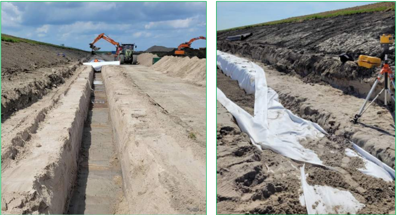
FIGUUR 3: UITGEGRAVEN SLEUF VOOR DE DRAINAGEKOFFER EN VULLING VAN DE DRAINAGEKOFFER
