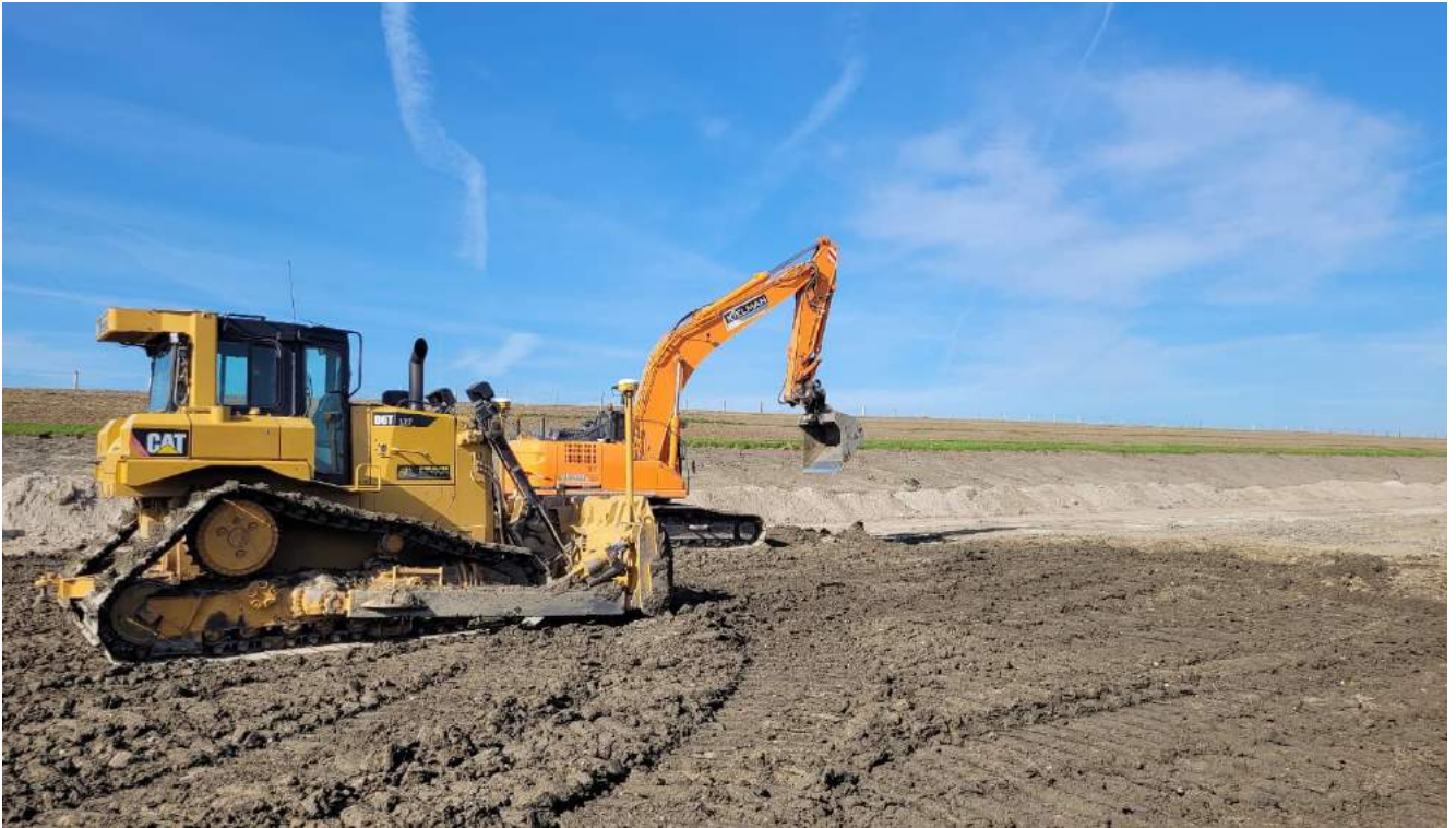
FIGUUR 15: VERWERKEN VAN DE EERSTE VRACHT VALGENWEGKLEI
