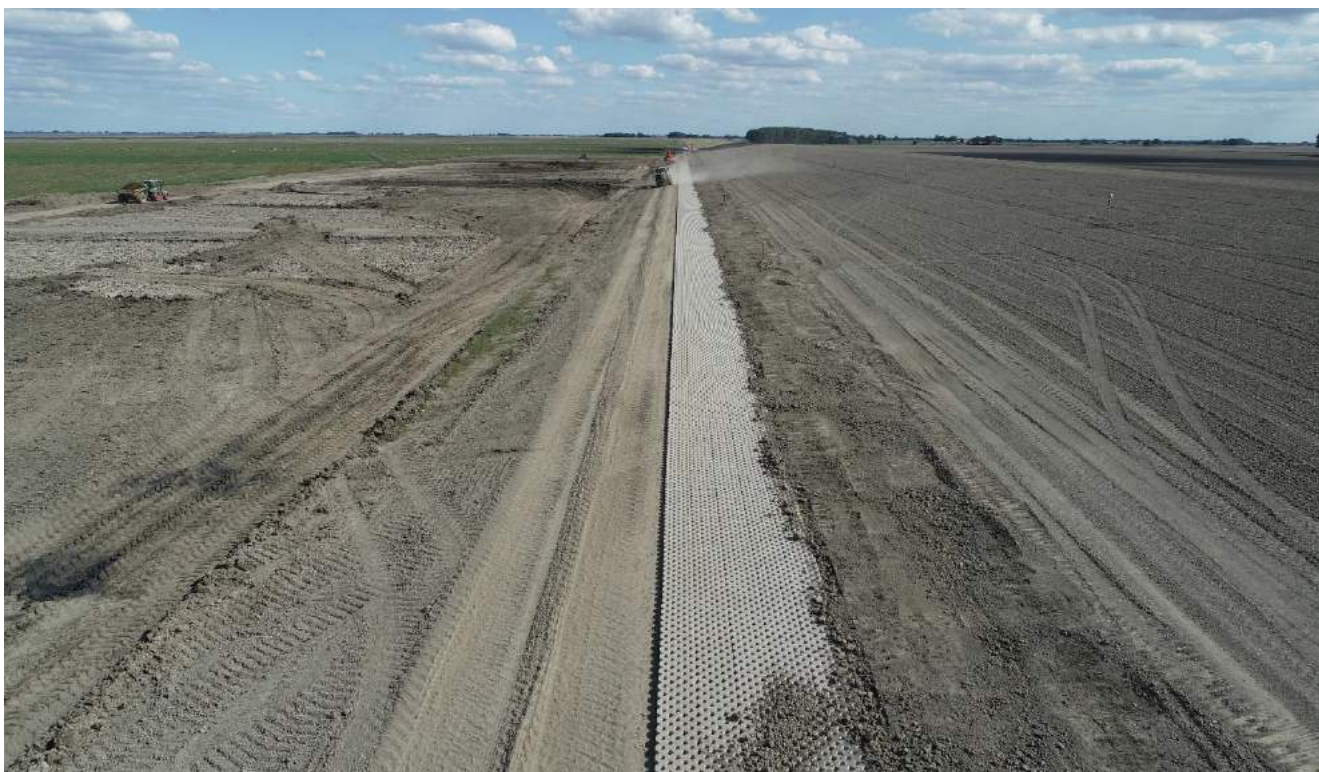
FIGUUR 33: AFWERKEN (INVEGEN) VAN HET ONDERHOUDSPAD
