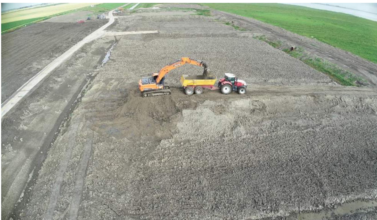
FIGUUR 25: LADEN VAN DE KWELDERKLEI VOOR VERWERKING IN HET GELIJKNAMIGE DIJKVAK
