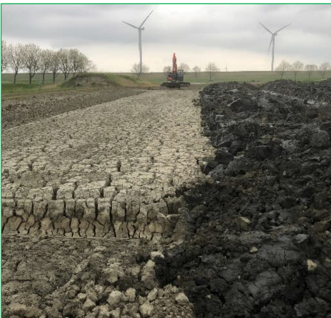
FIGUUR 18: DEPOT VALGENWEG: OMZETTEN KLEI EN KORST OP NIET GERIJPTE KLEI 45954-RAP-00128 Eindrapport Kennisontwikkeling Realisatie Brede Groene Dijk
