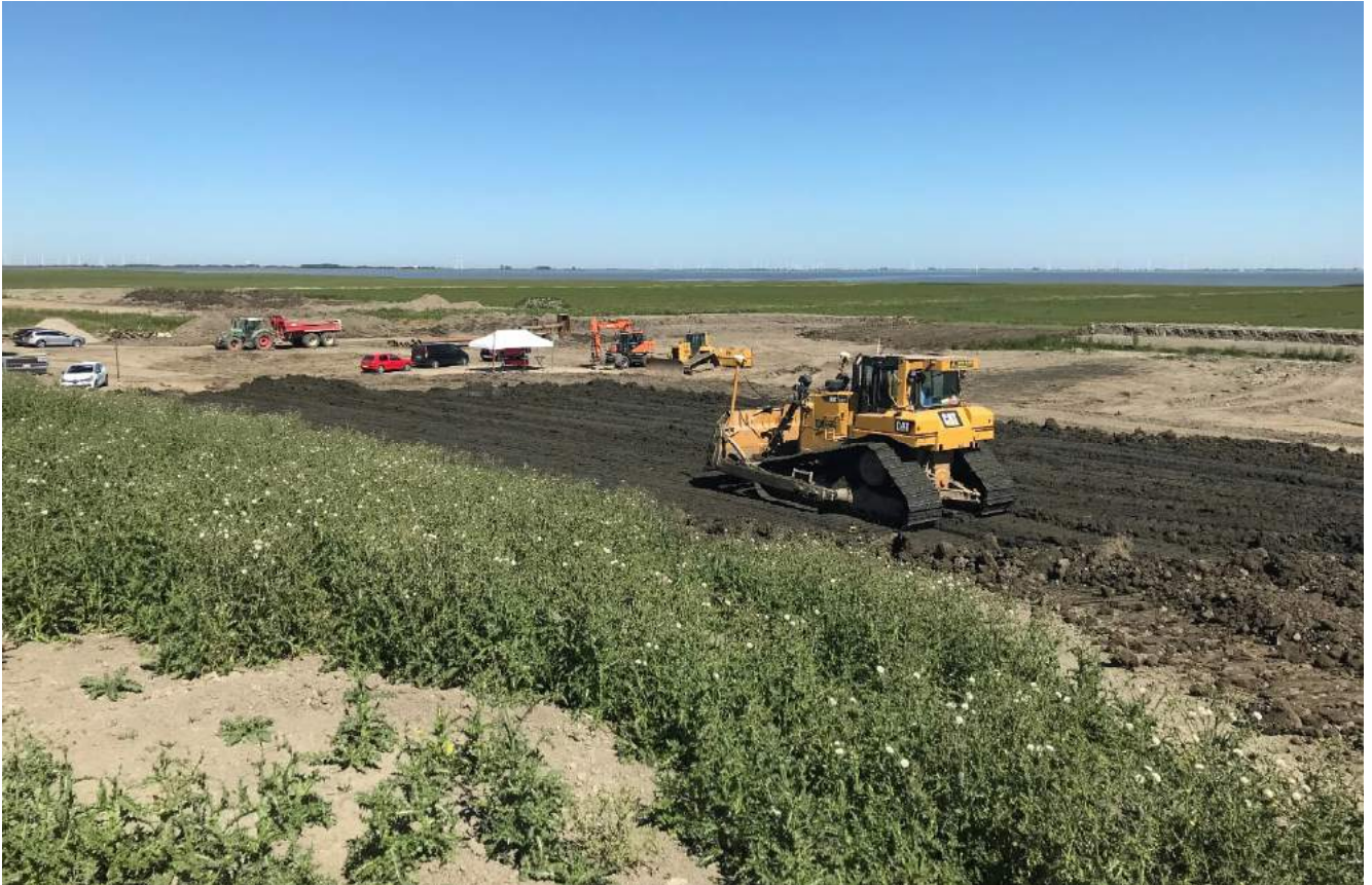
FIGUUR 28: UITVOEREN VAN DE PROEF MET EEN 'GROTERE' LAAGDIKTE KLEI (11 AUGUSTUS)
