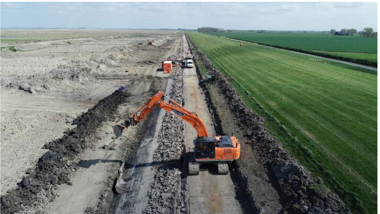
FIGUUR 4: VERWIJDEREN VAN DE BESTAANDE STEENBEKLEDING EN TEENSCHOTTEN
