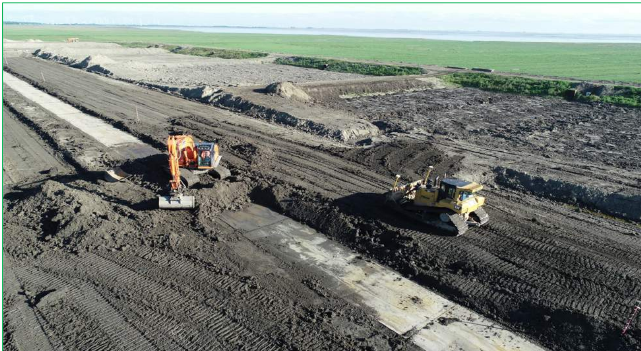
FIGUUR 10: INGEZETTE MATERIEELSTUKKEN VOOR DE VERWERKING VAN (GERIJPTE) KLEI
