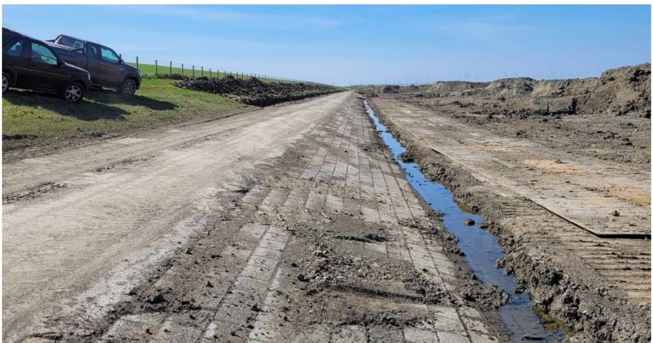
FIGUUR 2: BLOOTLEGGEN VAN DE STEENBEKLEDING VAN DE BESTAANDE DIJK
