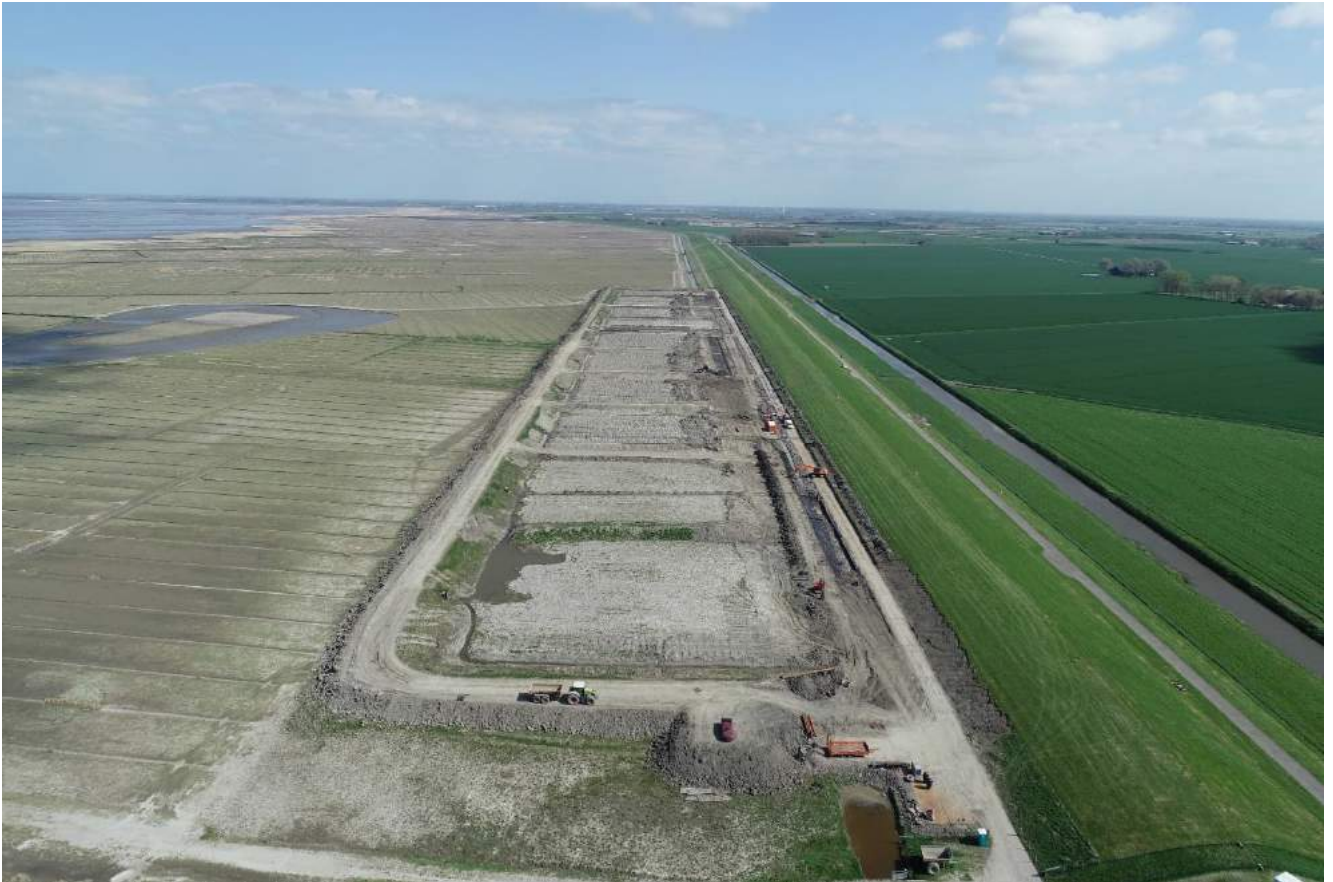
FIGUUR 7: LUCHTFOTO VAN DE TOEKOMSTIGE LOCATIE VAN DE BREDE GROENE DIJK (EIND APRIL)
