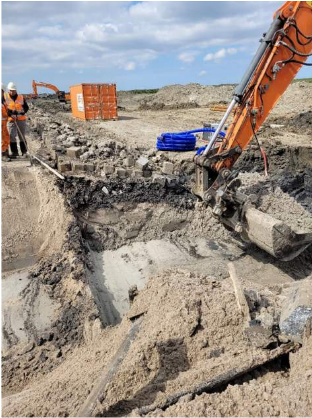
FIGUUR 3: VERWIJDEREN VAN DE BESTAANDE STEENBEKLEDING EN TEENSCHOTTEN
