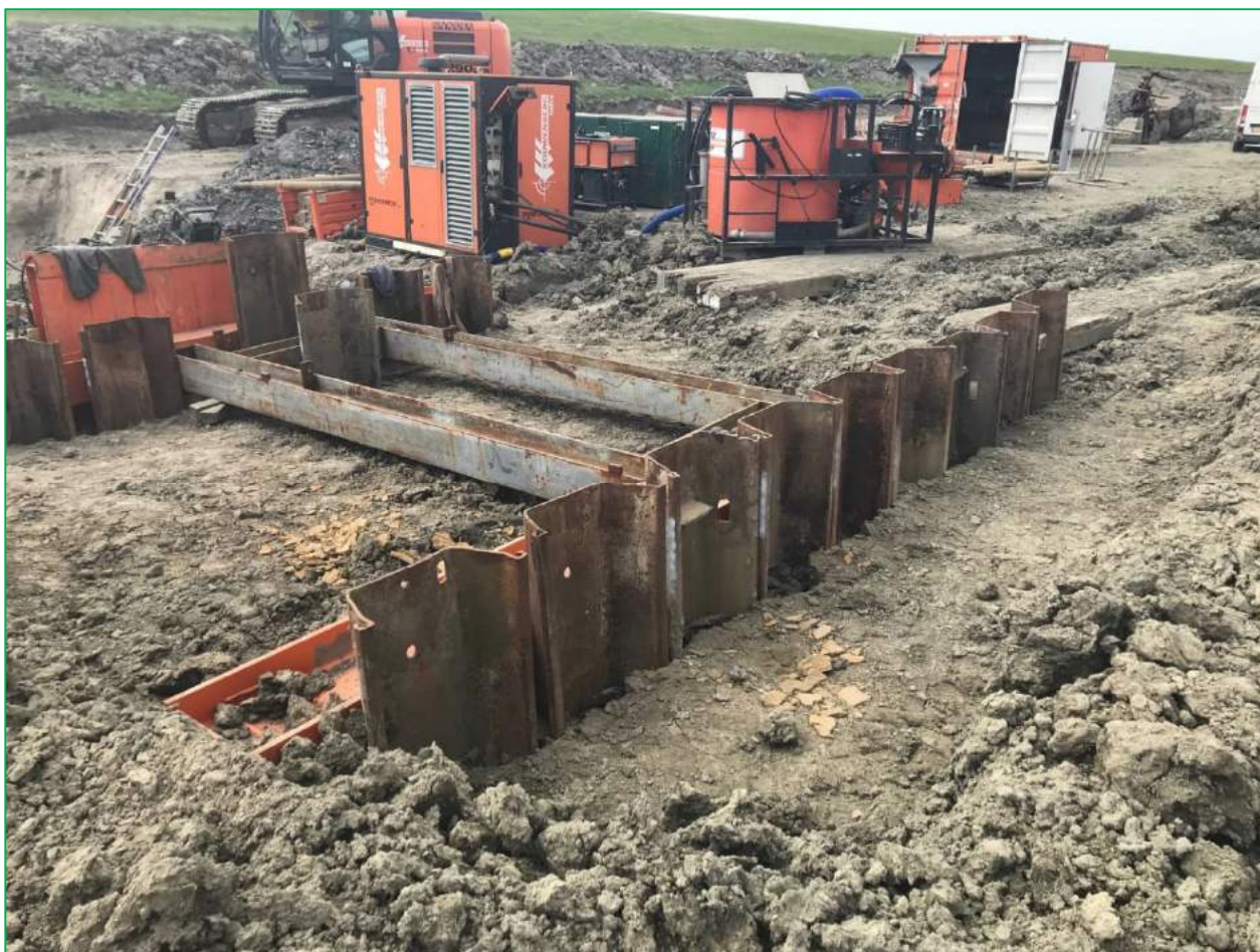
FIGUUR 2: STARTKUIP VAN DE PILOOTGESTEURDE AVEGAARBORING
