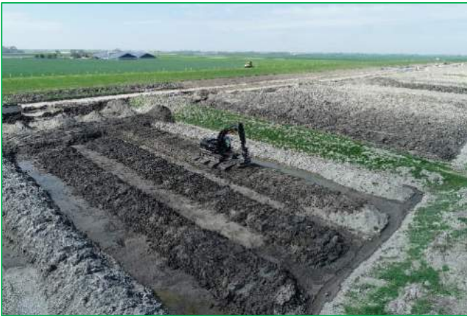
FIGUUR 19: KWELDERDEPOT: OOGSTEN KORST VAN OP RUGGEN GEZETTE KLEI, EN NATTE VOETEN
