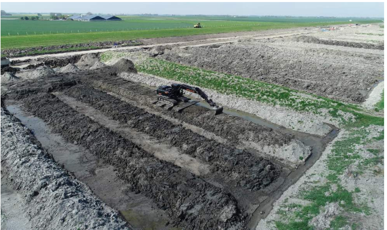
FIGUUR 18: WERKZAAMHEDEN IN DE KLEIDEPOTS VOOR HET DIJKVAK BREEBAART
