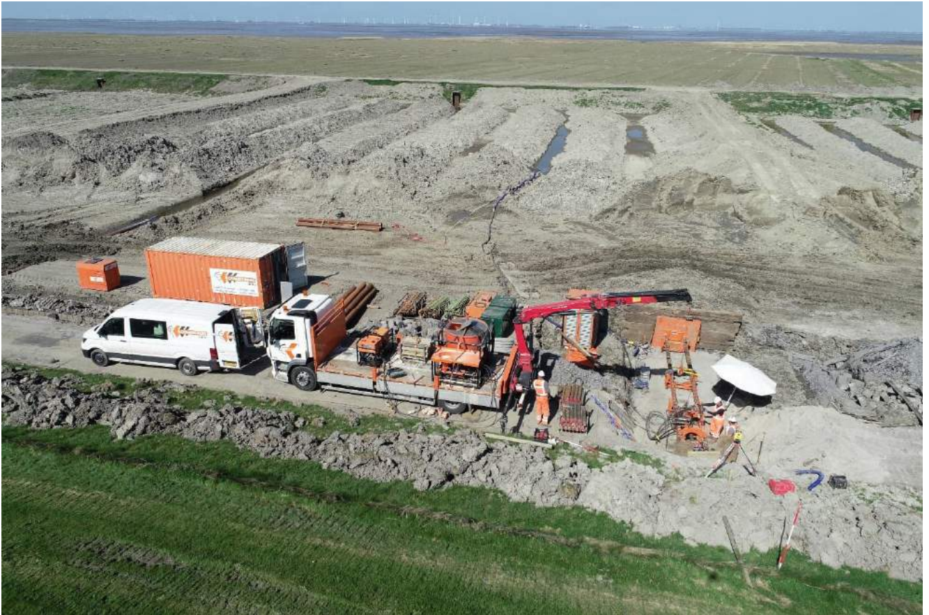
FIGUUR 5: TREFFEN VAN VOORBEREIDINGEN VAN HET AANBRENGEN VAN DE PILOOTGESTUURDE AVEGAARBORINGEN
