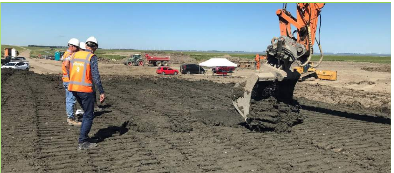
FIGUUR 22: UITVOERING PROEF GROTERE LAAGDIKTE (D.D. 11 AUGUSTUS 2022)
