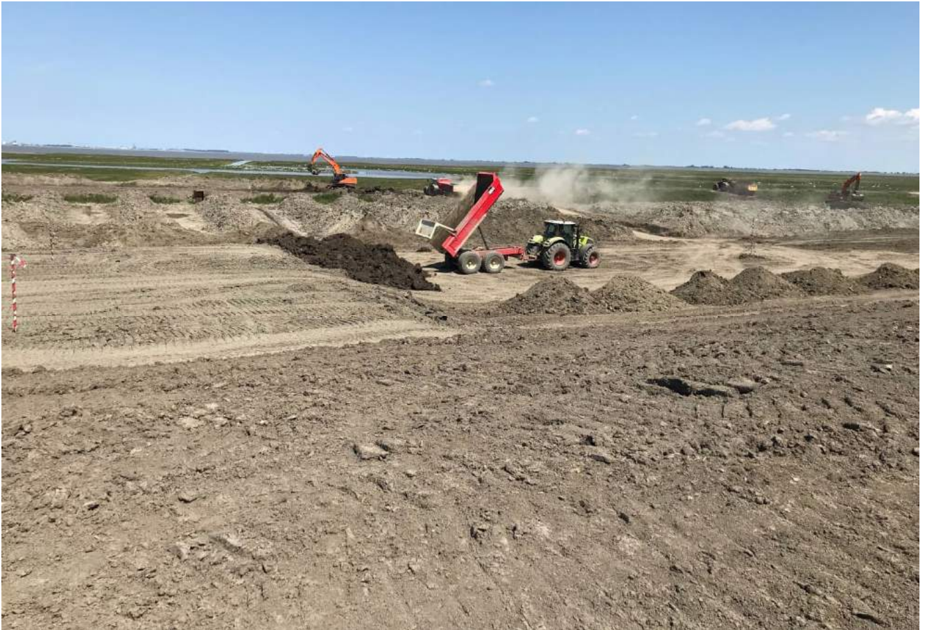
FIGUUR 23: VERWERKEN VAN DE EERSTE BREEBAARTKLEI OP HET BEWUSTE DIJKVAK (MEDIO JUNI)
