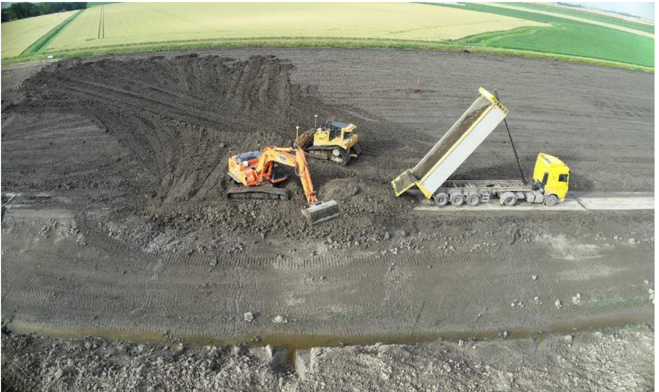
FIGUUR 26: VERWERKING VAN DE LAATSTE KLEI OP HET DIJKVAK VALGENWEG
