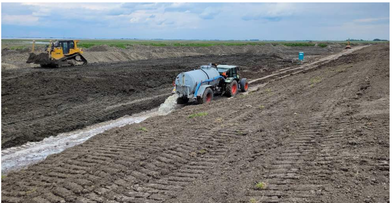
FIGUUR 13: INWATEREN VAN DE GRINDKOFFER
