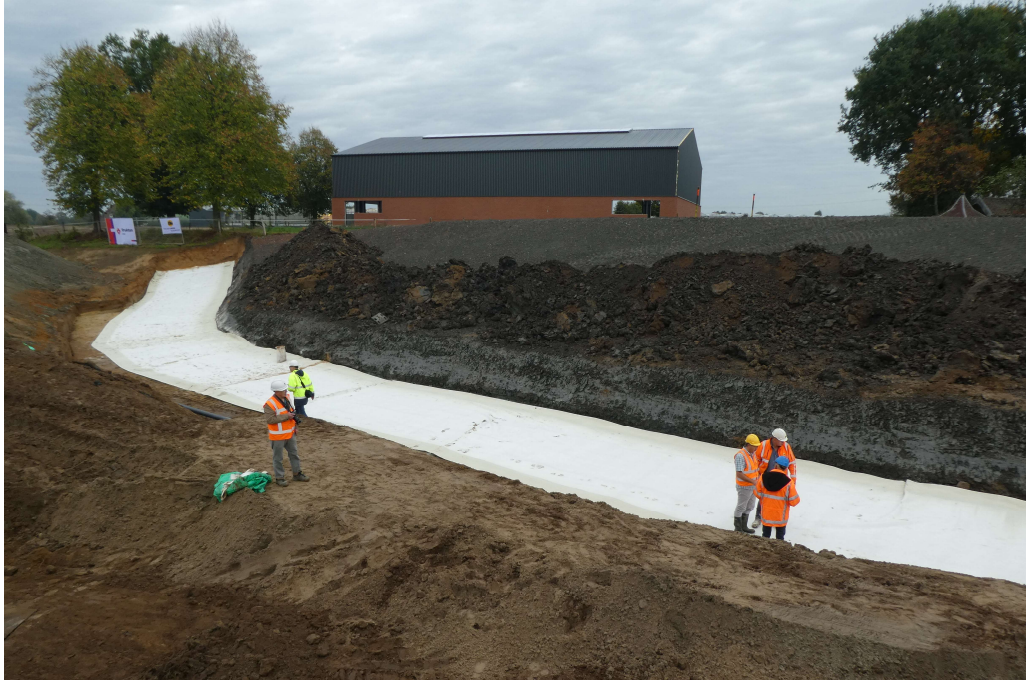
Figuur 1: aanleg bentonietmat of GCL in voorland bij Neer. (foto: "Wiel aan den Boom")
