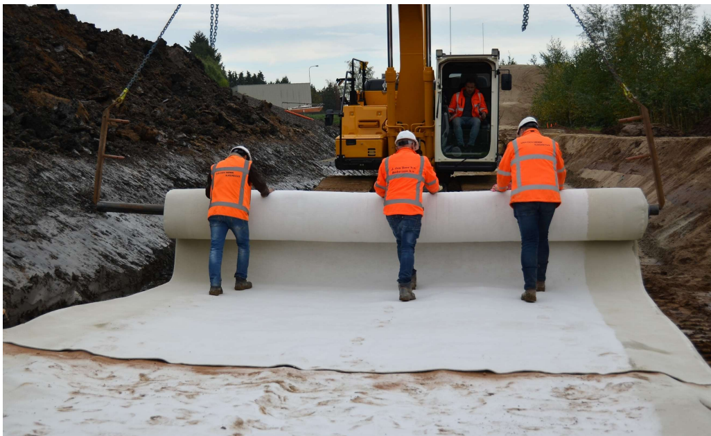
Figuur 2: afrollen van een bentonietmat of GCL in het voorland bij Neer. (foto: "Wiel aan den Boom")
