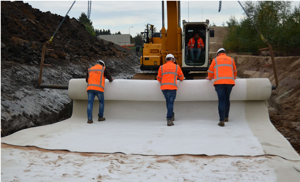
Figuur 19: uitrollen van GCL in voorland (foto: Wiel aan de Boom).
