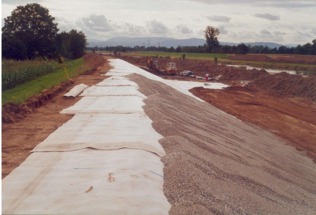
Figuur 15: aanbrengen grindhoudend grof zand (Kinzig dijken 2001).
