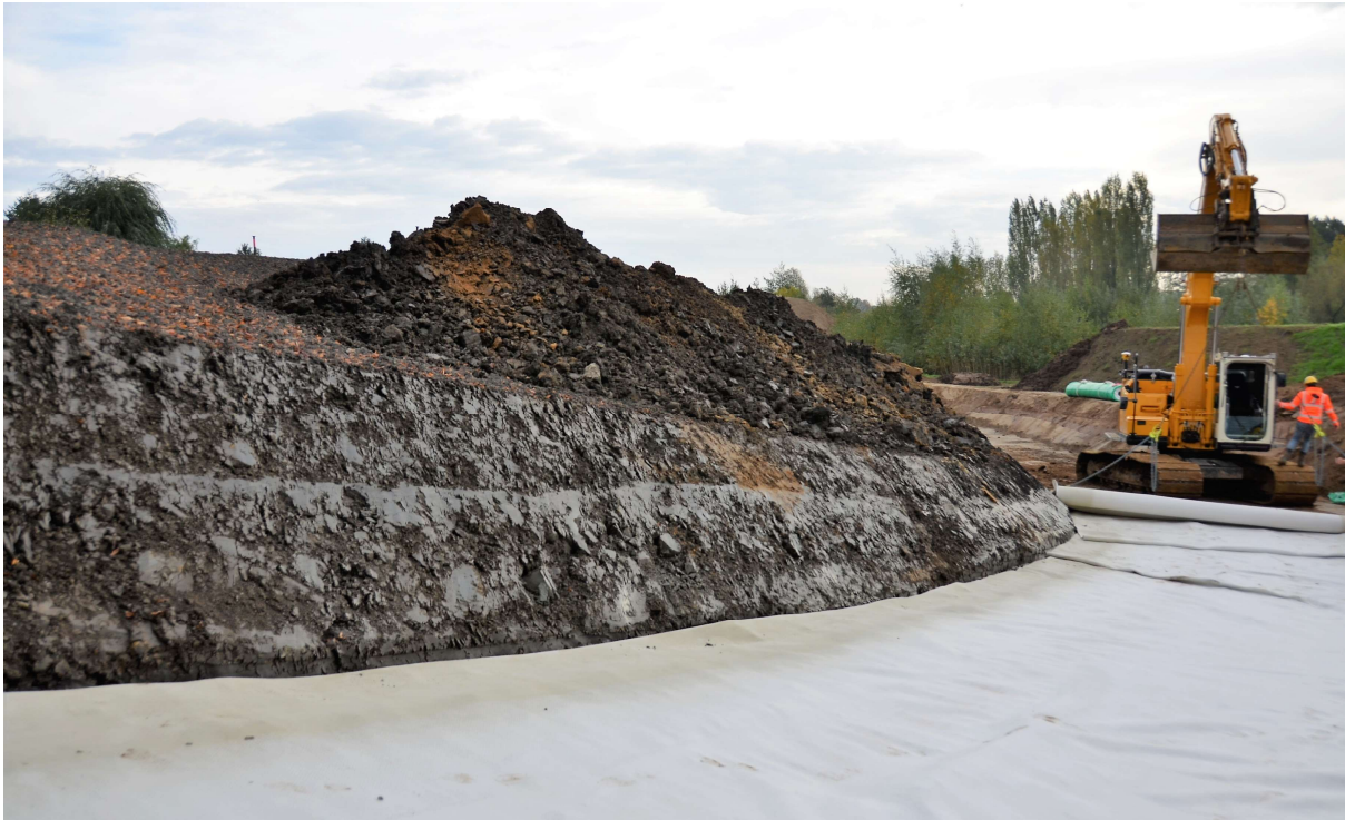
Figuur 20: de bocht om met GCL in voorland (foto: Wiel aan de Boom).
