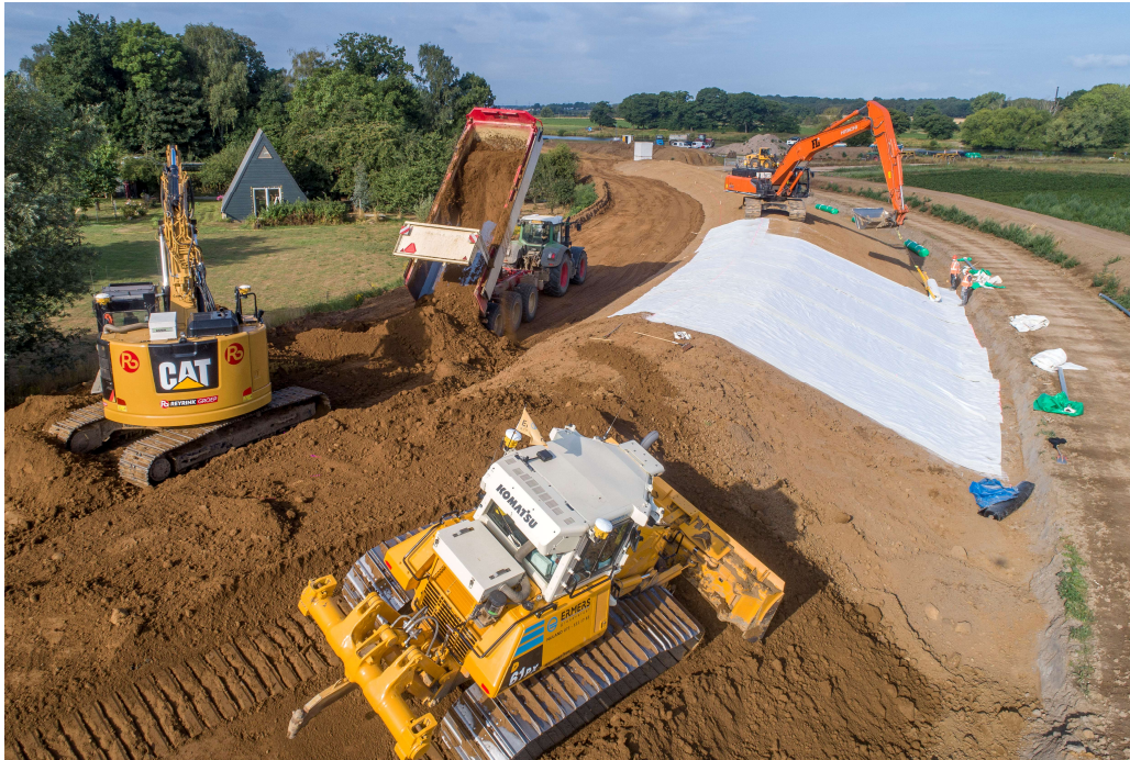
Figuur 31: verwerken gebiedseigen grond en GCL op dijk bij Beesel (foto: Wiel aan den Boom).
