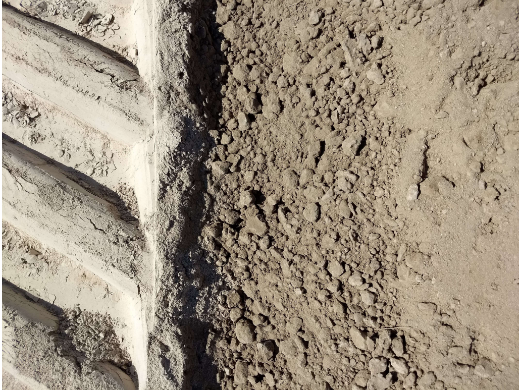
Figuur 33: stabilisatie toeslagstof (links) en gemengde grondlaag (rechts). (foto: Rimmer Koopmans)
