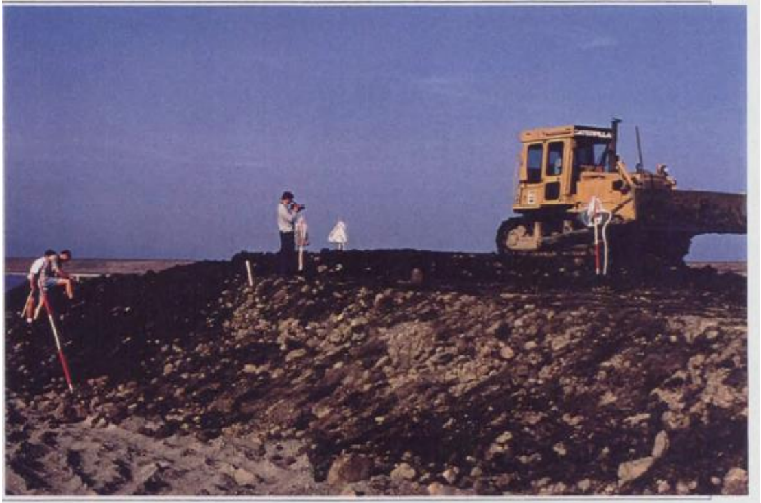
Figuur 2.16 Proefophoging Slufter - Aanlegfase 14 t/m 17 augustus 1995 [RWS1997].
