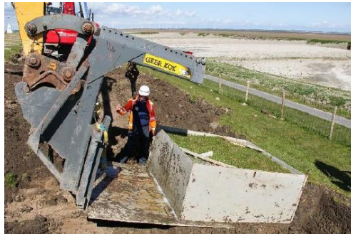
Eronder schuiven van de bodemplaat
