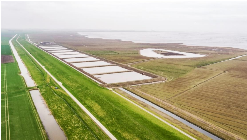
Figuur 1-4 Kleirijperij locatie kwelder. Ringdijken van depot gemaakt van klei uit de Klutenplas, verder op de kwelder
