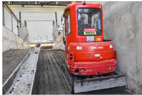
Verdichten van de klei met rupskraai
