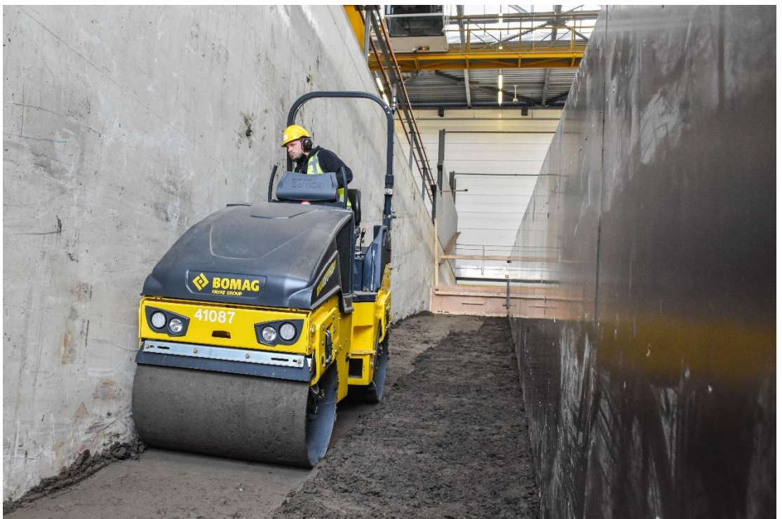
Figuur B.15 De Klutenplasklei is verdicht met een 2,5 tons wals.
