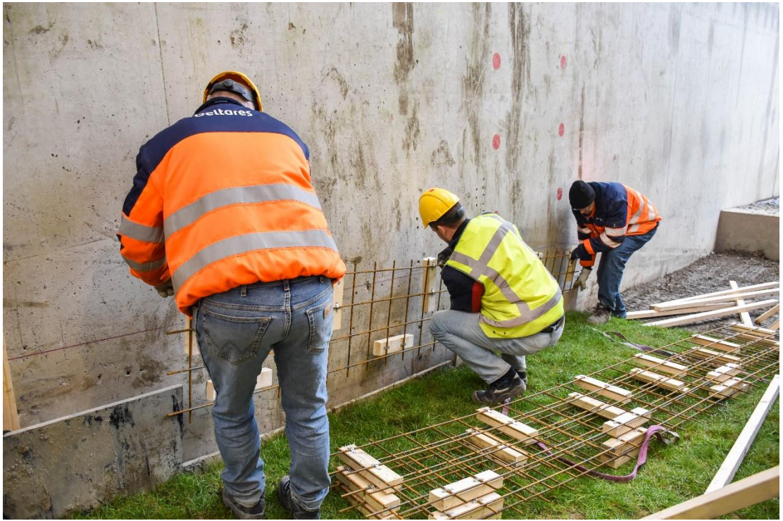
Figuur B.96 Plaatsen van wapeningsnetten tussen de kleiblokken en de gootwand.
