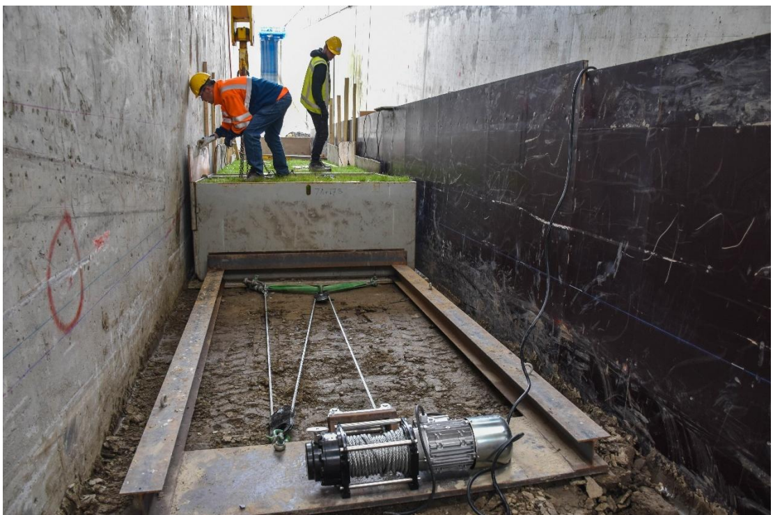
Figuur B.93 Lierframe met vertraging om de bodemplaet onder de mal uit te trekken.
