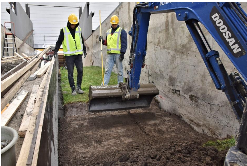
Figuur 3.17 Graslaag eraf schrapen met hydraulisch kraantje
