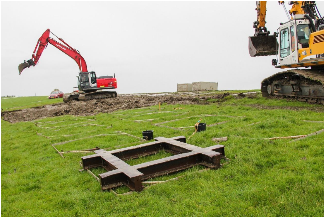
Figuur B.88 Gedrukte mallen in de dijk bij Blija voor de bovenblokken met grasmat.
