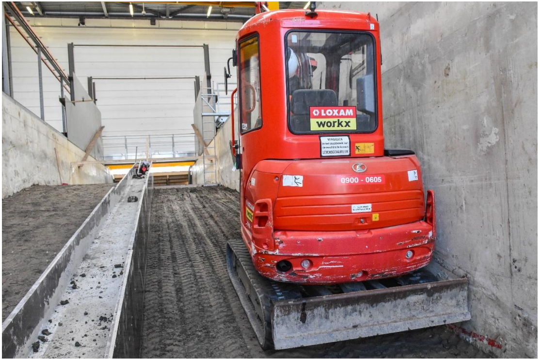
Figuur B.18 De klei aan de Valgenweg kant is grotendeels verdicht met de rupskraan. Dit gaf iets minder verdichting dan met de wals en maakte dat de verdichting beter klopte met de target.
