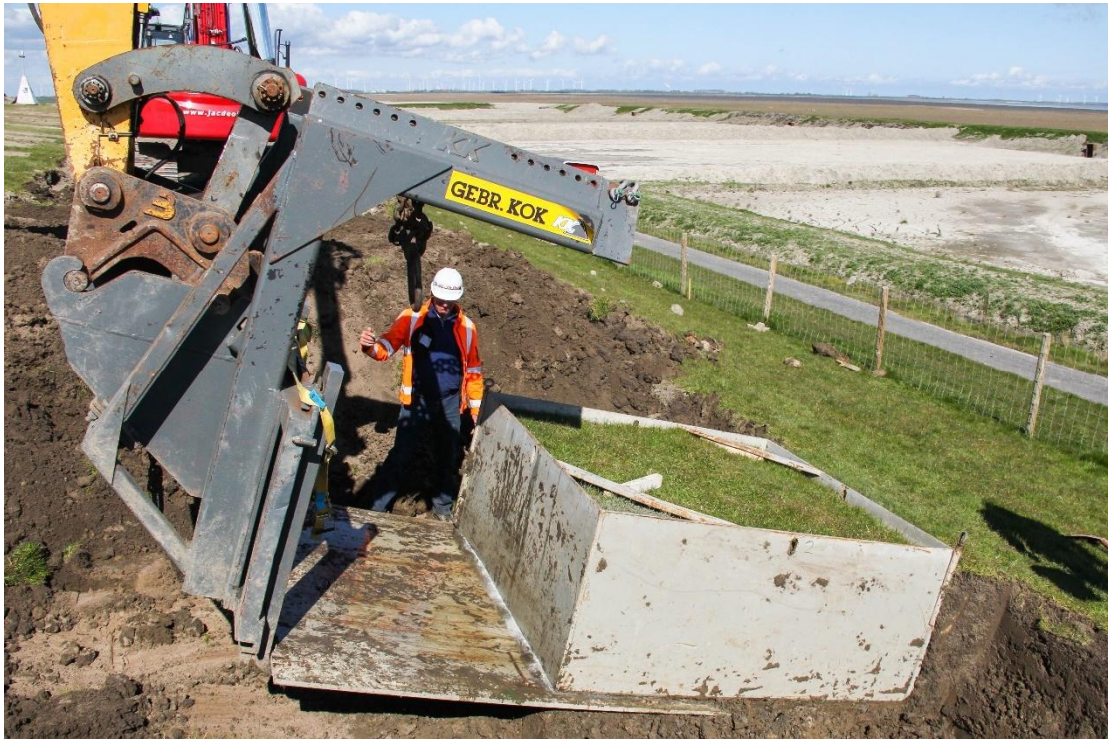
Figuur B.90 Steken van de bodemplaat onder de mal.
