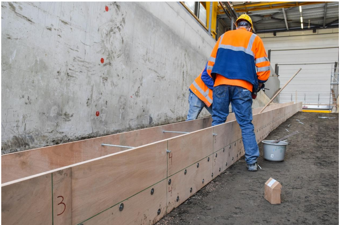
Figuur B.19 Langs de middenwand zijn platen gemonteerd. Deze hebben tot doel om het water van de brekende golven op de linker en rechter taludhelft van elkaar te scheiden.
