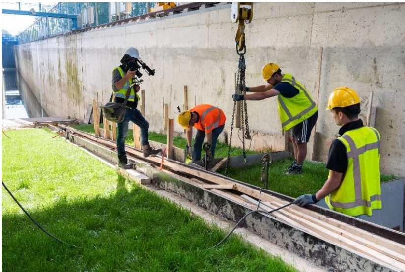
Figuur 3.16 Onderste zijmal eruit trekken
