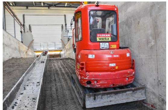
Figuur 2.10 Aanbrengen van de Klutenplasklei met grijper en verspreiden tot een laag met rupskraan.
