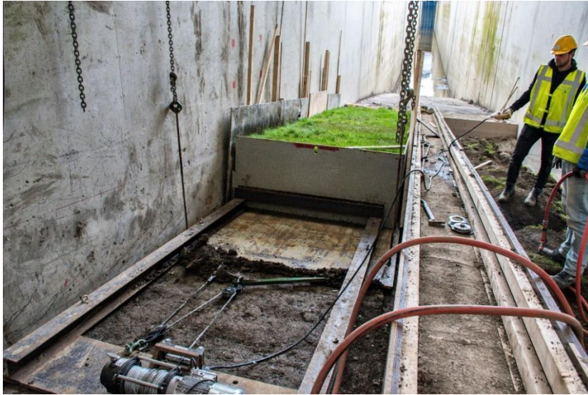
Figuur 3.15 Het eronder uittrekken van de bodemplaat
