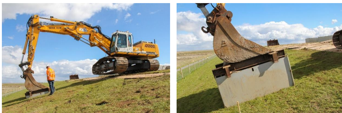
Figuur 3.10 Drukken van de zijwanden van de mal in het taludoppervlak.
