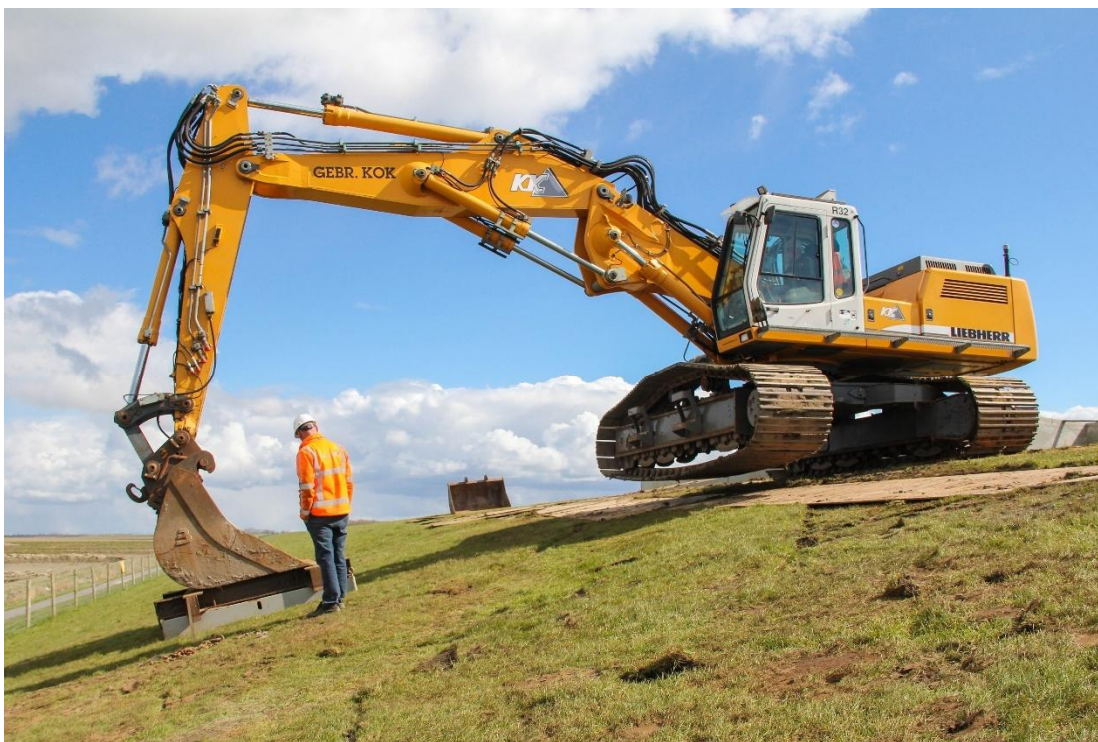
Figuur B.86 Drukken van de stalen mal in de Dollarddijk.
