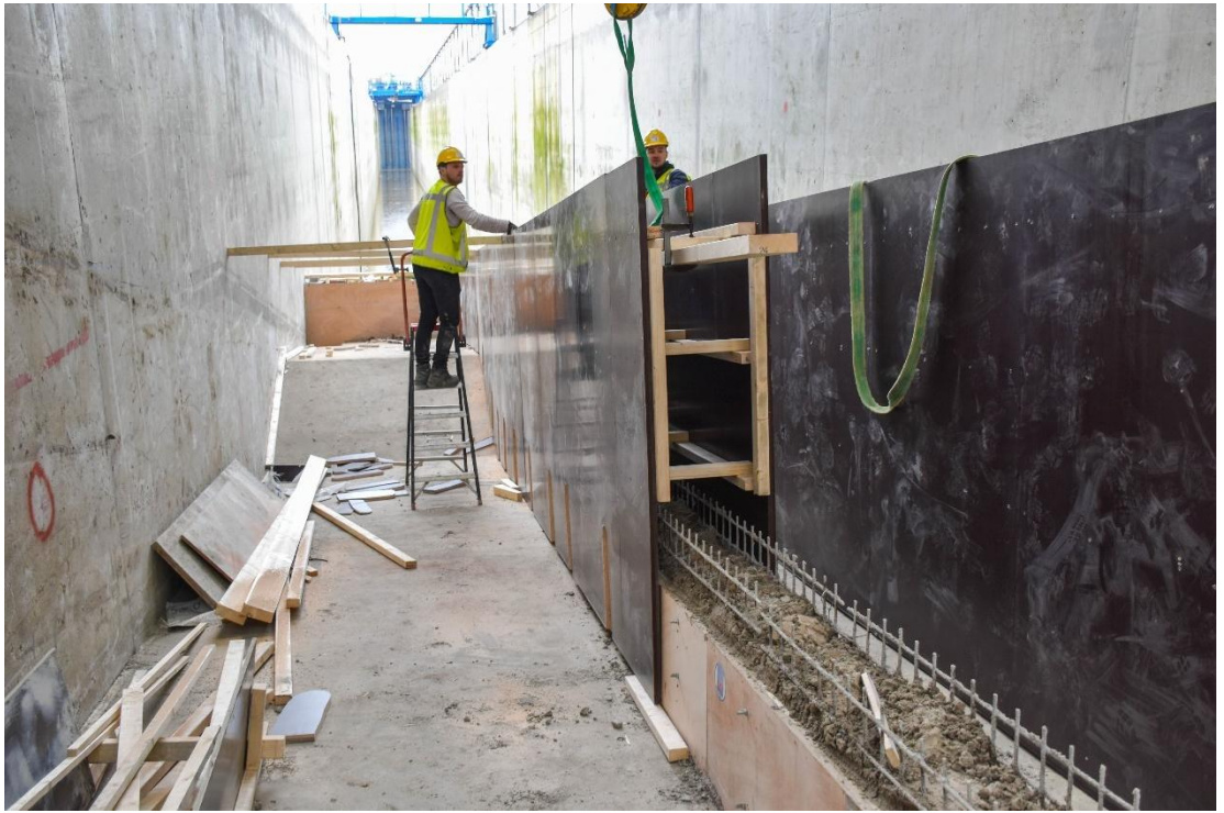
Figuur B.8 De middenwand is in delen geplaatst over het volgestorte onderste deel met wapening.
