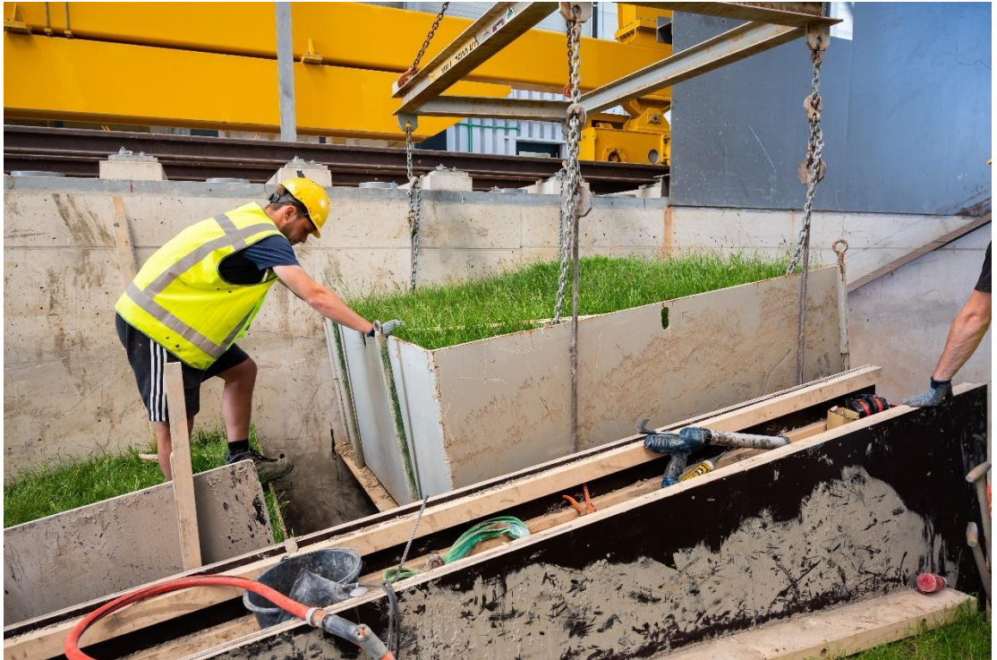
Figuur B.98 Plaatsing van het laatste kleiblok van de dijk bij Blija in de Deltagoot.
