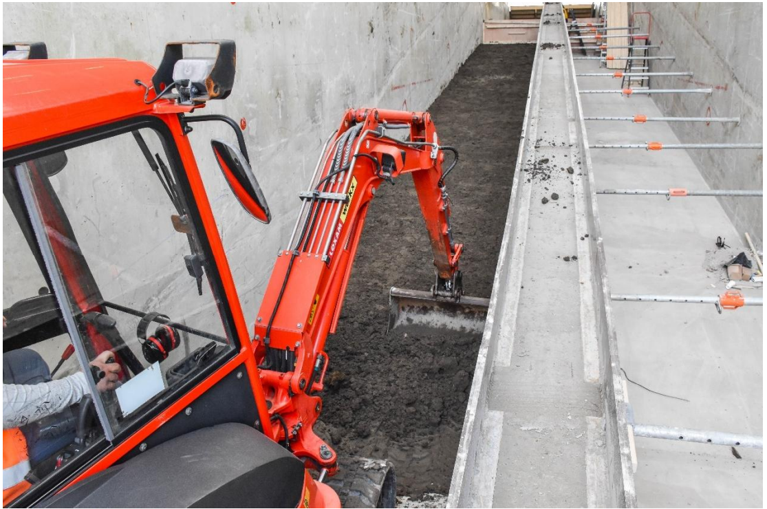
Figuur B.14 Als eerste is de Klutenplasklei in lagen aangebracht en verdeeld.
