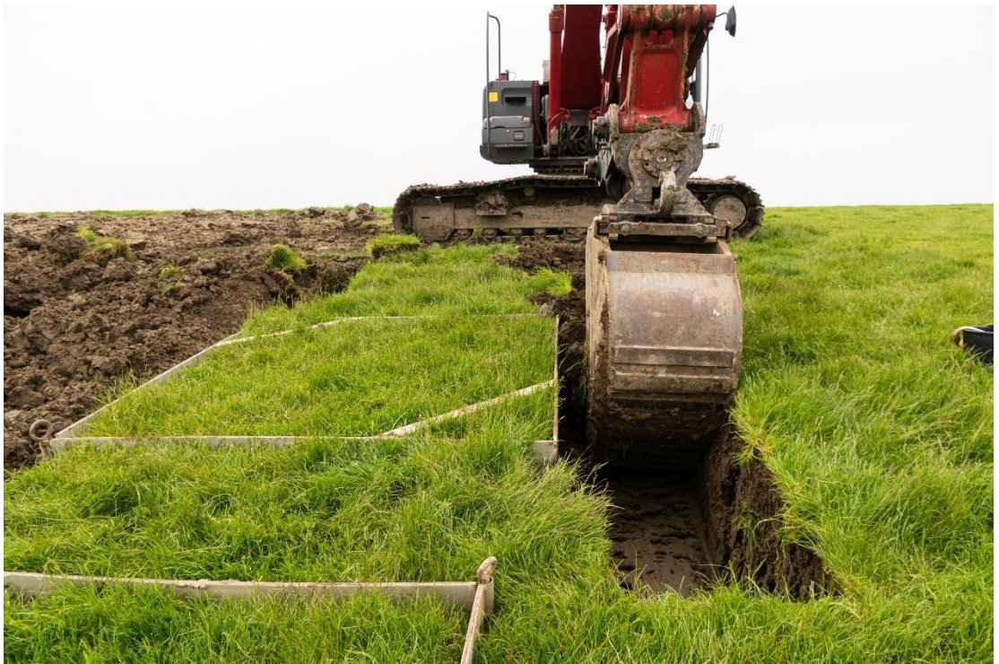
Figuur B.89 Rondom ontgraven van de stalen mallen.
