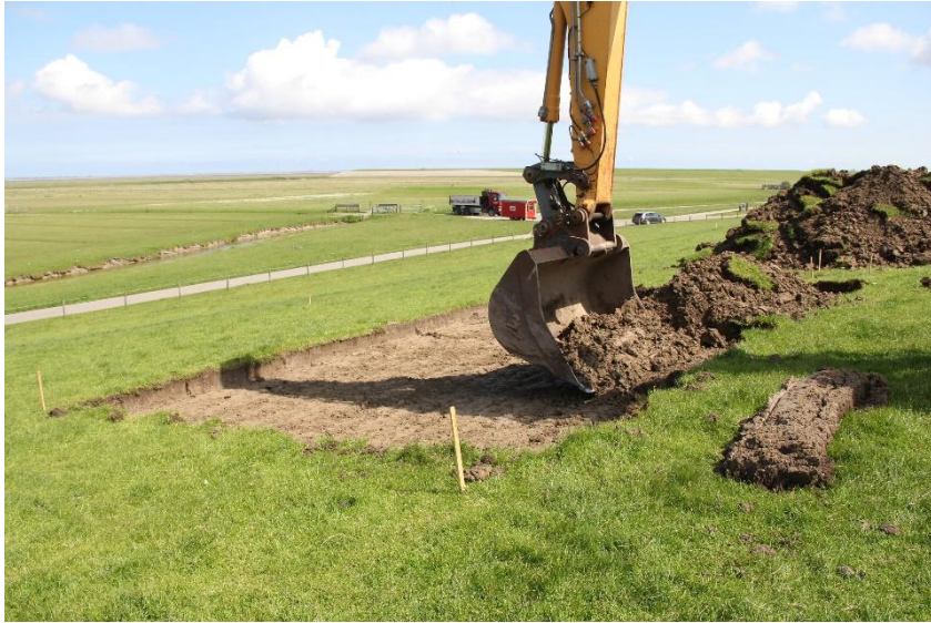
Figuur 3.12 Verwijderen graslaag voor het steken van de onderste kleiblokken van Blija
