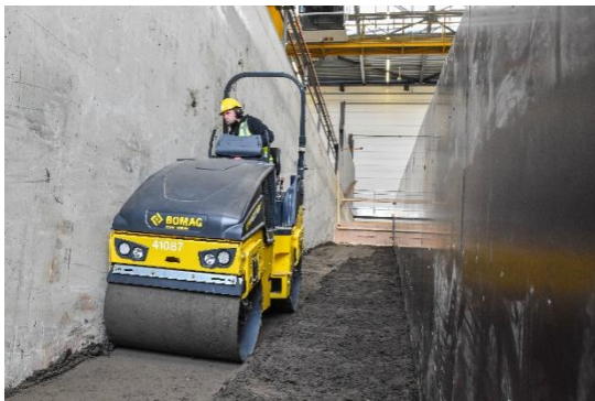
Figuur 2.11 Verdichten van de klei met wals en rupskraan.
