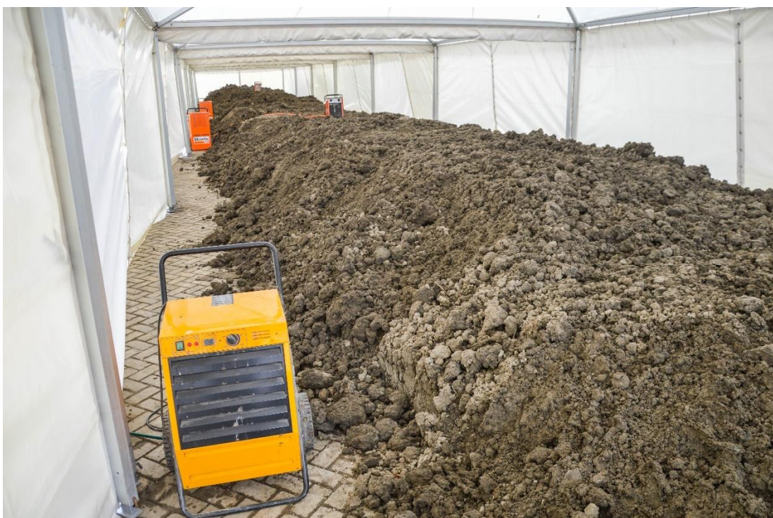
Figuur B.11 De klei van de Valgenweg had een te hoog vochtgehalte en is daarom gedroogd in een tent. In de tenten zijn meerdere elektrische kachels en ontvochtigers geplaatst.
