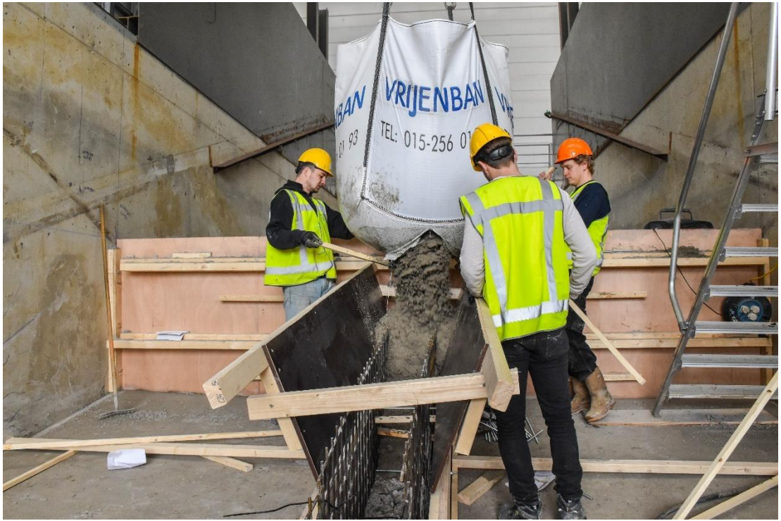
Figuur B.6 Rond de omhoogstekende wapening is een bekisting gemaakt die is volgestort met zandcement.
