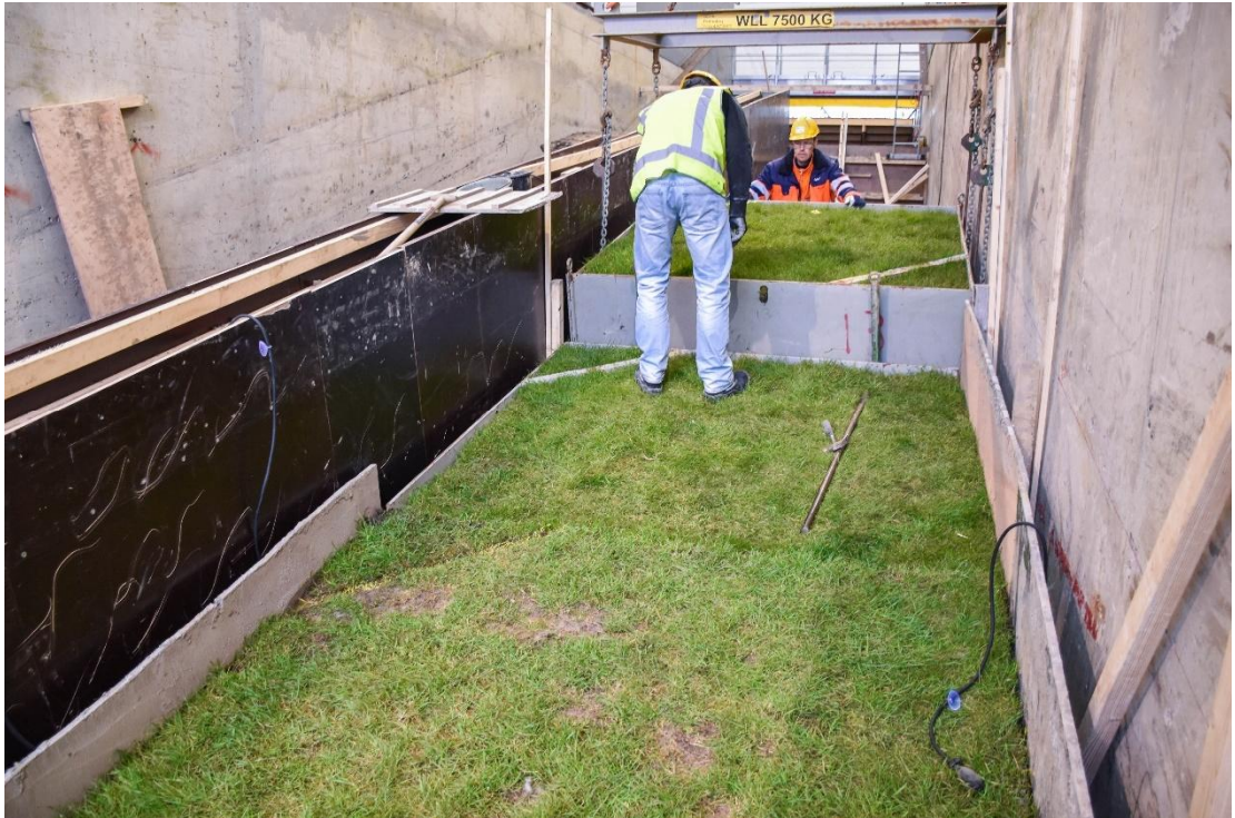
Figuur B.92 Plaatsen van kleiblok in de Deltagoot.
