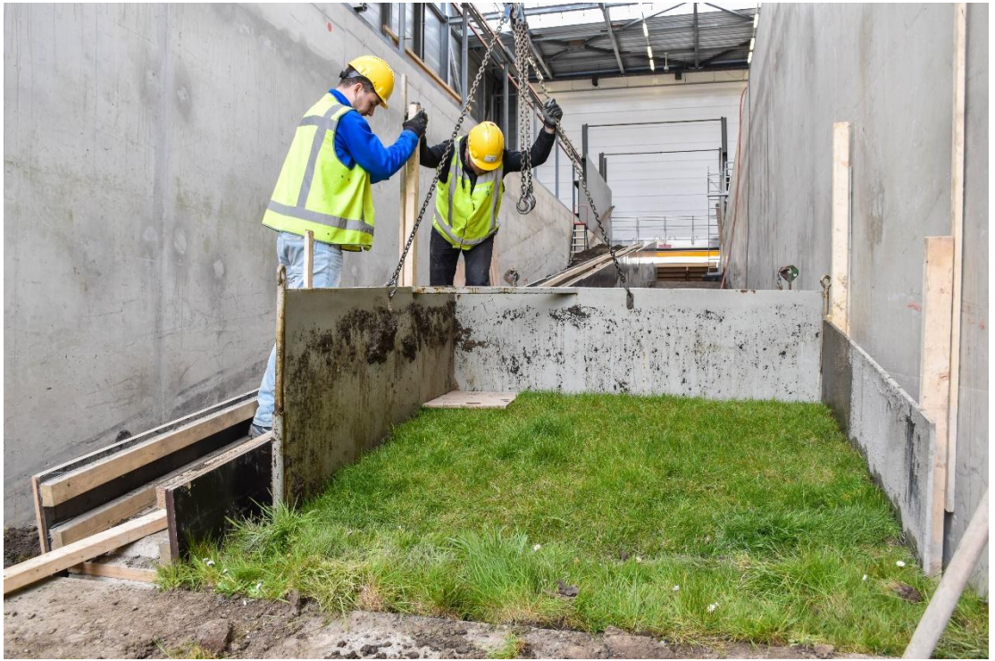
Figuur B.94 Trekken van een zijwand van de mal.
