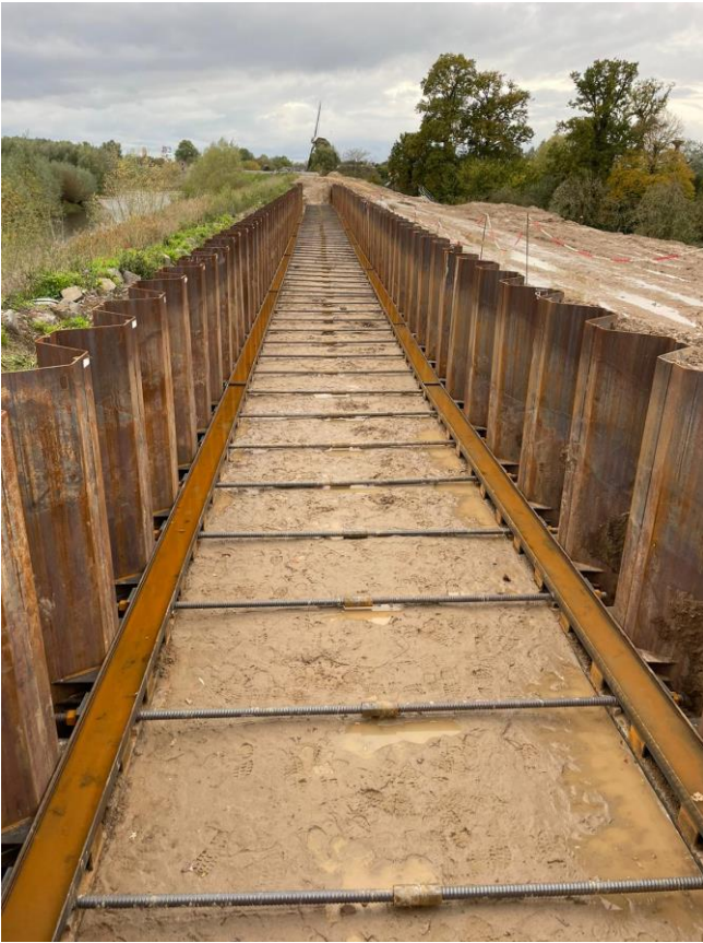
Figuur 9: Foto van de kistdam tijdens uitvoering
