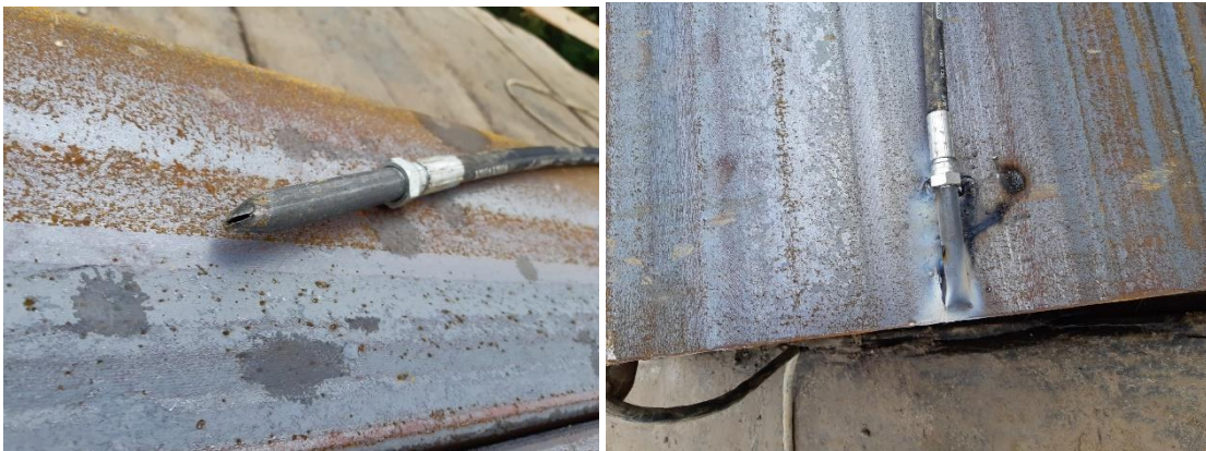
Figuur 5 Aangebrachte stalen nozzle en flexibele hogedrukslang op damwandplank
